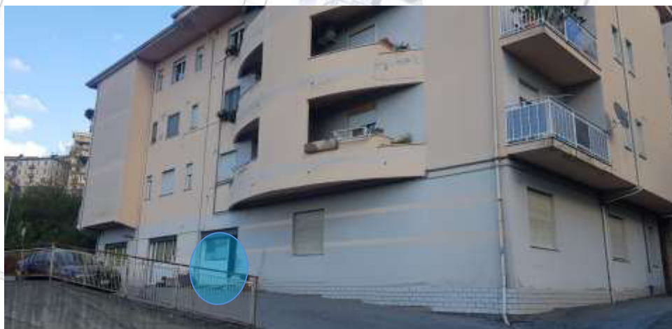
foto 1 – Vista prospettica fabbricato
