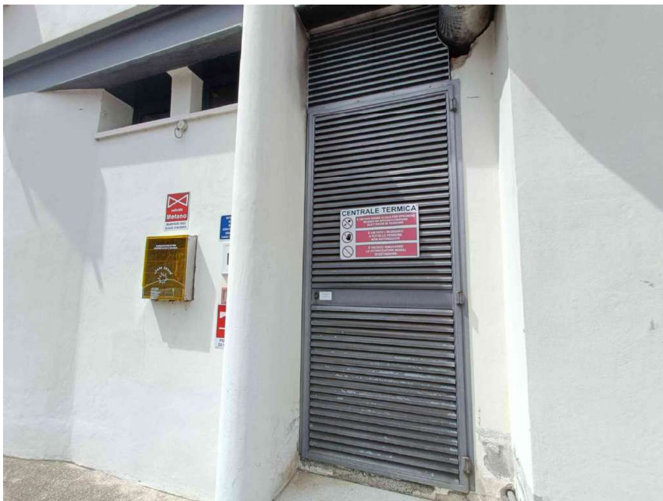
Foto 4 – Ingresso C.T. (prospetto Est)
