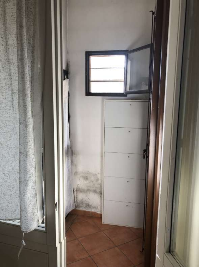
Foto 13- disimpegno alle particelle 1032 e 1033
