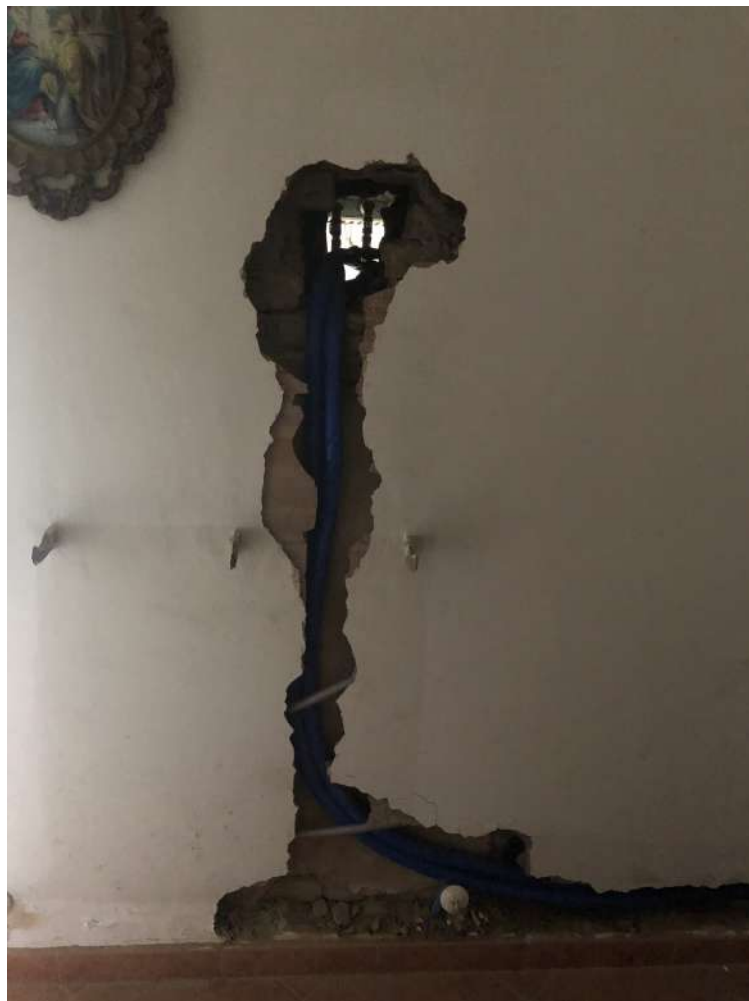
Foto 12 – camera da letto (dettaglio parete di confine con C.T.)
