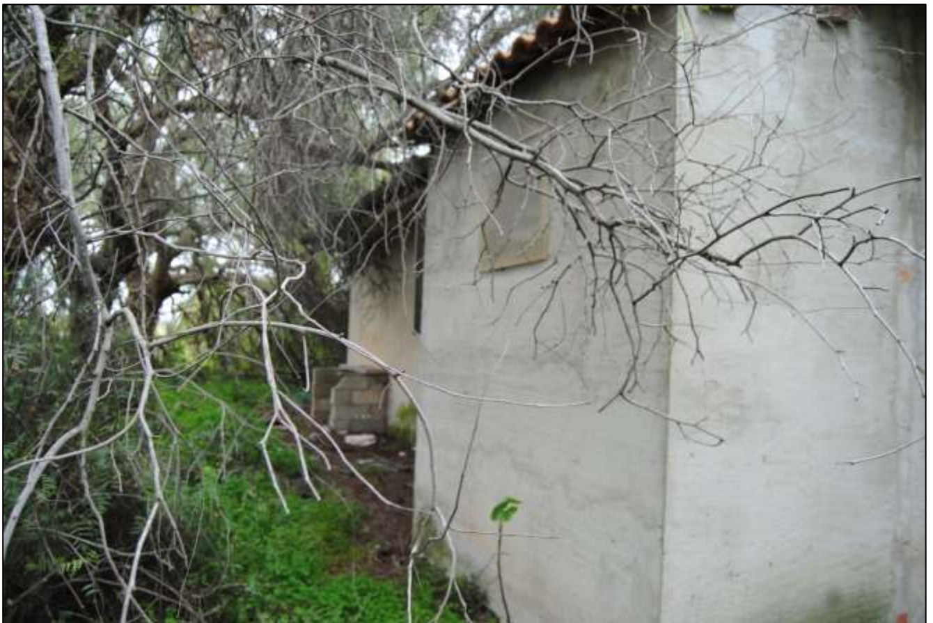
Foto n.8: Vista generale – Vista esterna Abitazione.
