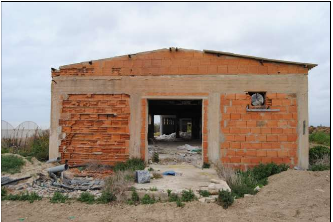
Foto n.16: Vista generale – Vista esterna Magazzino
