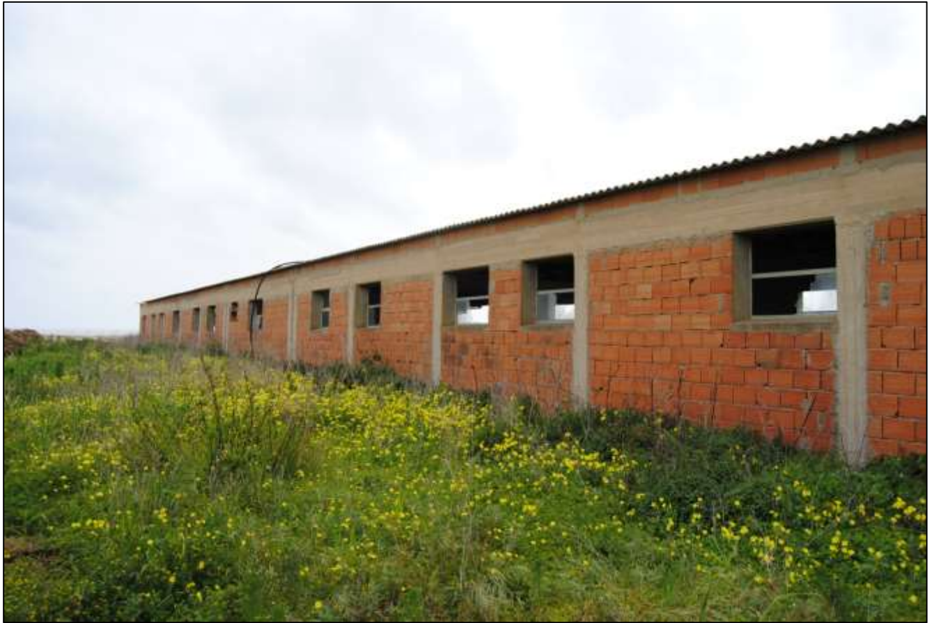
Foto n.15: Vista generale – Vista esterna Magazzino
