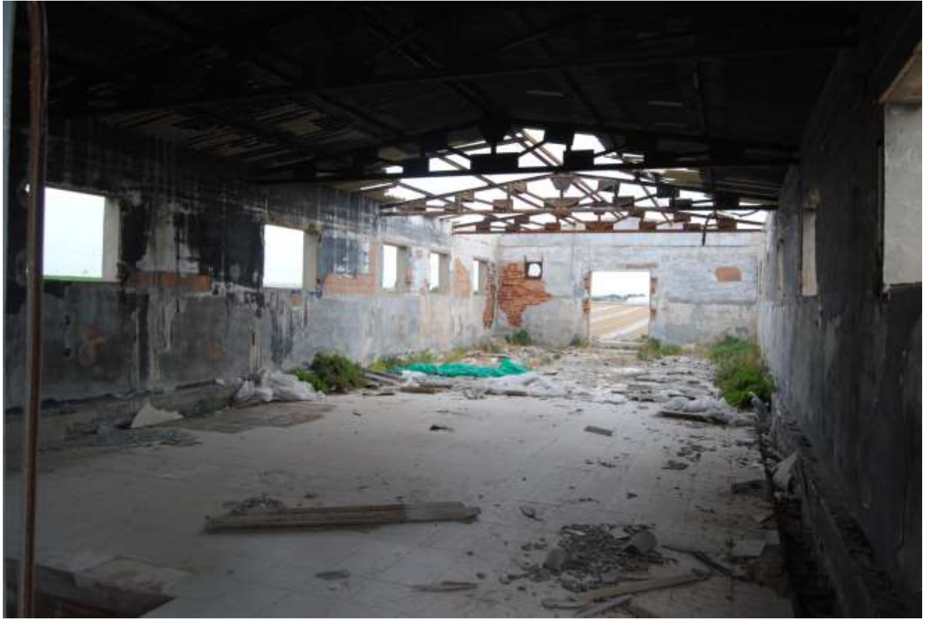
Foto n.21: Vista generale interna – Magazzino.
