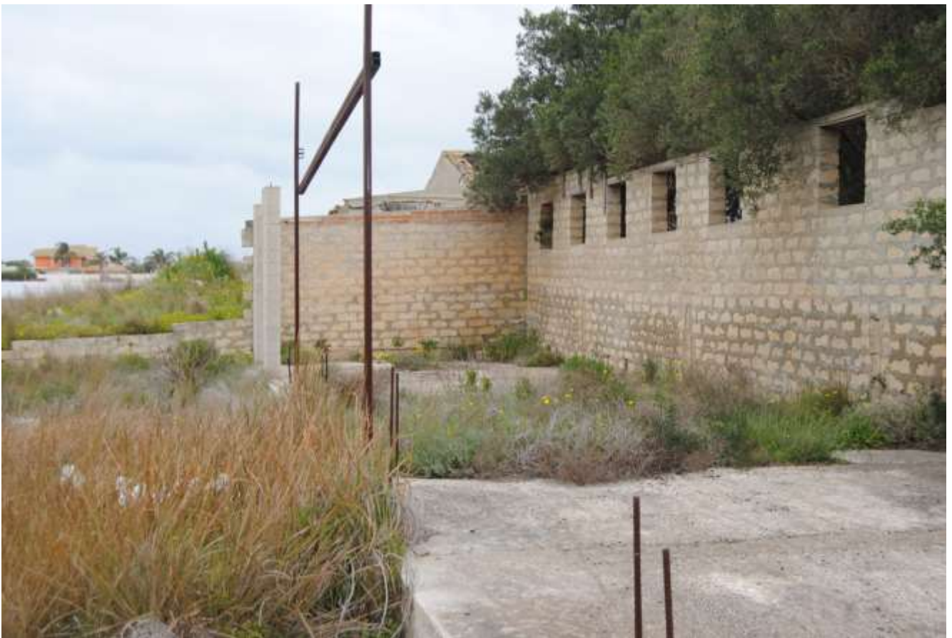
Foto n.24: Vista generale esterna.
