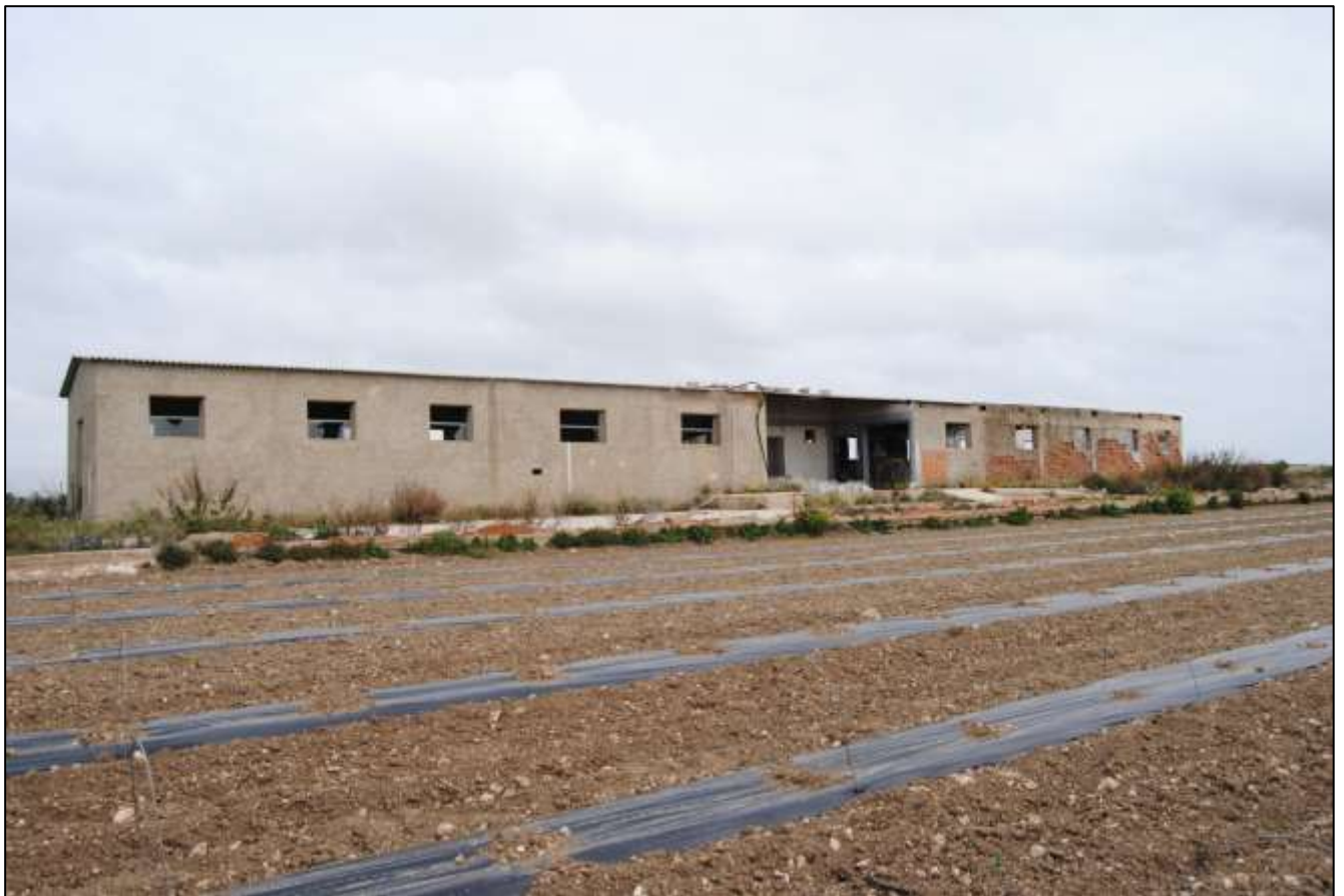
Foto n.14: Vista generale – Vista esterna Magazzino.
