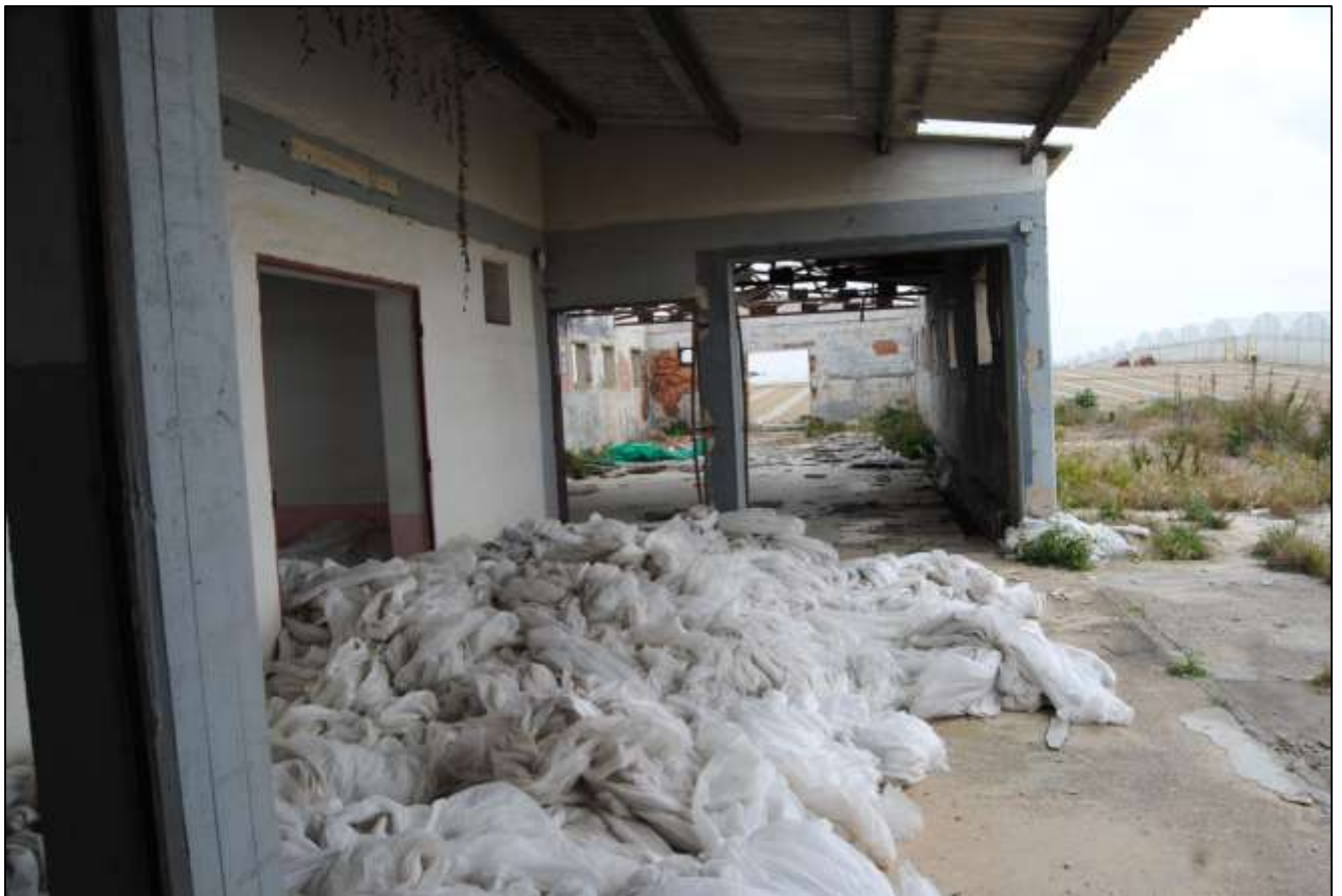
Foto n.20: Vista generale interna – Magazzino.
