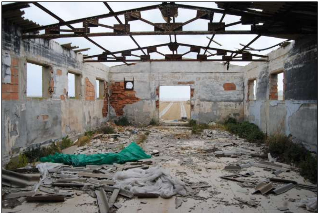
Foto n.22: Vista generale interna – Magazzino.
