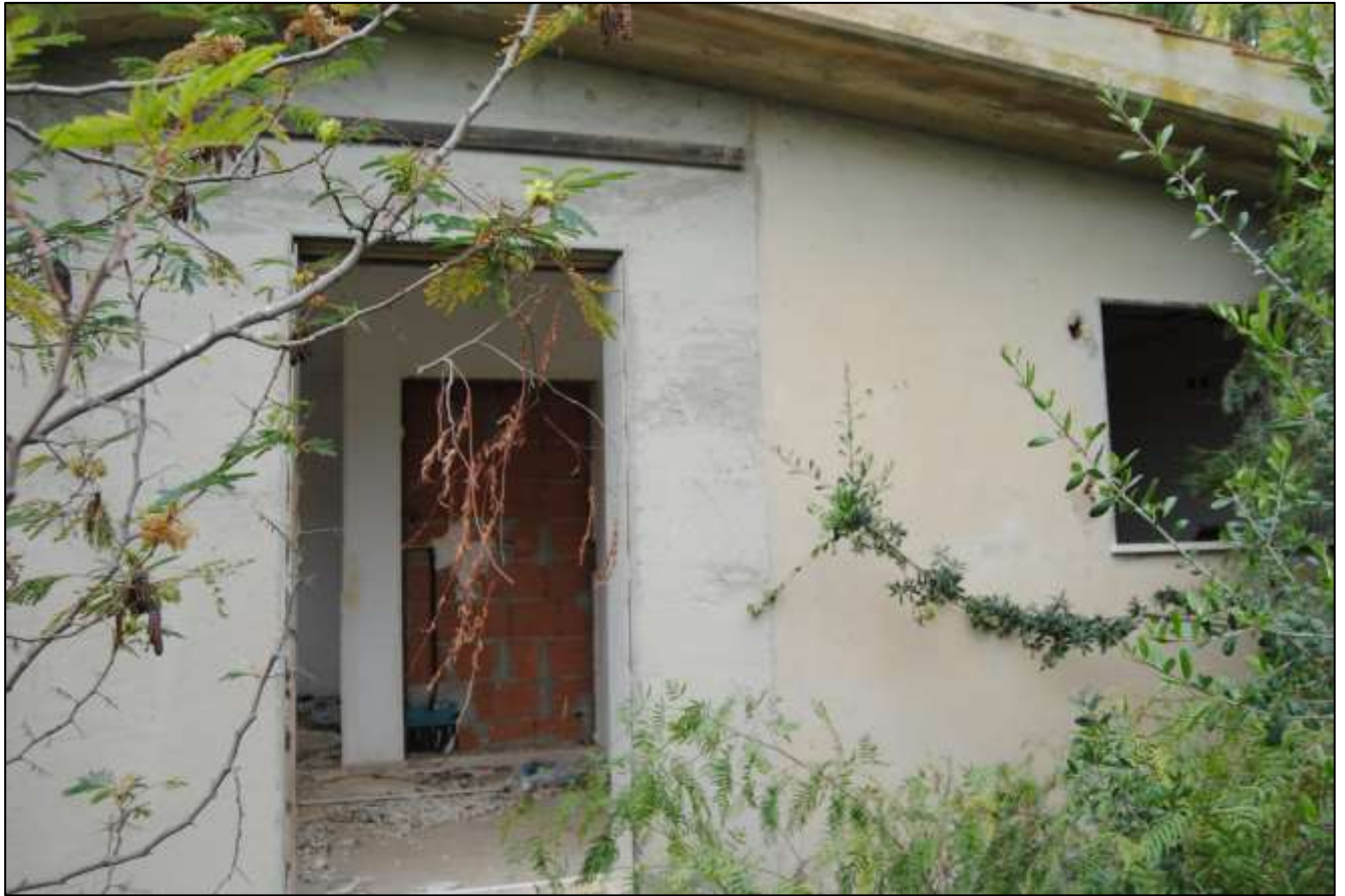
Foto n.5: Vista generale – Vista esterna Abitazione.
