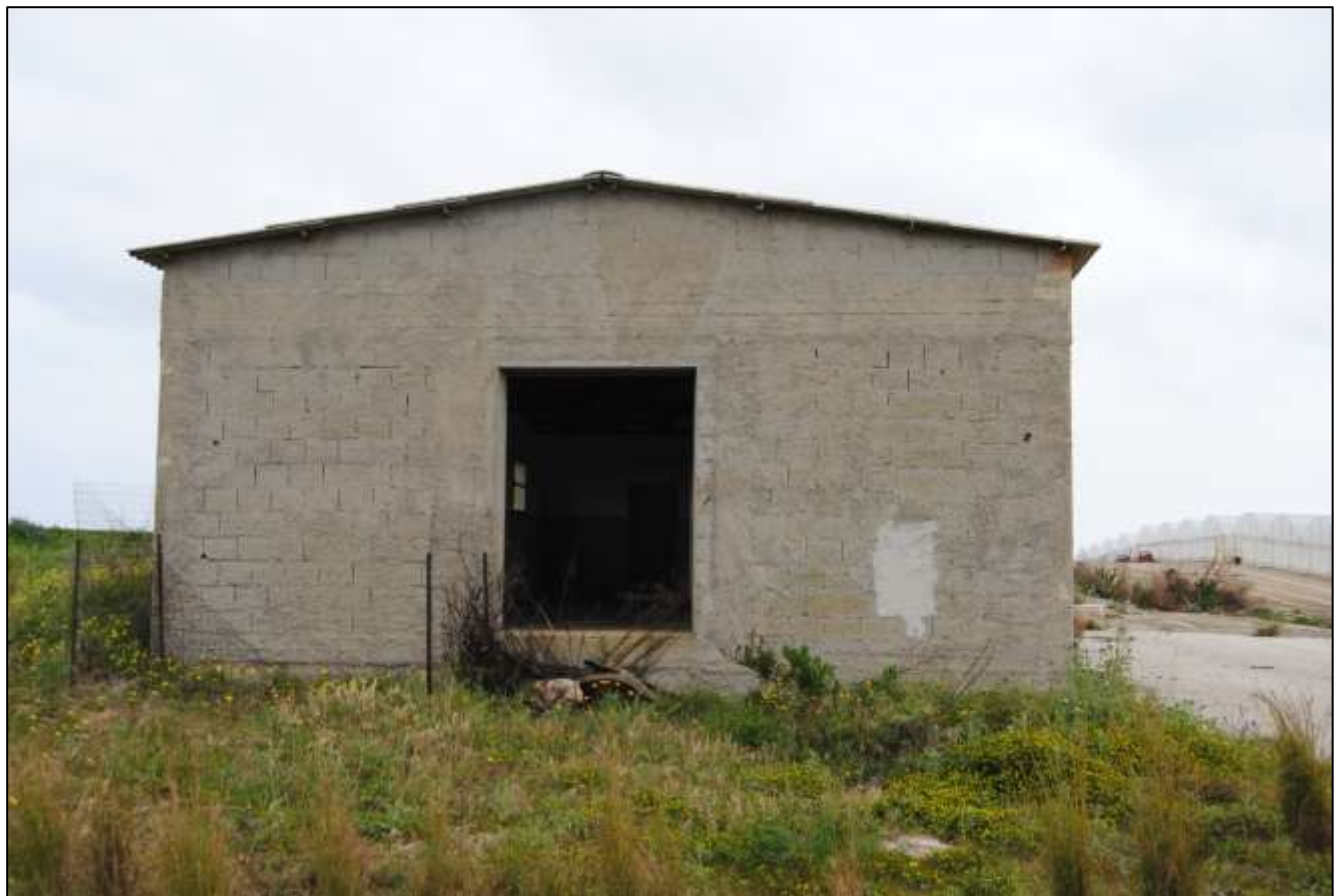
Foto n.18: Vista generale – Vista esterna Magazzino
