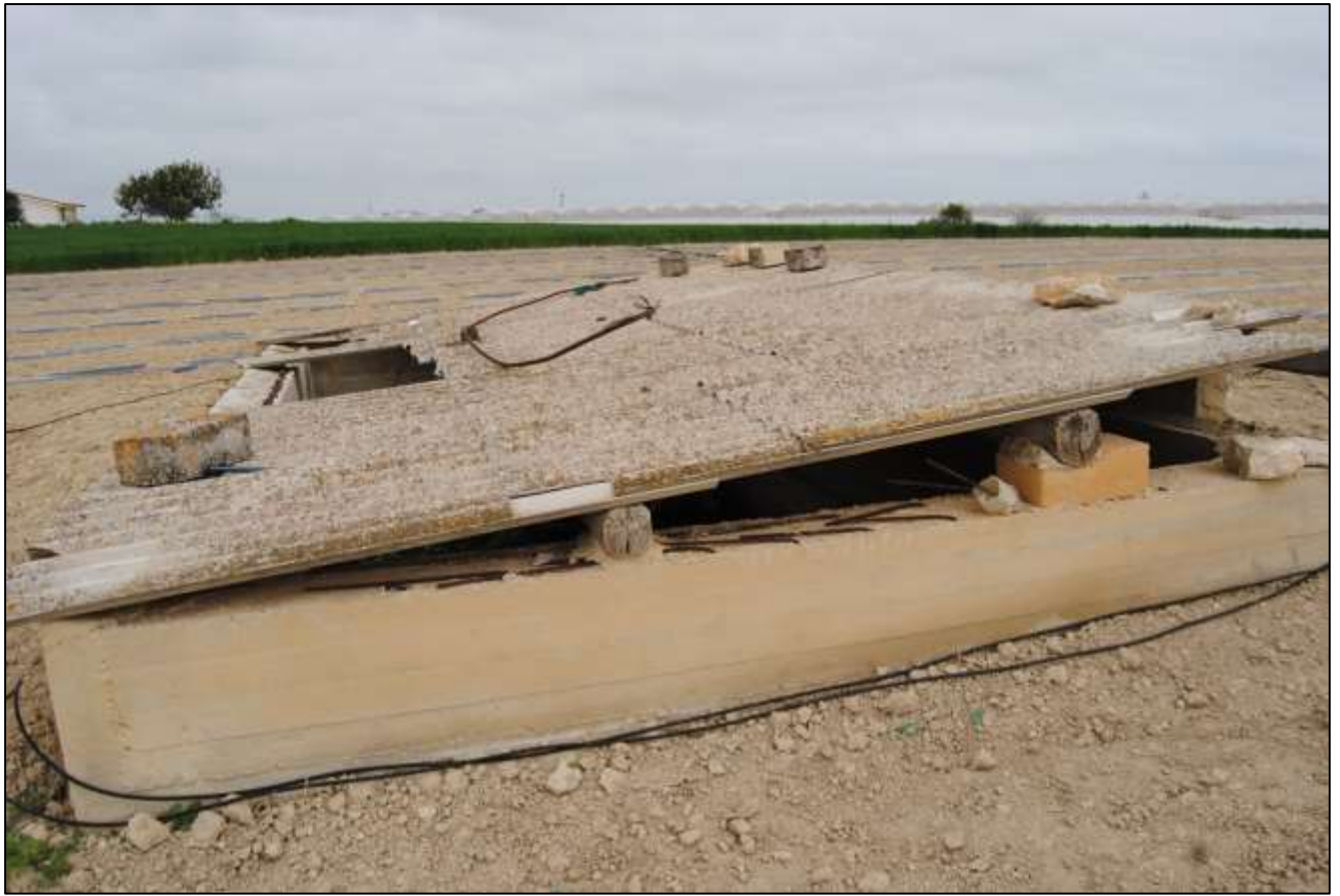
Foto n.23: Vista generale interna – Concimaia.
