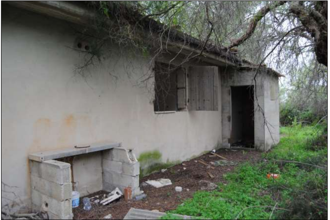
Foto n.9: Vista generale – Vista esterna Abitazione.
