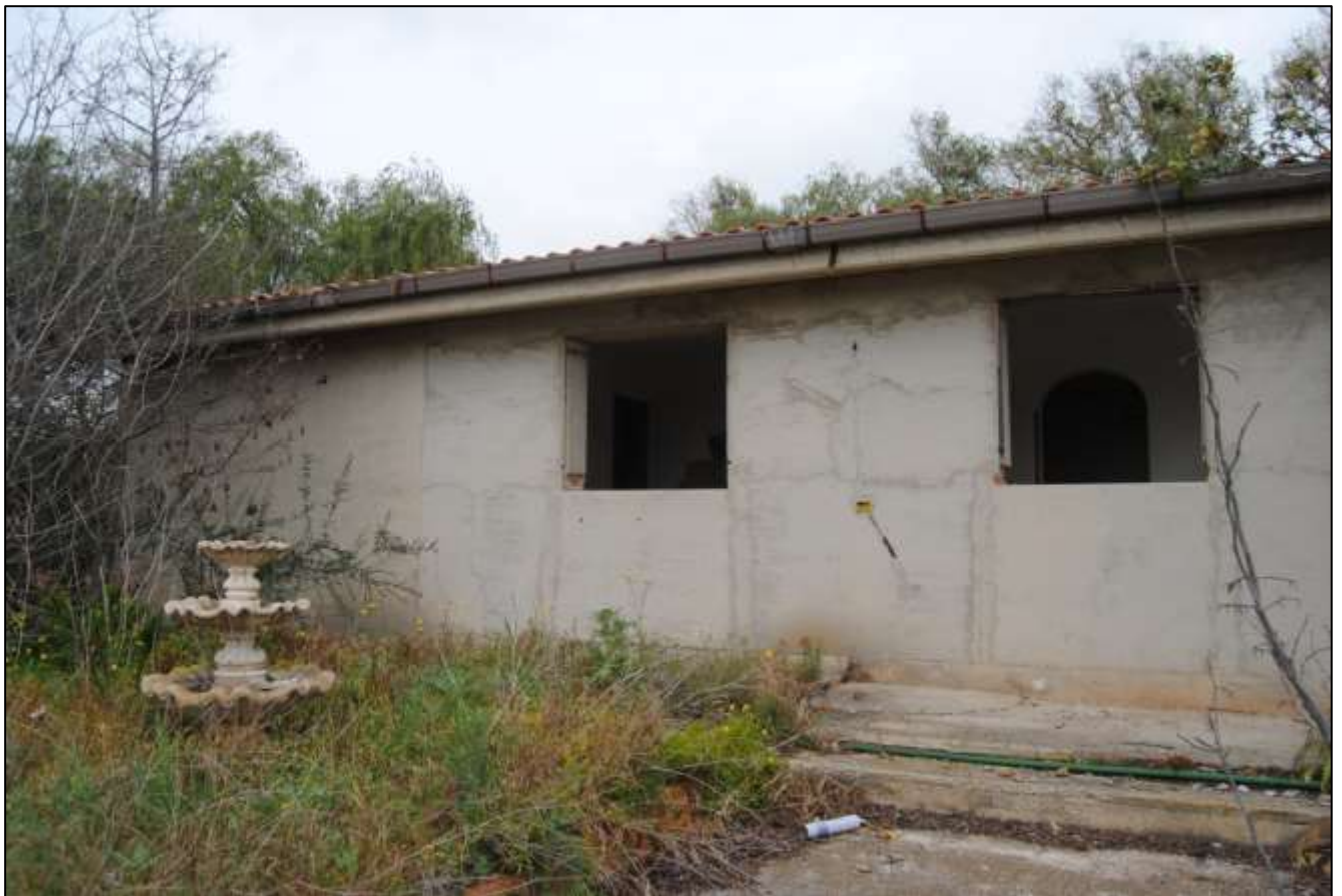
Foto n.6: Vista generale – Vista esterna Abitazione.
