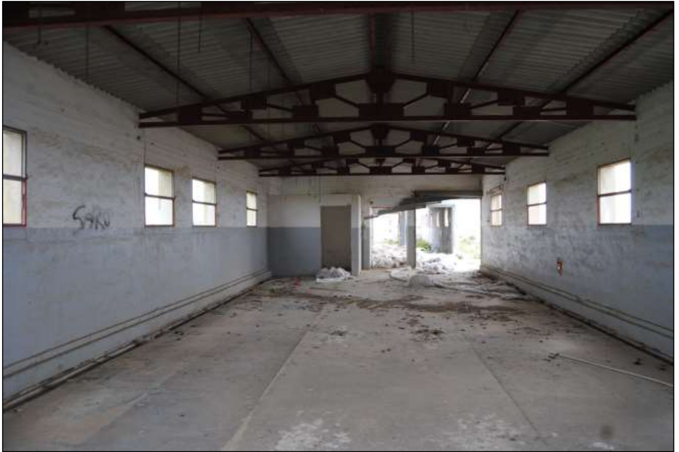
Foto n.19: Vista generale interna – Magazzino.
