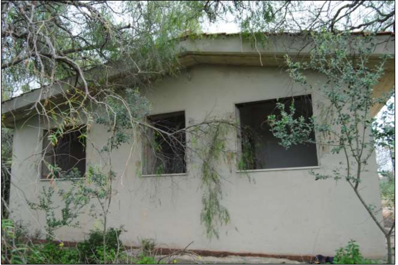
Foto n.7: Vista generale – Vista esterna Abitazione.
