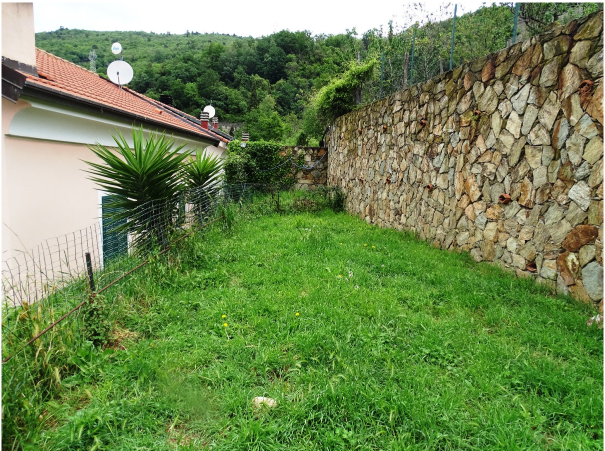
Il fabbricato oggetto di procedura: particolari degli esterni e della corte posteriore
