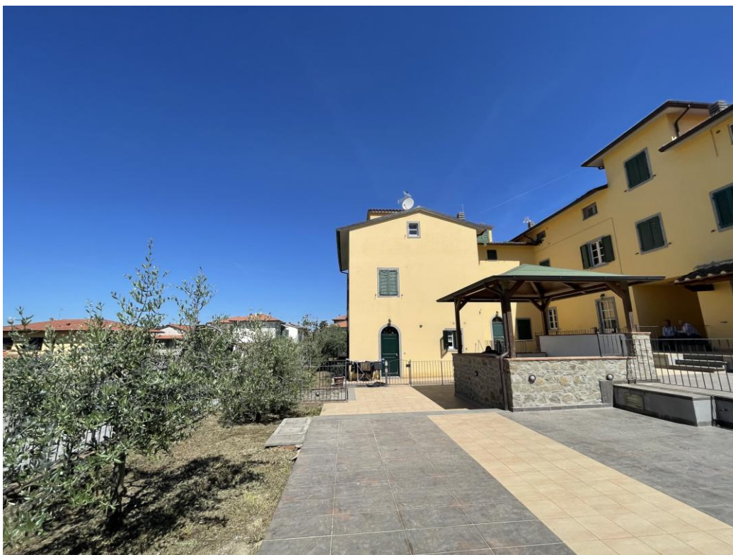
Foto 7 – ingresso lato sud
