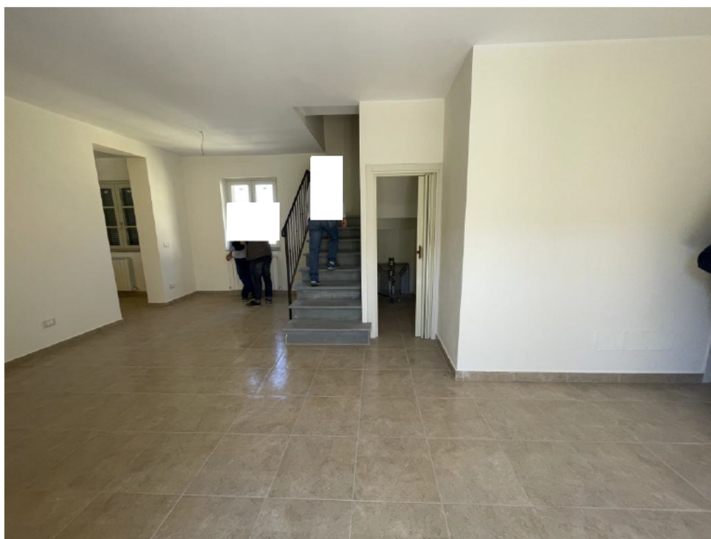
Foto 10 – interno unità immobiliare
