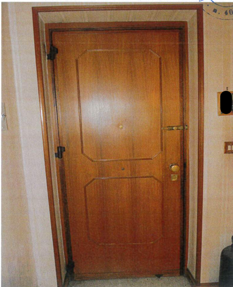
Vano porta d'ingresso Vista dall'interno
