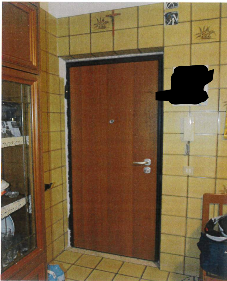
Vano porta d'ingresso secondario
