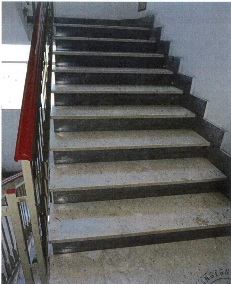
Vano scala condominiale
