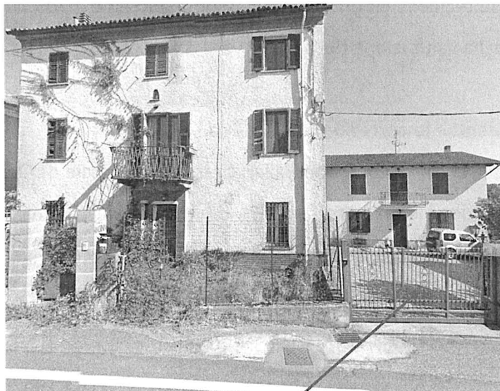
accesso carraio elettrocomandato di altra proprietà (diritto di passaggio)
