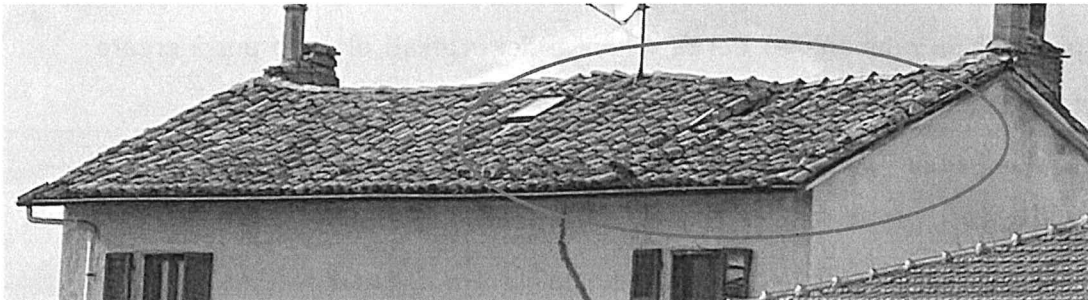
immagine della copertura già allegata alla precedente relazione
