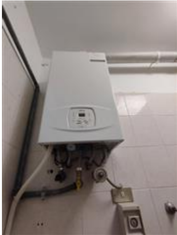
caldaia termo-sanitaria
