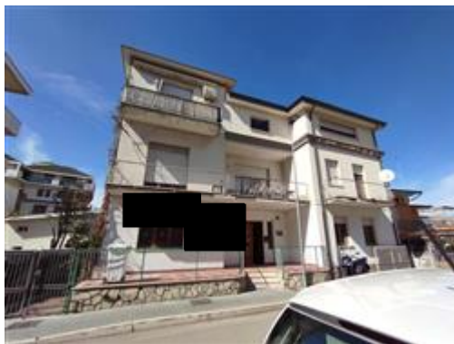
Vista fabbricato da Via Zara
