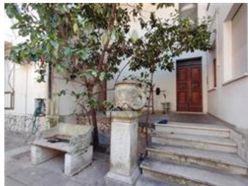
Ingresso civico n. 29
