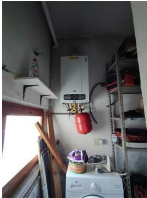
caldaia termo-sanitaria
