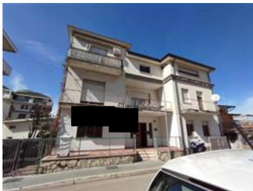
Fronte fabbricato da Via Zara
