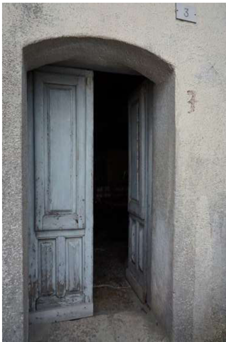
Fig.15 – Accesso vano deposito da vico IV San Pietro al civico n.3
