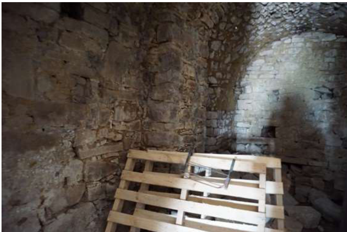
Fig.13 – Ambienti vano deposito
