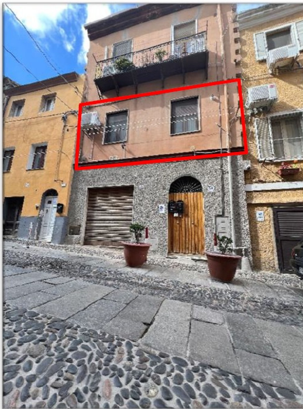
Foto 1 – Stabile di ubicazione unità oggetto di procedura
