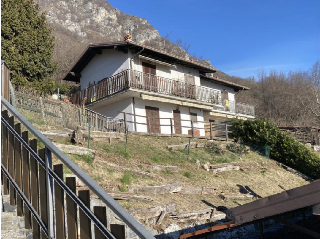
ENDINE GAIANO - VISTA EDIFICIO IN CUI E' ALLOCATA L'UNITA' IMMOBILIARE
