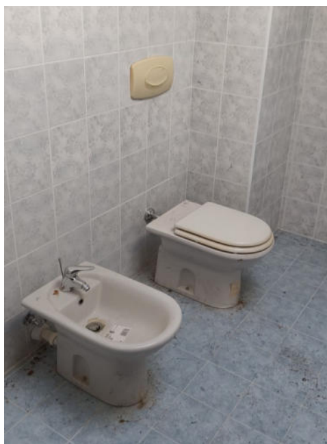
CASTEGGIO- VISTA BAGNO
