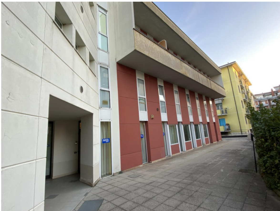
ROMANO DI LOMBARDIA - VISTA EDIFICIO IN CUI E' ALLOCATA L'UNITA' IMMOBILIARE
