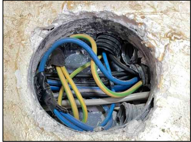
Interno di una cassetta di derivazione
