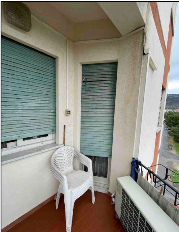
Balcone su via I.Mormino
