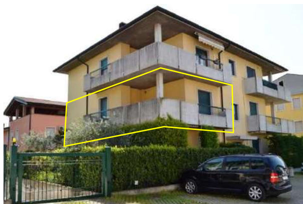
foto 8 - prospetti nord e ovest fronte strada del condominio La Primula in via Vicenza 1/C, Caldiero
