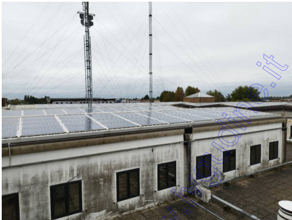
Particolare della copertura con ineriti i pannelli di FTV
