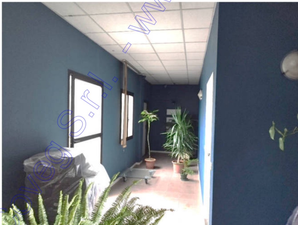
Particolare ingresso su andito comune condominiale P1°
