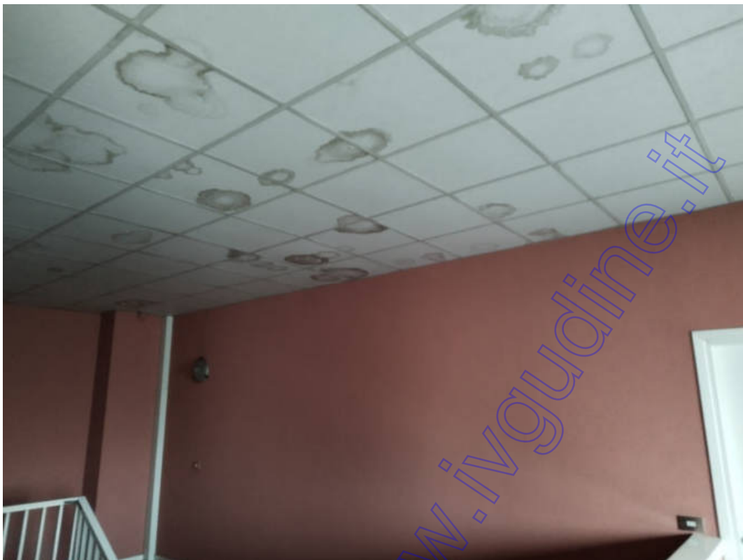
Particolare ingresso su andito comune condominiale P1°
