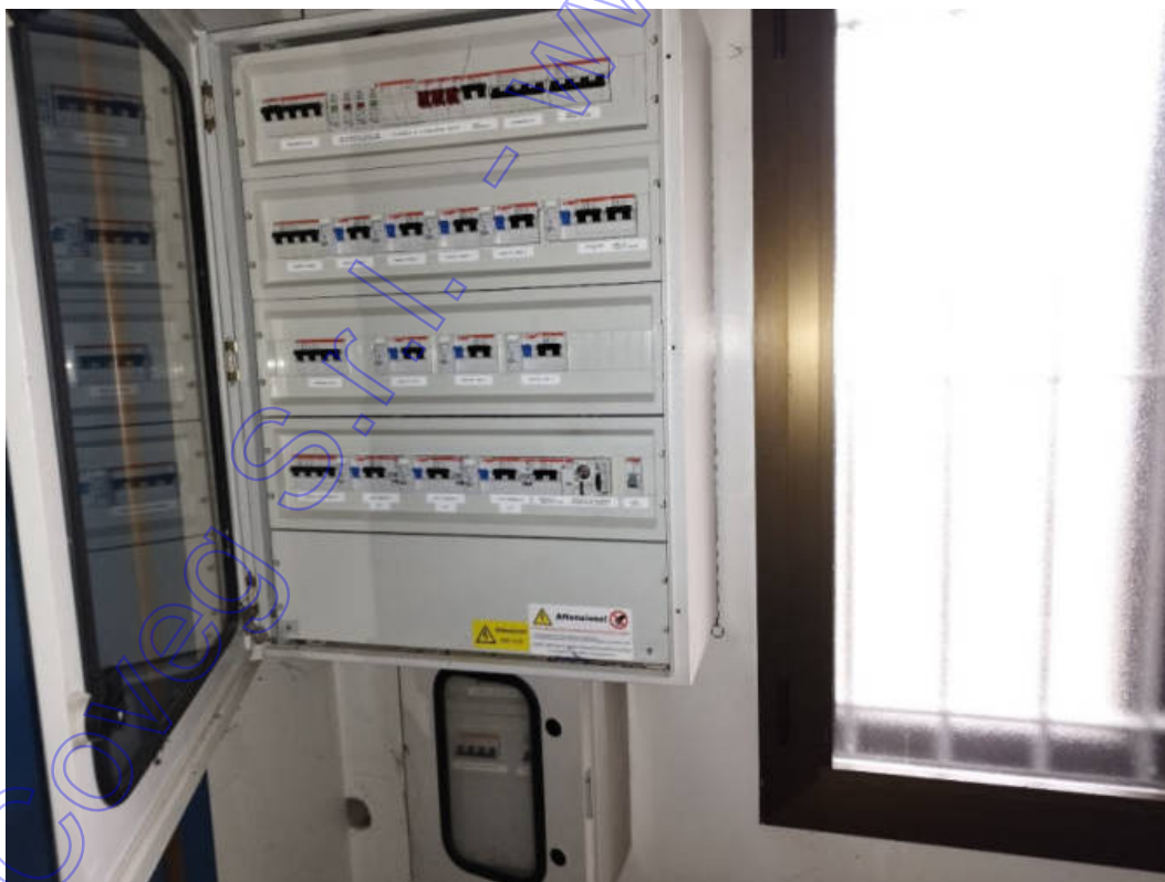
Particolare comandi impianto di riscaldamento/raffrescamento
