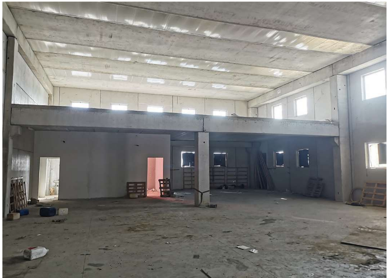
Prospetto laterale sud
