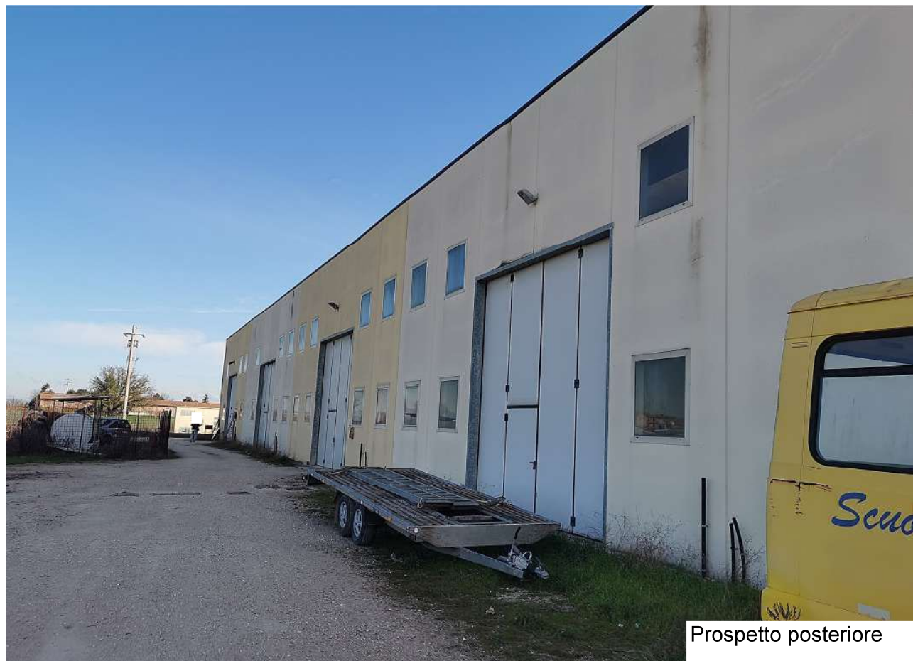
Prospetto laterale sud
