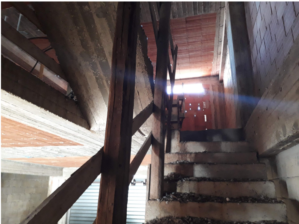
Foto 6, 7 e 8 – Bene A (ingresso comune e vano scala).
