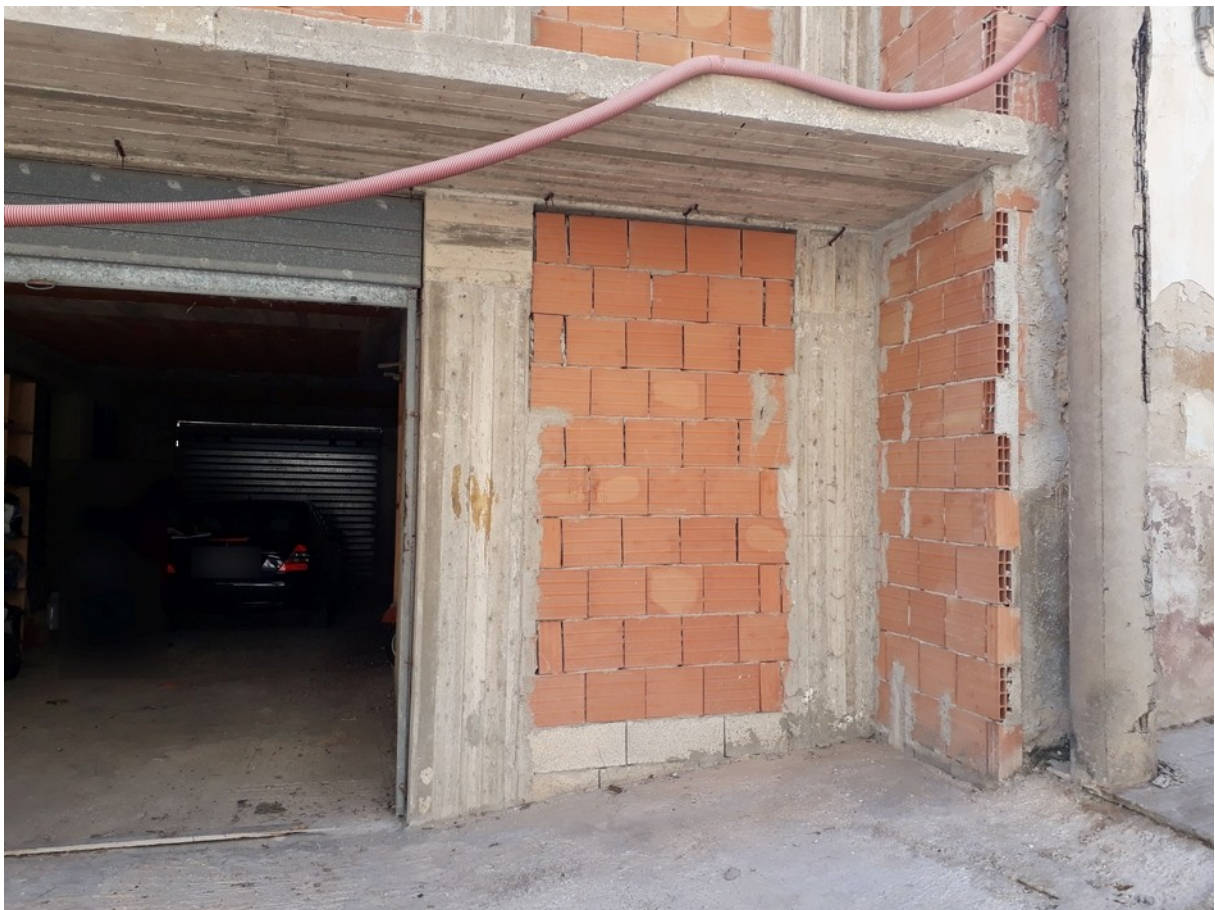
Foto 2 e 3 – Particolari del prospetto di via Principe Amedeo.
