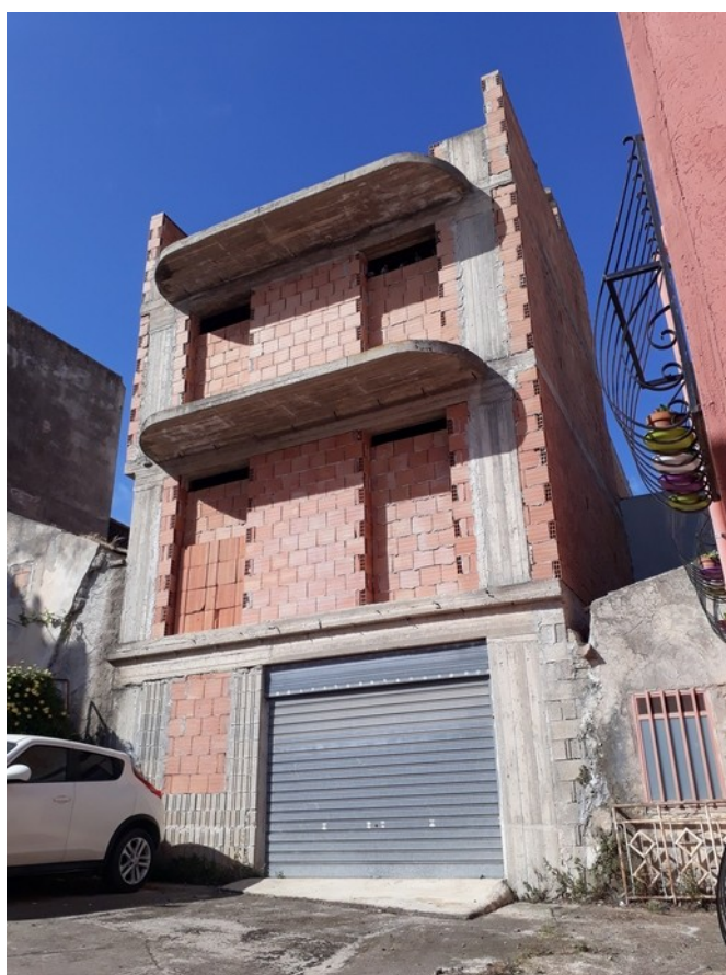
Foto 15 e 16 – Prospetto secondario del fabbricato (cortile di via Torino).
