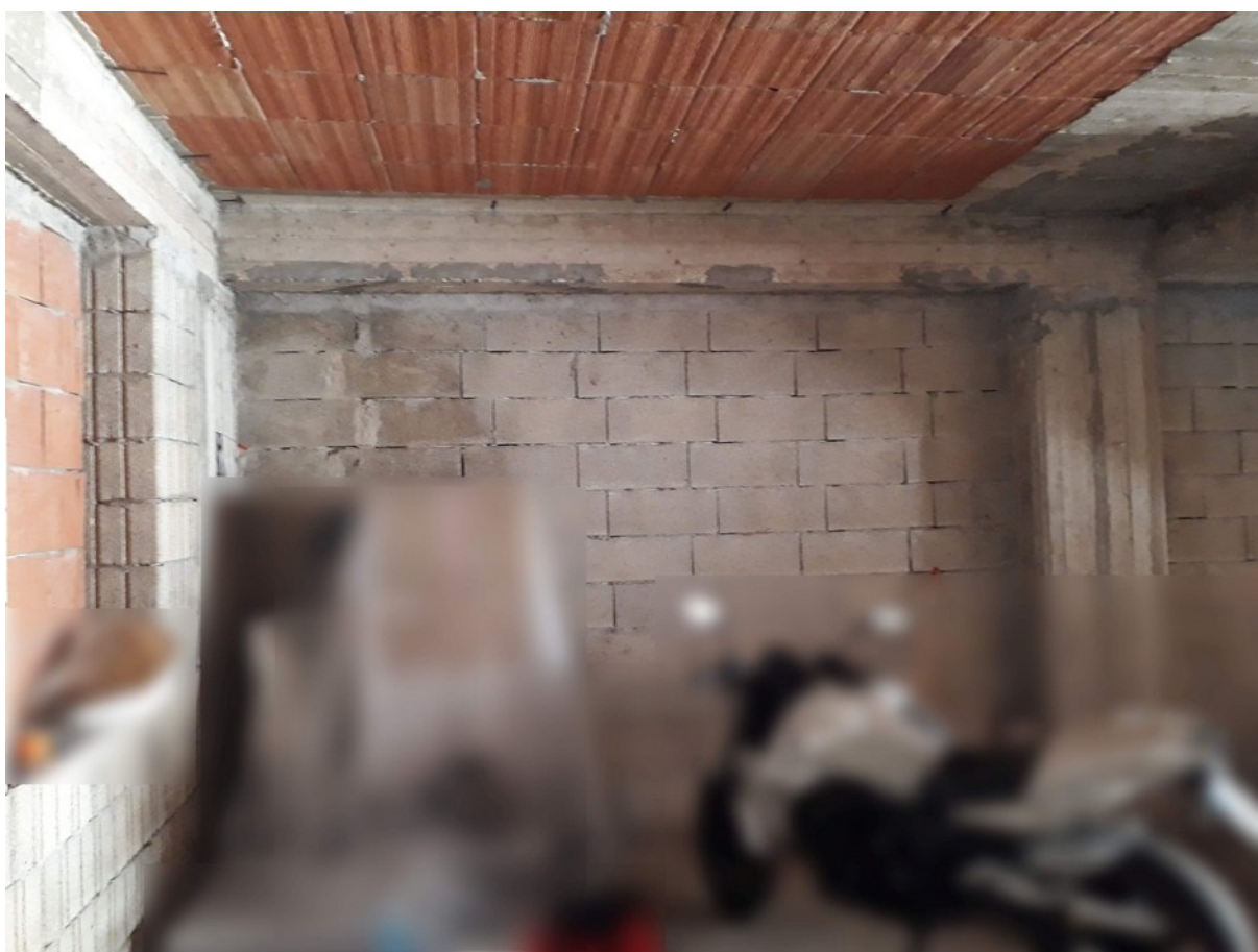
Foto 4 e 5 – Interno del garage (bene B).
