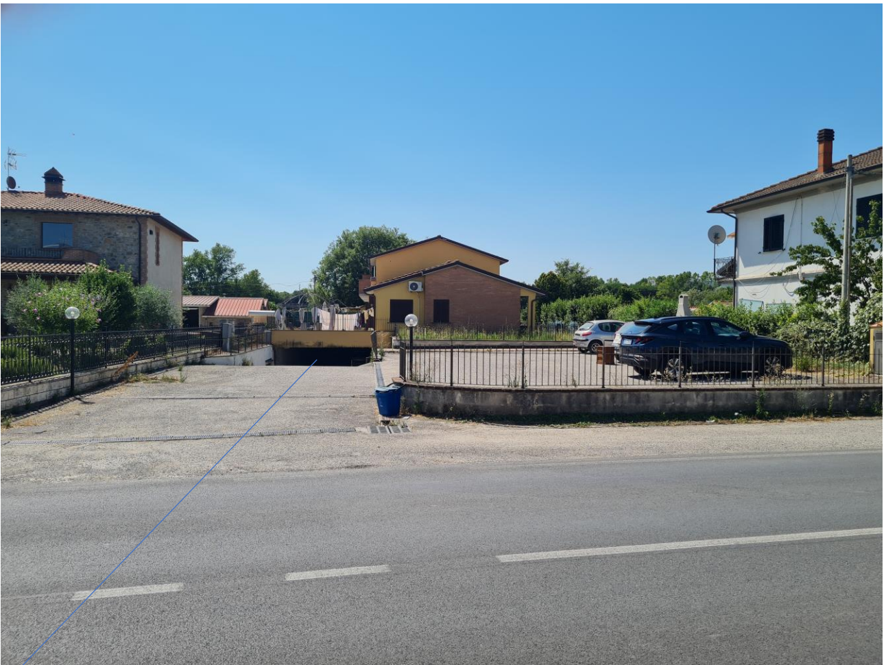
Rampa di adduzione ai boxes auto
