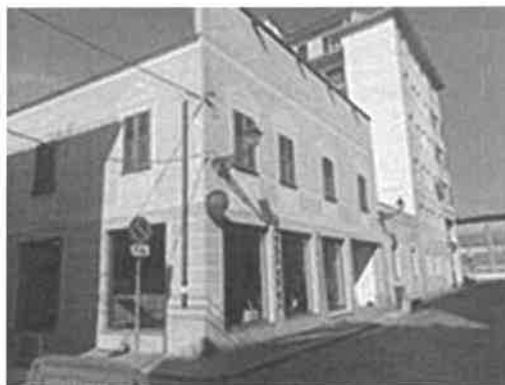
Foto 2: fronte su via Cavour
