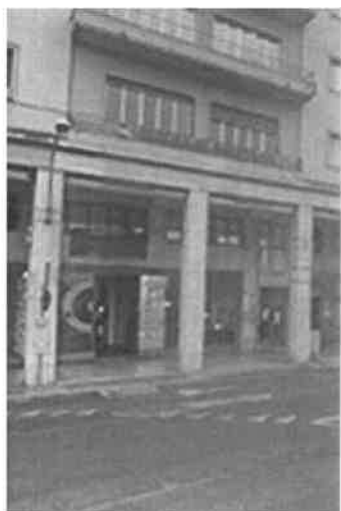
Foto 3: Fronte su Corso Marengo
