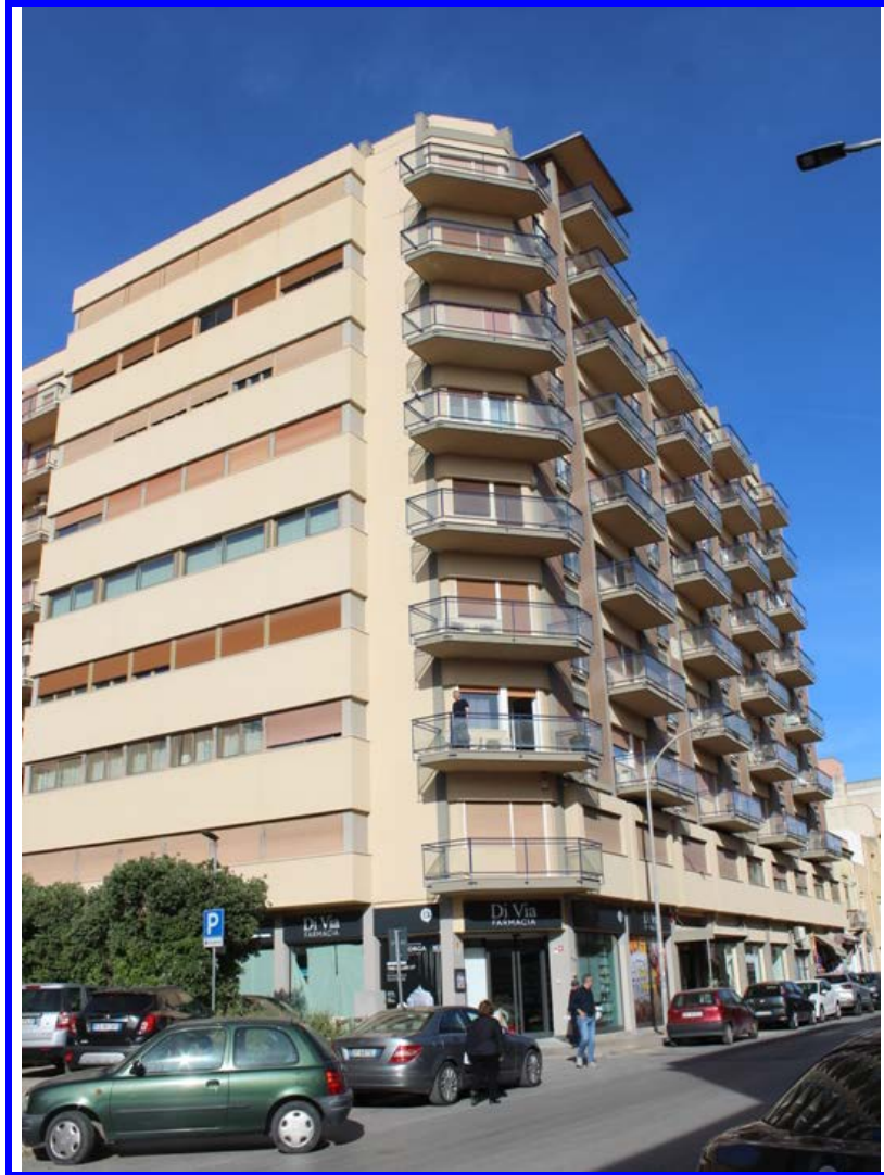
Foto 1 – prospetto fabbricato su via G.Marconi
