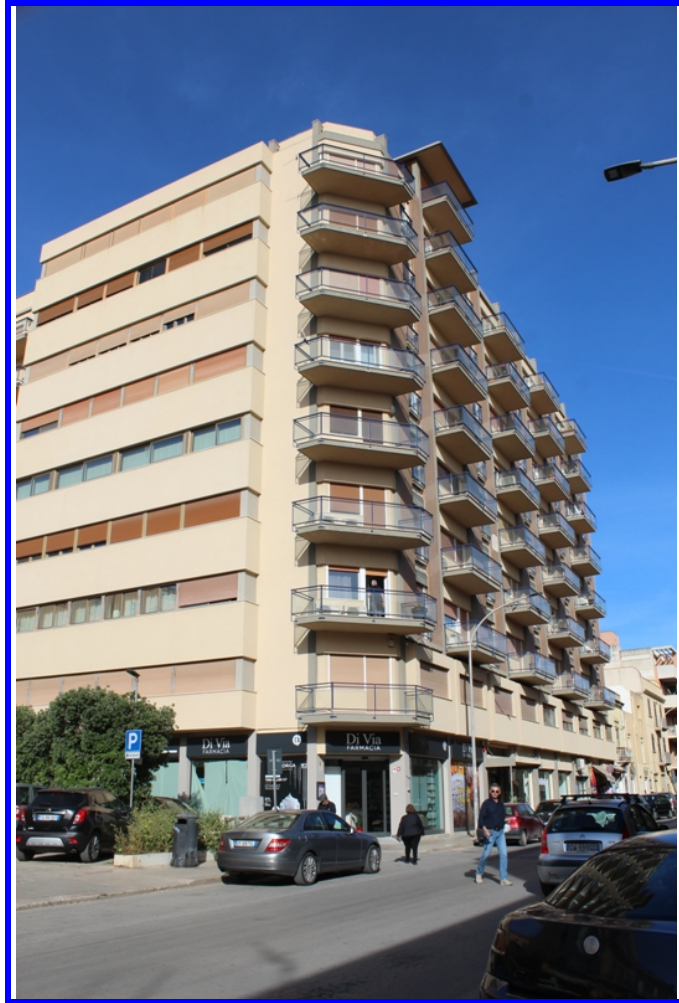
Foto 1 – prospetto fabbricato su via G.Marconi
