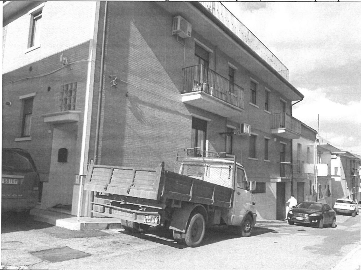
2 – Prospetto laterale su via Marziale
