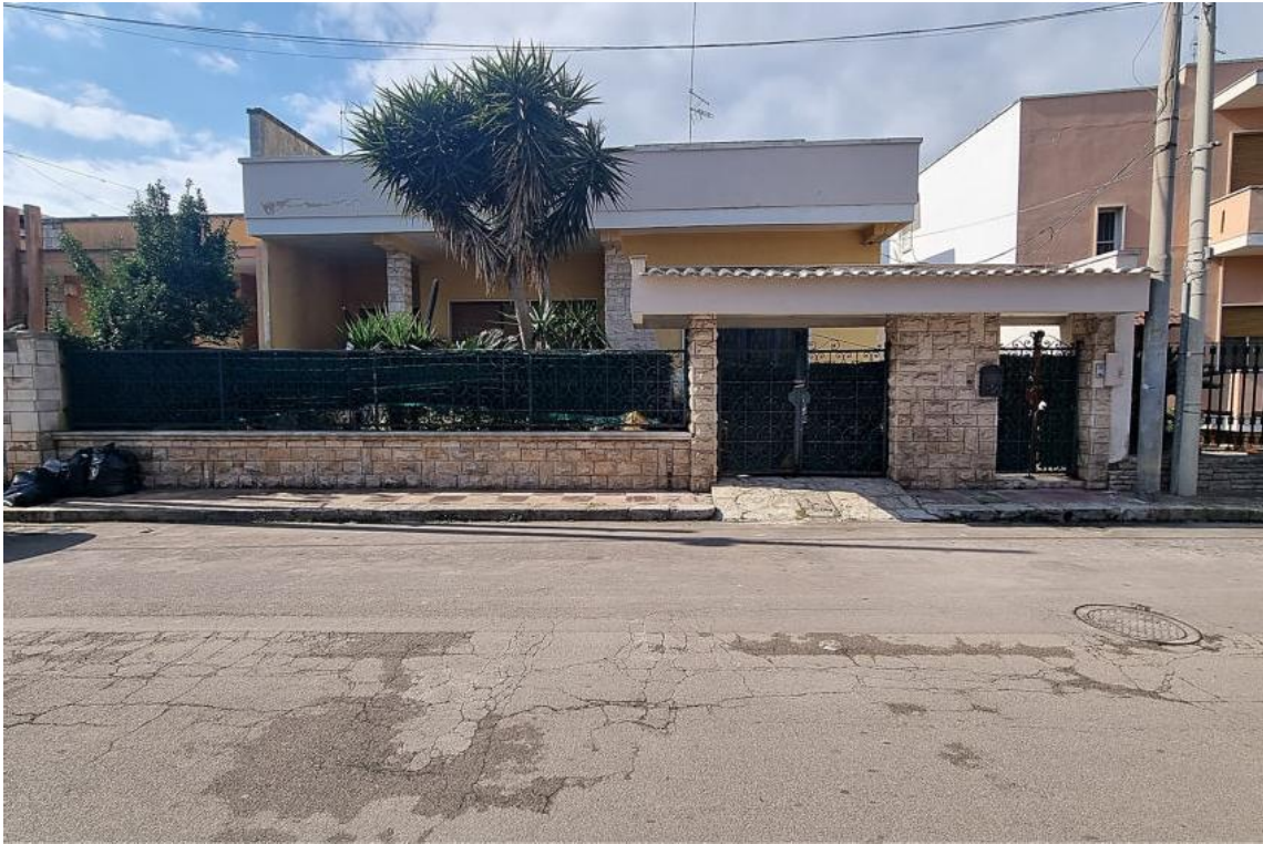
1 - Prospetto su via Cellino
