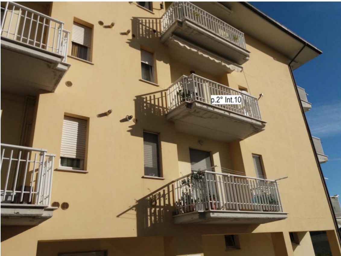
FOTO B_facciata immobile Sud
