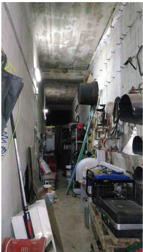
intercapedine, lato sud-ovest, usata come ripostiglio
