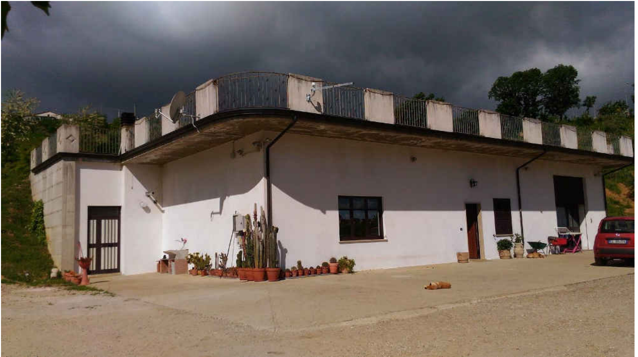
ingresso, lato nord-est, con ripostiglio aggiunto
