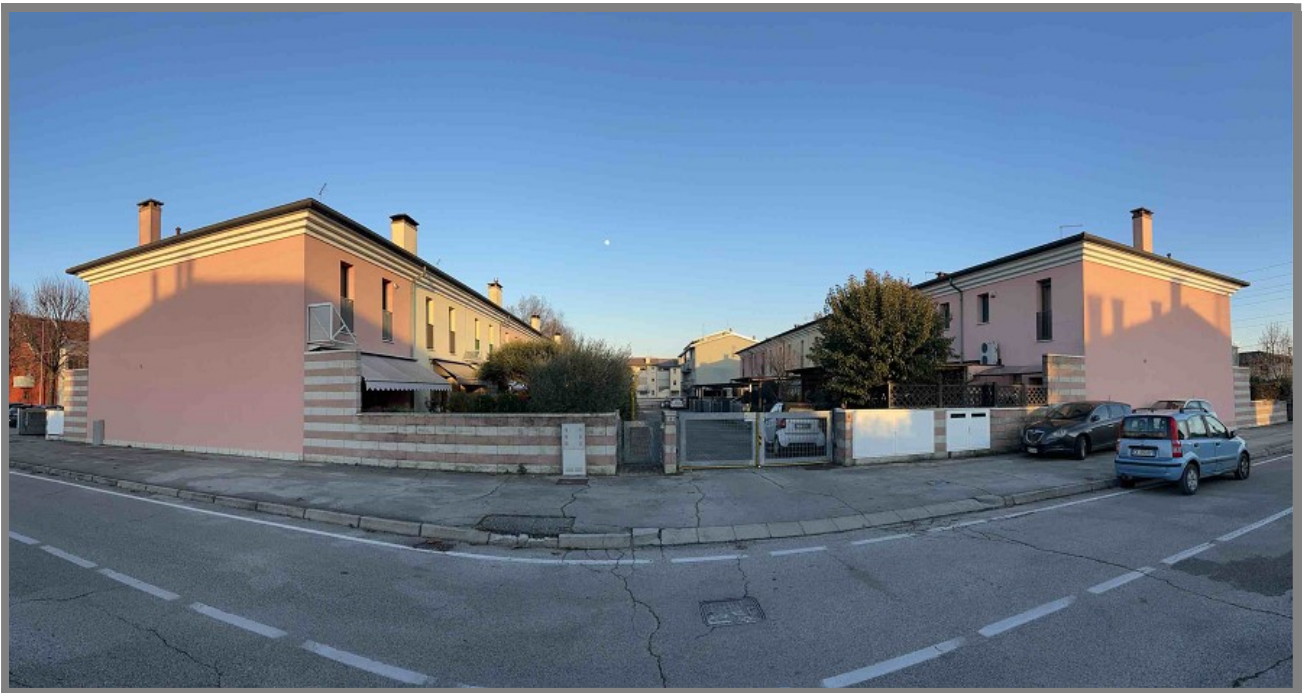
VISTA da via PRIMO MAGGIO n. 4
