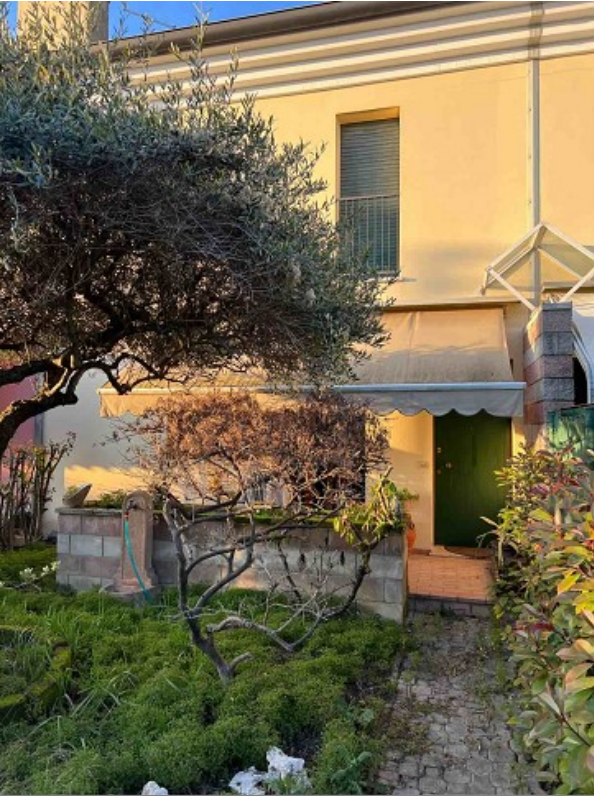
Vista da cortile esclusivo (sud)
