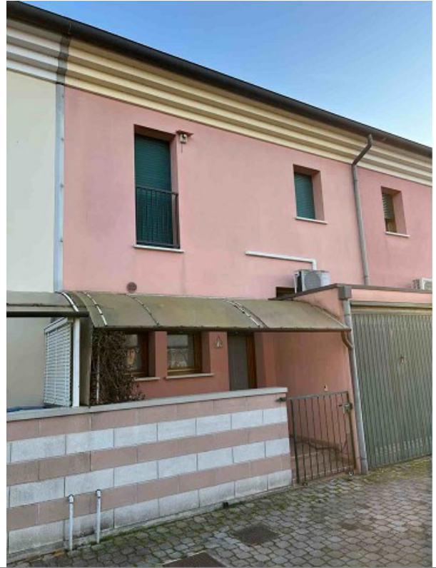
Vista dal retro (nord)
