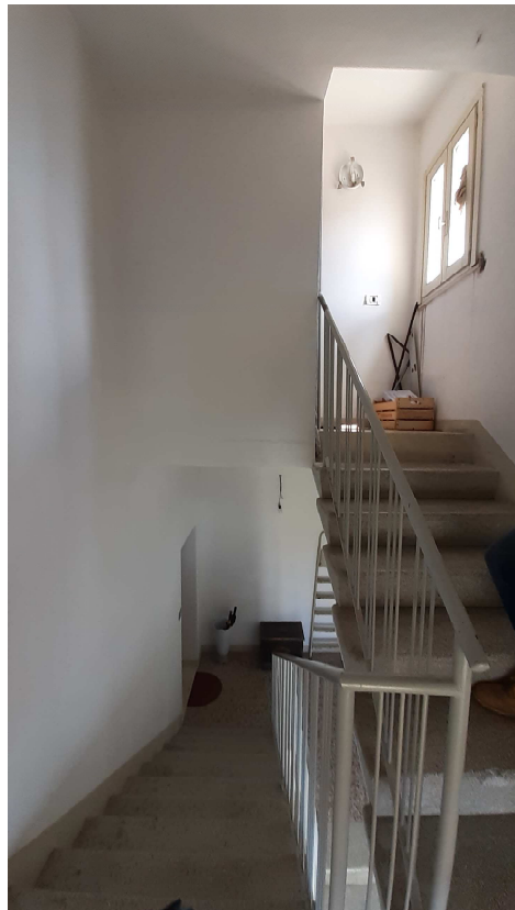
corpo scale condominiale
