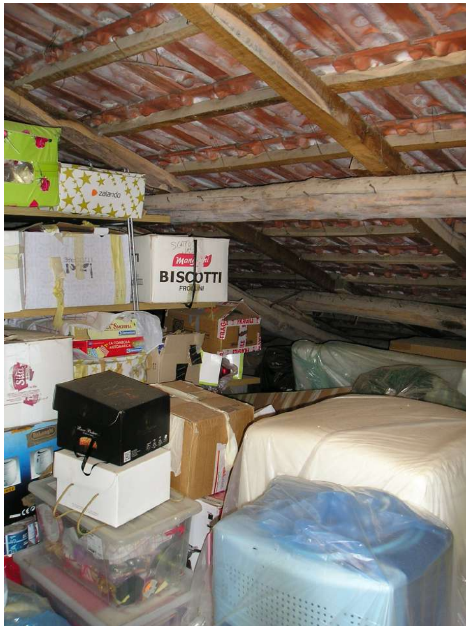
Foto n. 8: Particolare copertura del fabbricato
