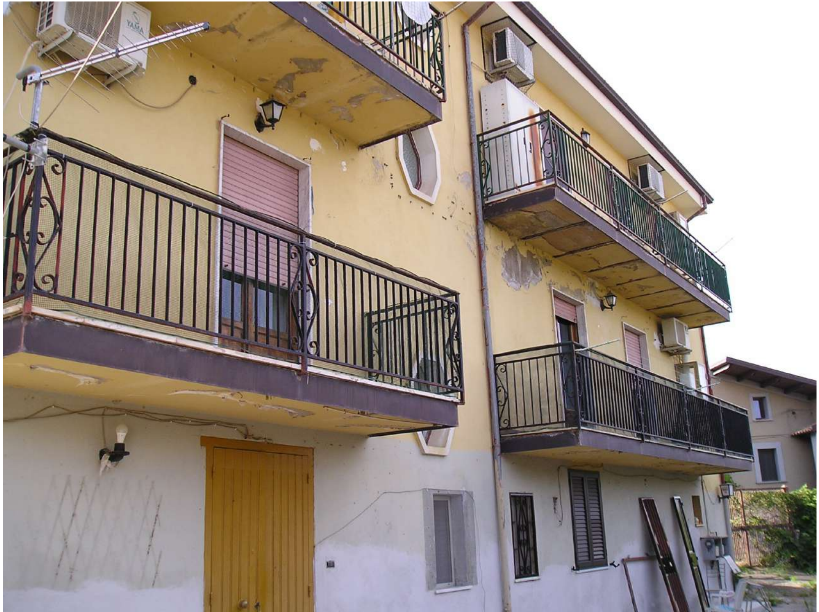
Foto n. 7: Particolare stato di manutenzione del fabbricato
