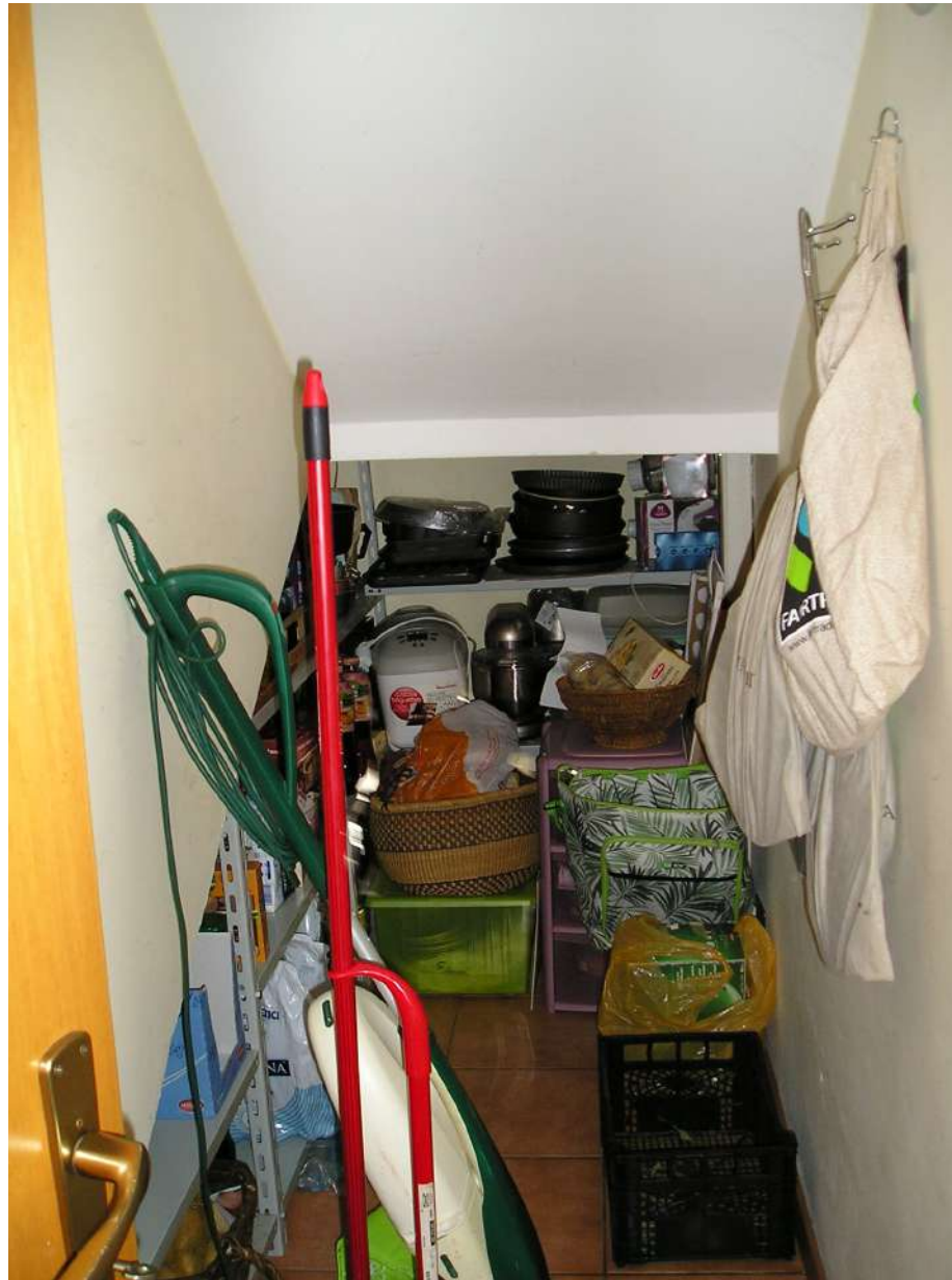
Foto n. 30: Ripostiglio al posto del corpo scala originario, di cui si prevede il ripristino – piano secondo
