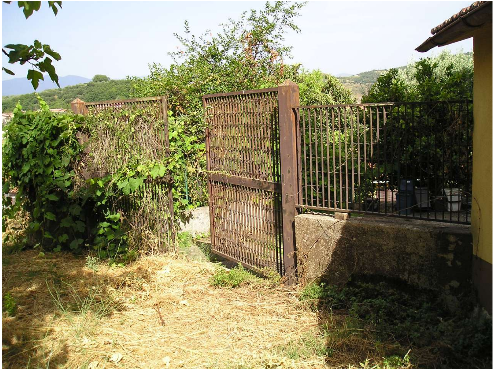
Foto n. 37: Accesso a valle del fabbricato
