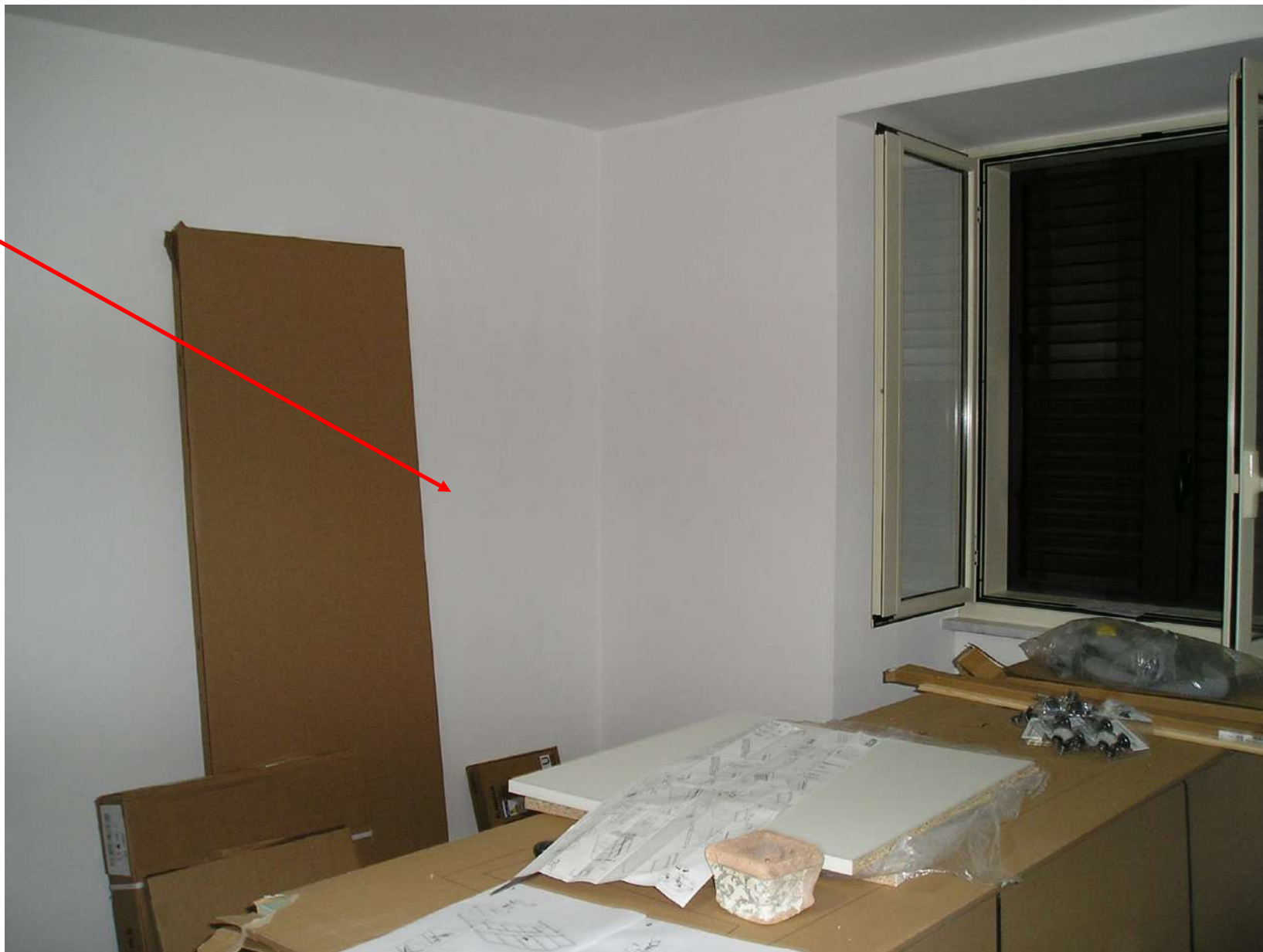
Foto n. 12: Vano in cui si prevede la riapertura della porta interna – piano terra del fabbricato
