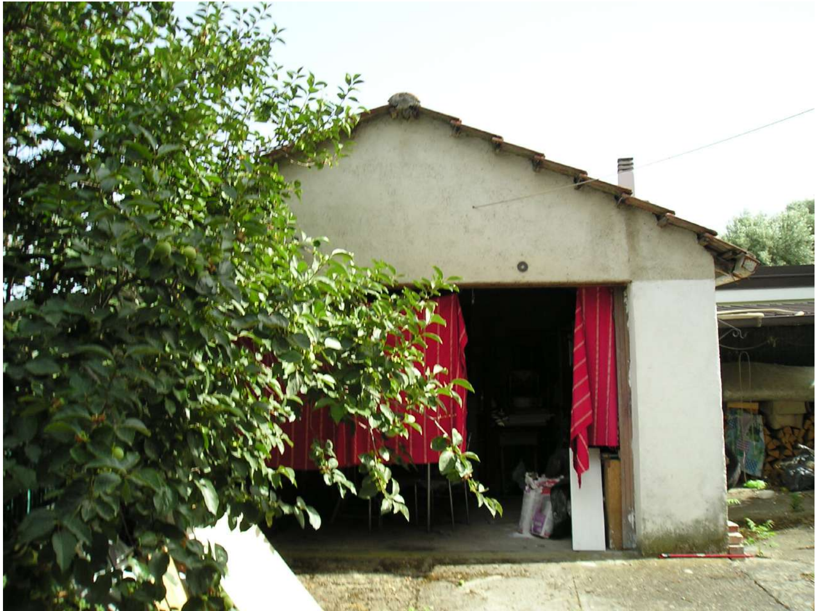
Foto n. 47: Locale di deposito a valle della rampa
