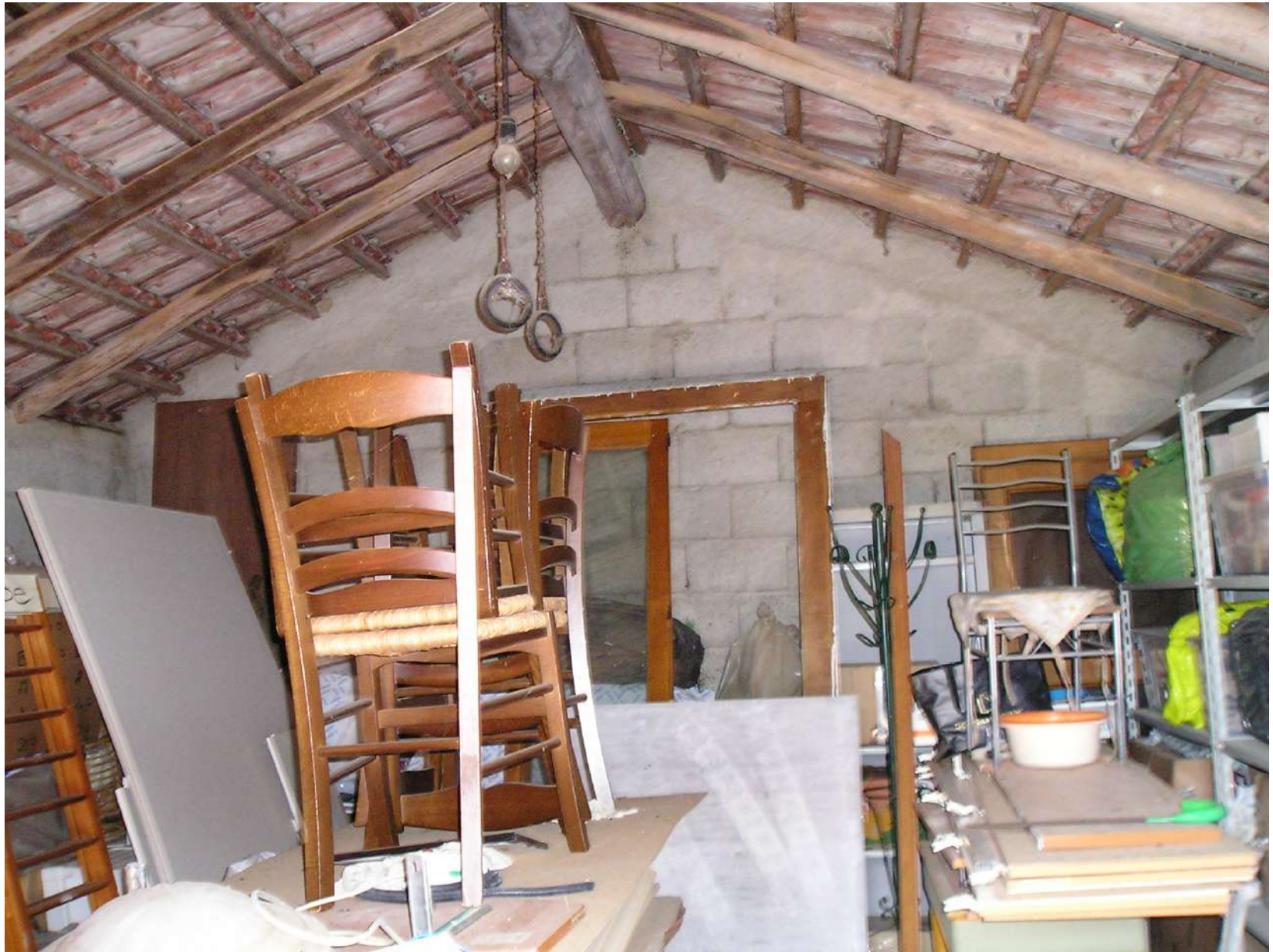
Foto n. 49: Locale di deposito – particolare interno
