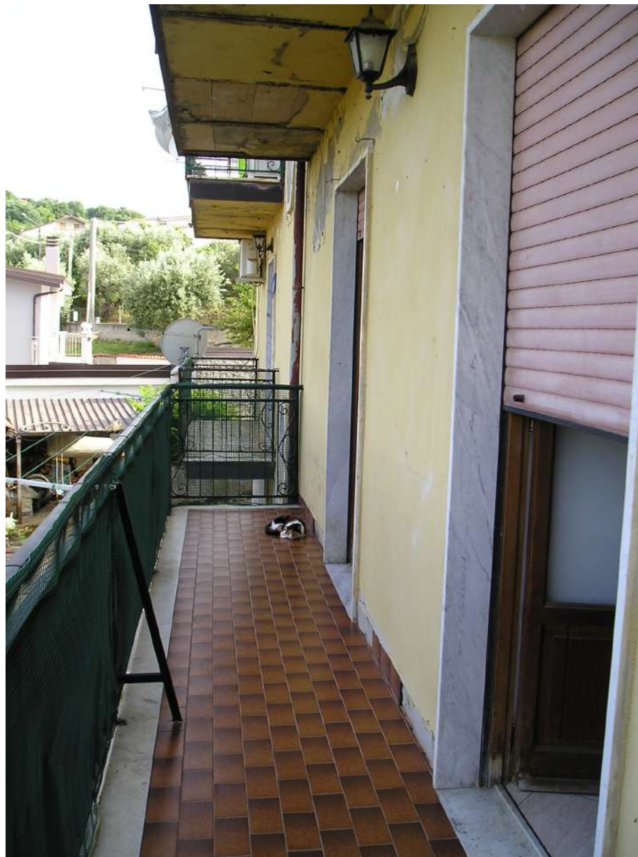
Foto n. 24: Balconi – piano primo
