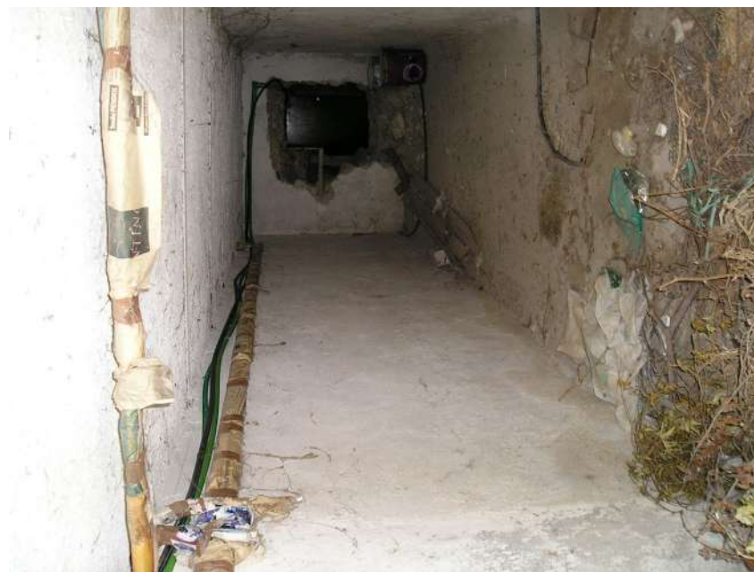
Foto n. 14: Vano con altezza pari a circa 1,50 metri – piano terra del fabbricato
