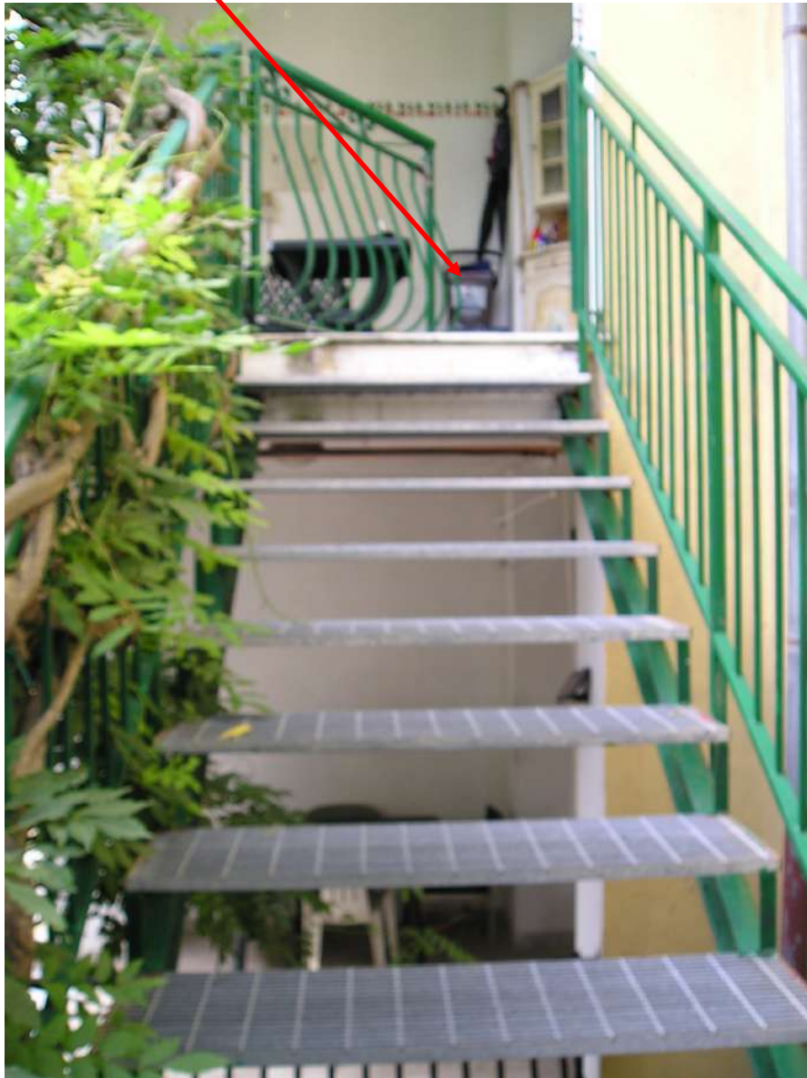
Foto n. 33: Scala esterna in ferro non prevista in progetto, di cui si prevede la rimozione
