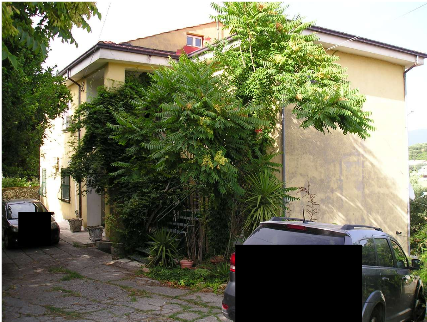
Foto n. 4: Immobile 1 – Fabbricato p.IIa 82
