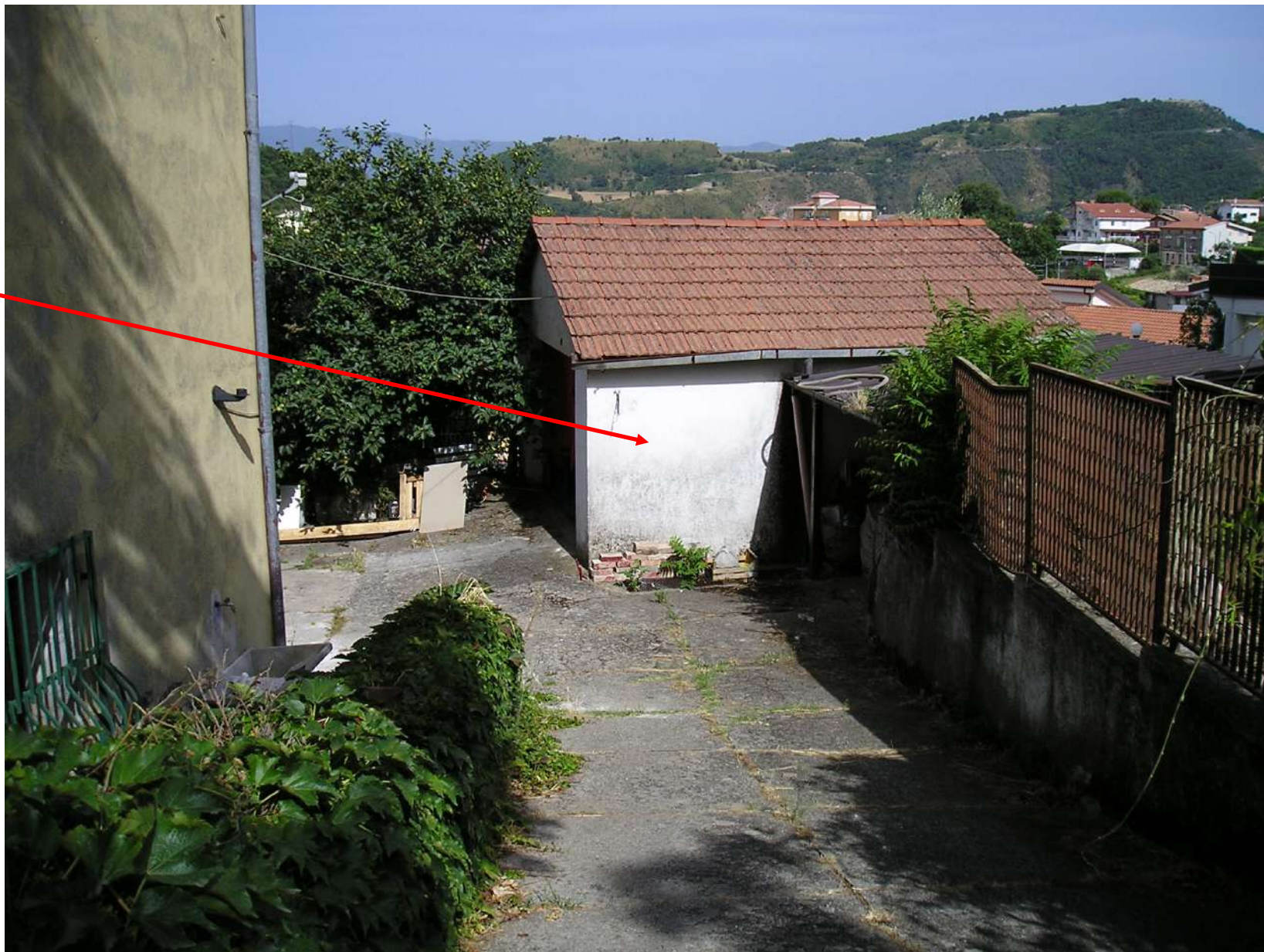
Foto n. 48: Locale di deposito a valle della rampa
