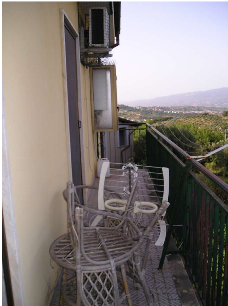
Foto n. 32: Balconi – piano secondo
