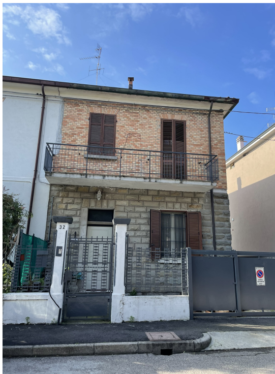
Fronte del fabbricato
