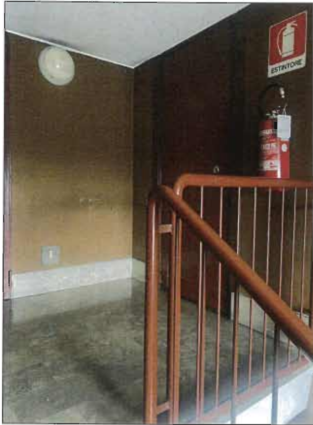
INGRESSO SOLAI PIANO SETTIMO
