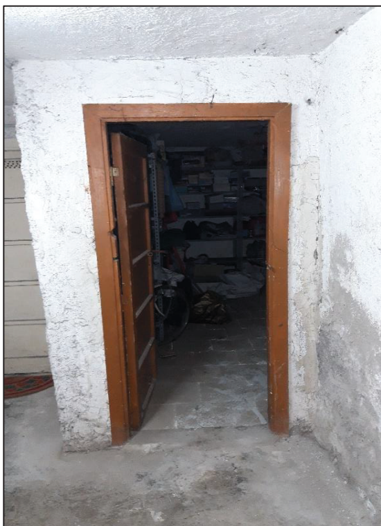
Foto n.8 – Ingresso locale deposito al piano terra
