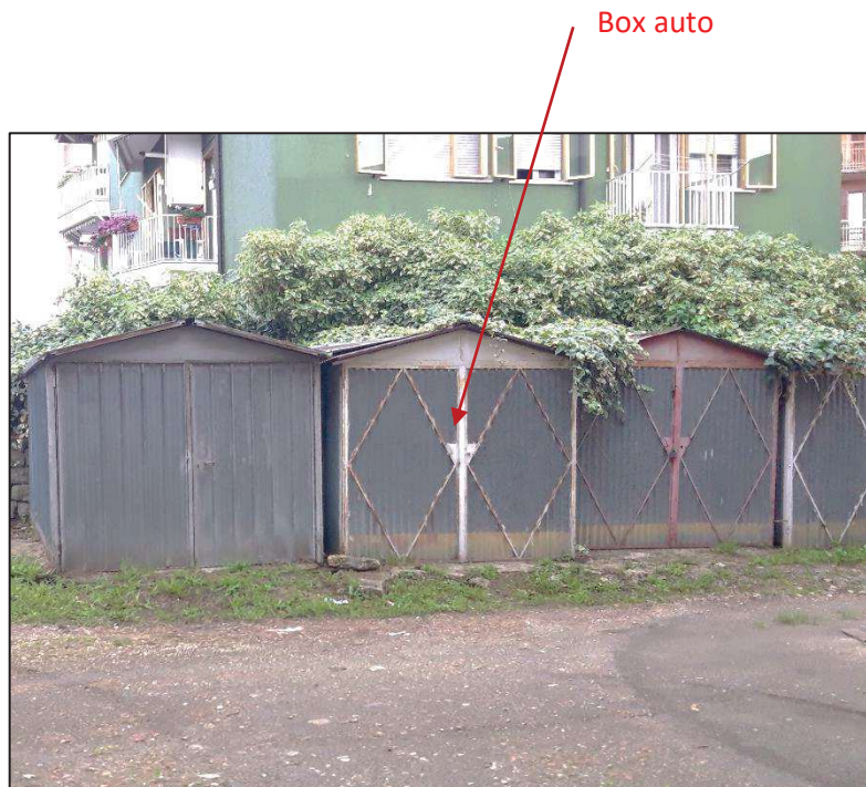
Foto n.10 – Posto auto con il box installato
