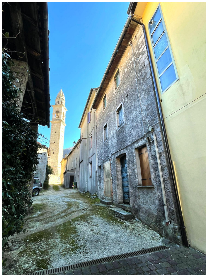
Prospetto Nord dell'edificio (abitazione a schiera)
