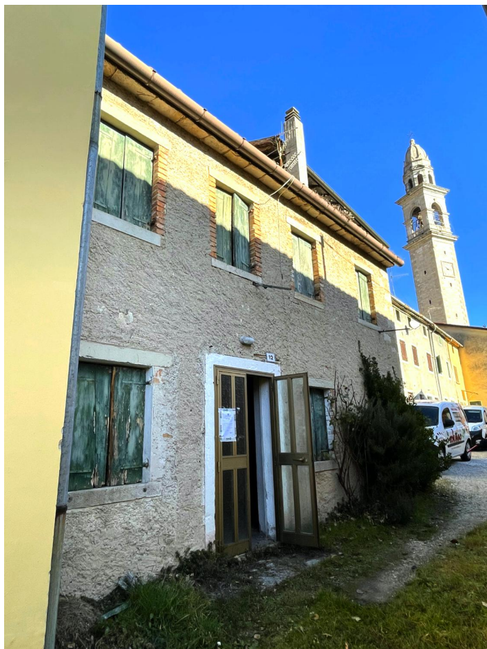
Prospetto Sud dell'edificio (abitazione a schiera)
