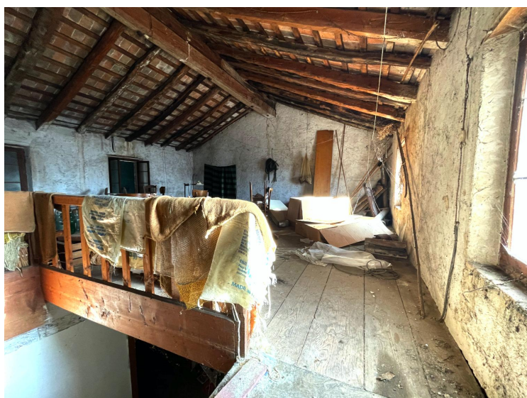
Soffitta (secondo piano)
