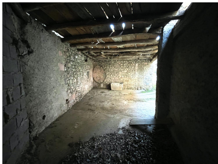
Autorimessa (piano terra)
