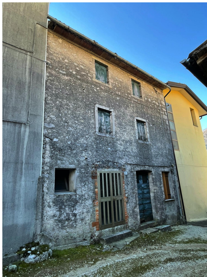
Prospetto Nord dell'edificio (abitazione a schiera)
