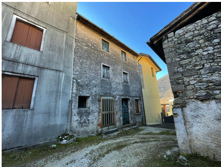
Prospetto Nord dell'edificio (abitazione a schiera)
