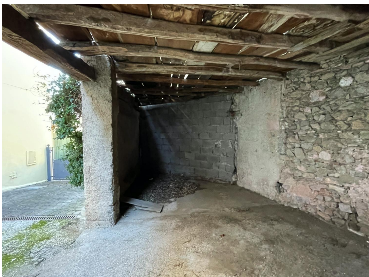
Autorimessa (piano terra)
