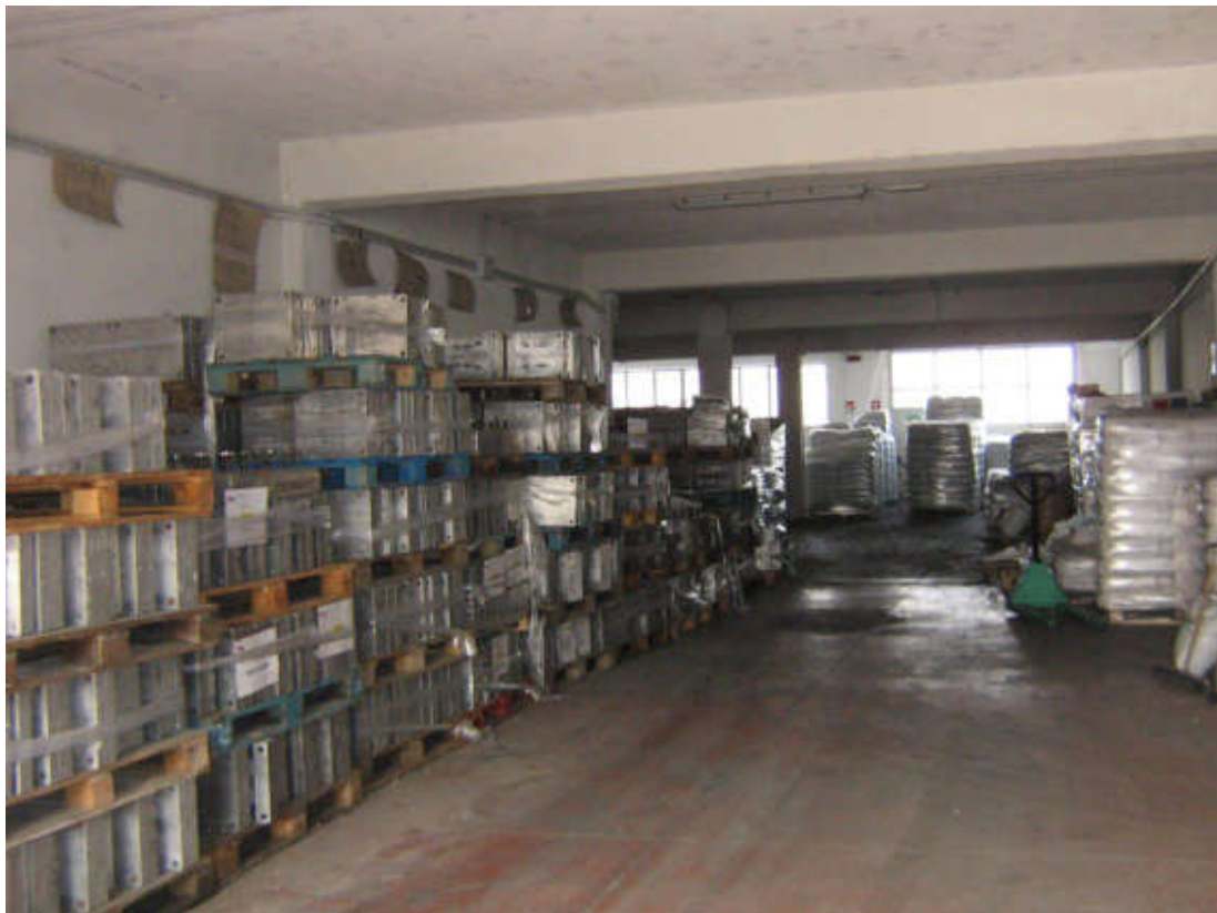
DEPOSITO AL PIANO SECONDO SOTTOSTRADA
