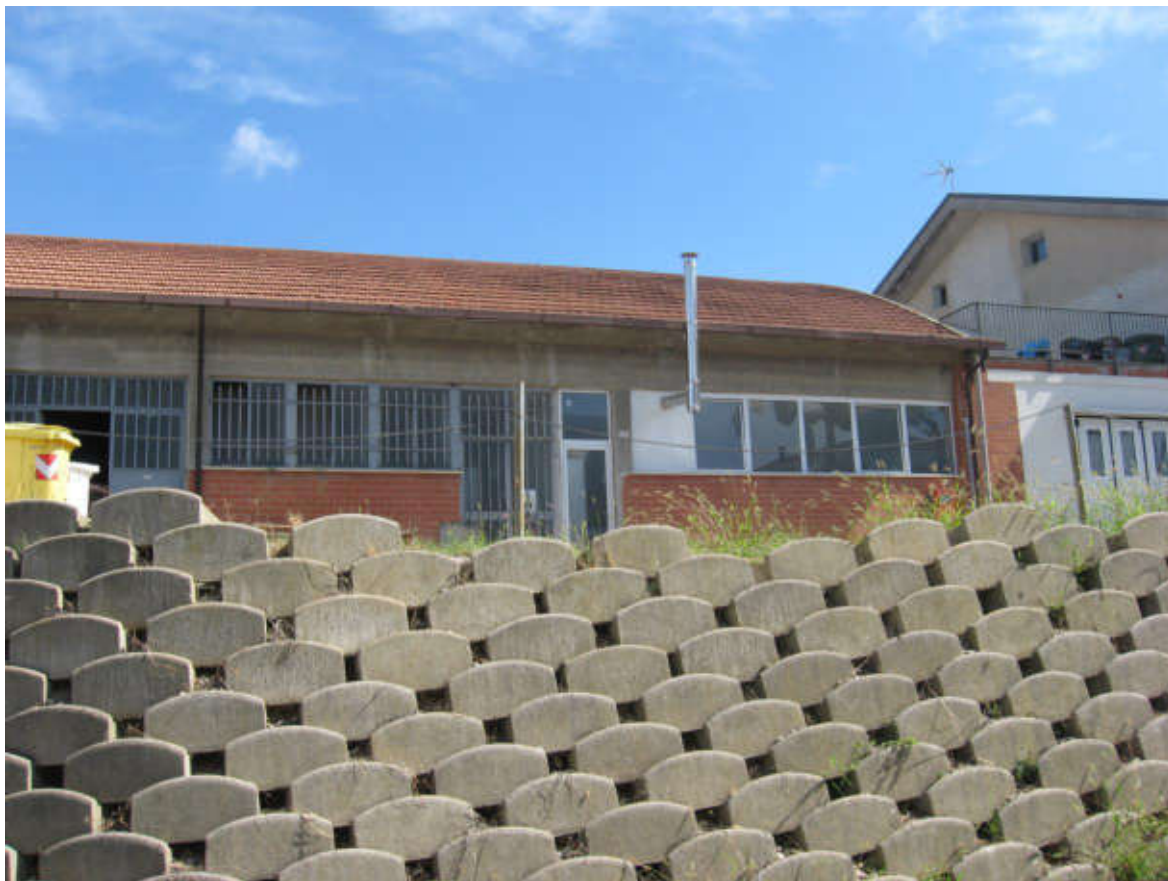
DOCUMENTAZIONE FOTOGRAFICA LABORATORIO LATO OVEST
