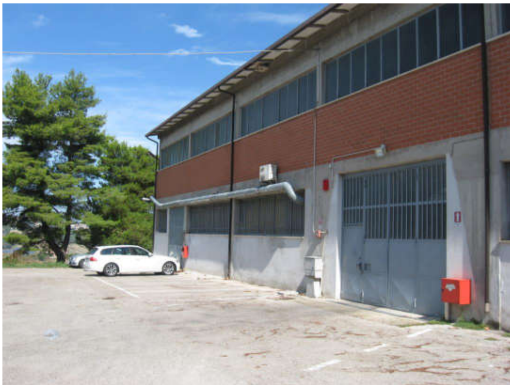
DOCUMENTAZIONE FOTOGRAFICA LABORATORIO LATO OVEST
