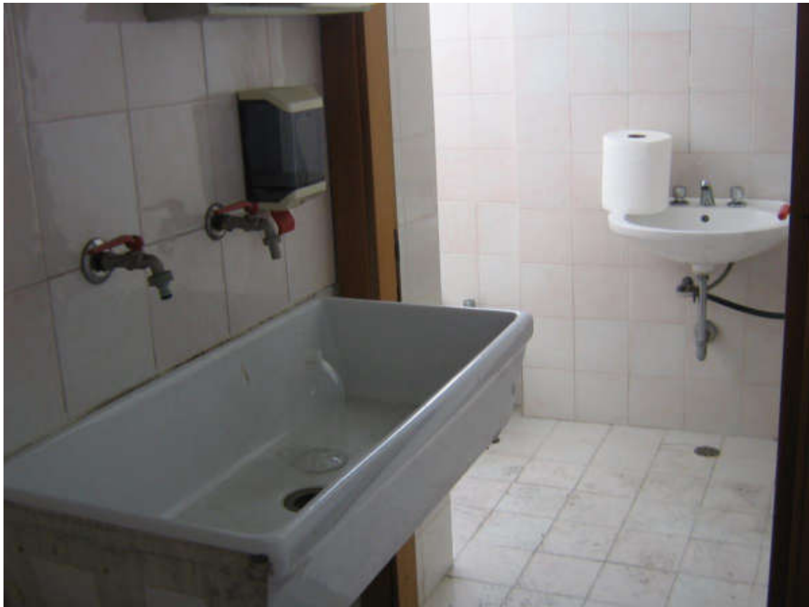
DEPOSITO AL PIANO SECONDO SOTTOSTRADA
