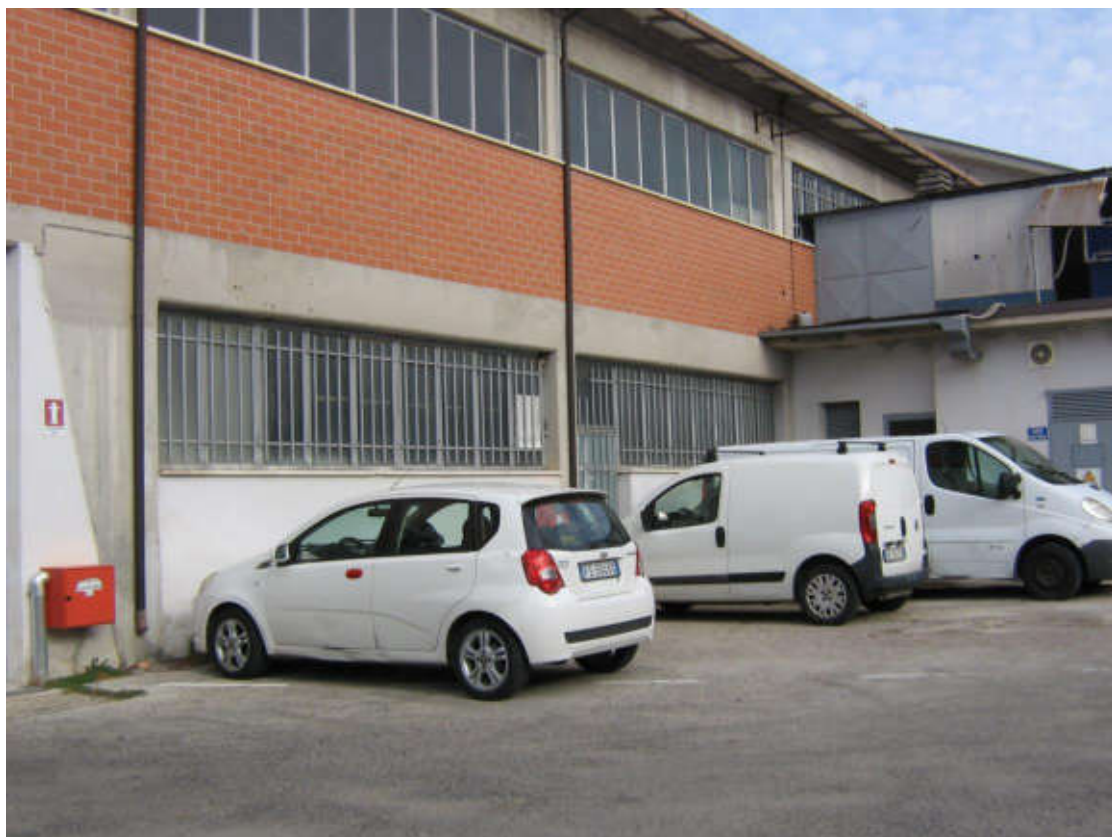
DEPOSITO AL PIANO SECONDO SOTTOSTRADA
