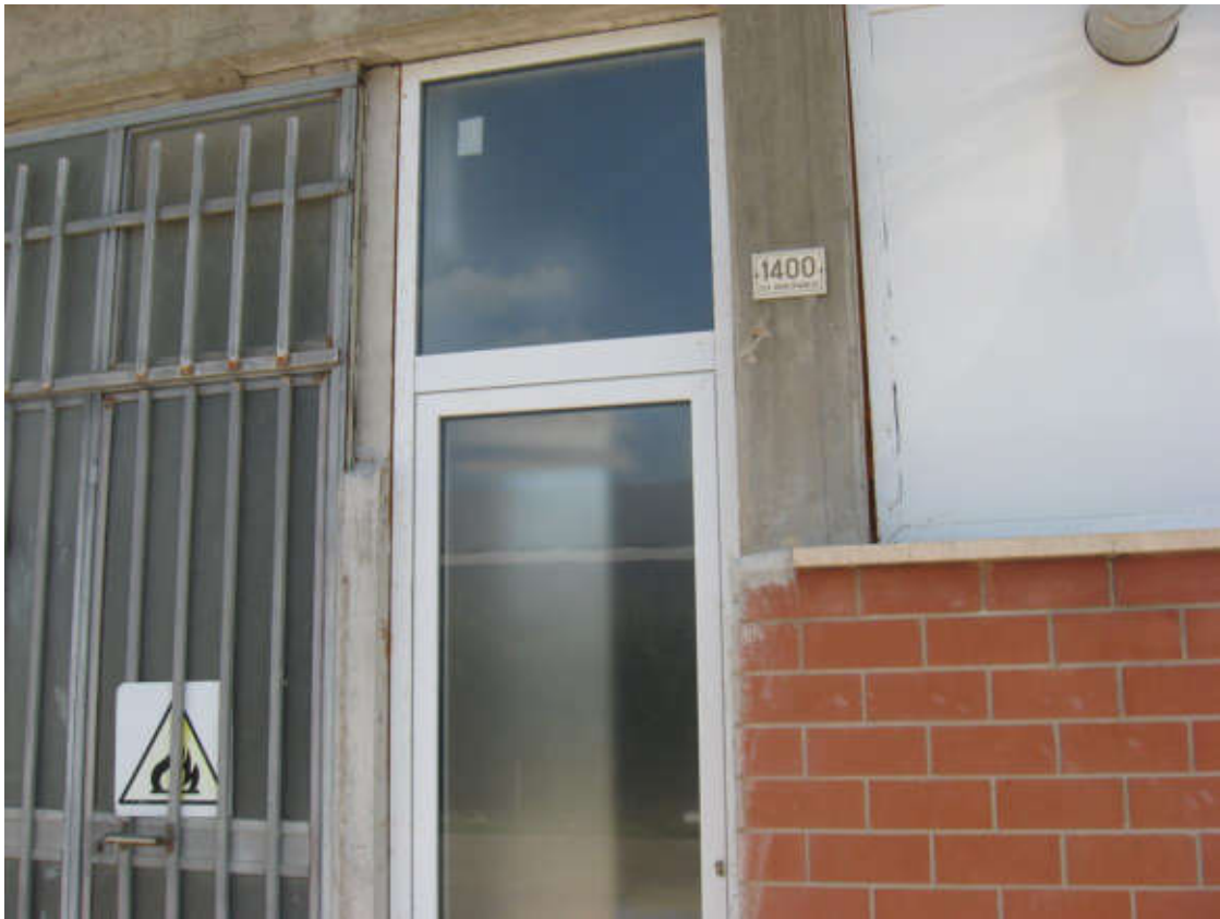
Laboratorio pasticceria - Piano primo sottostrada – Ingresso
