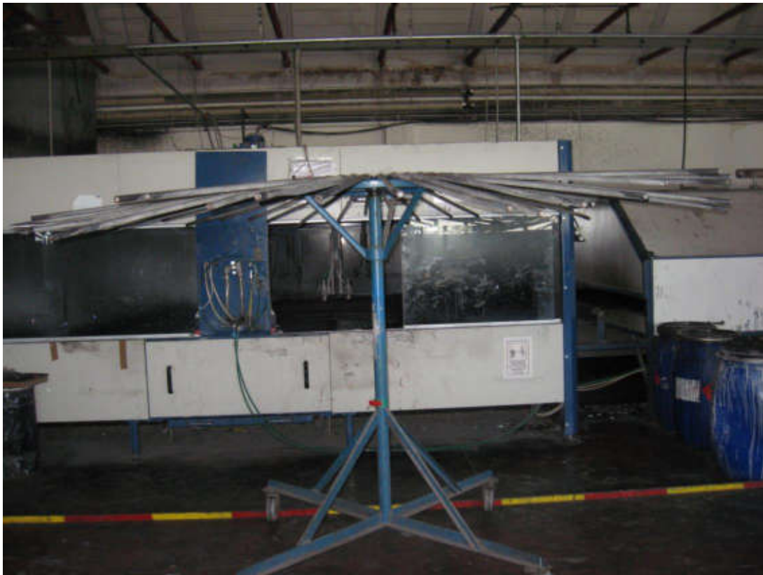
Laboratorio rifinitura e vendita pellami - Piano primo sottostrada
