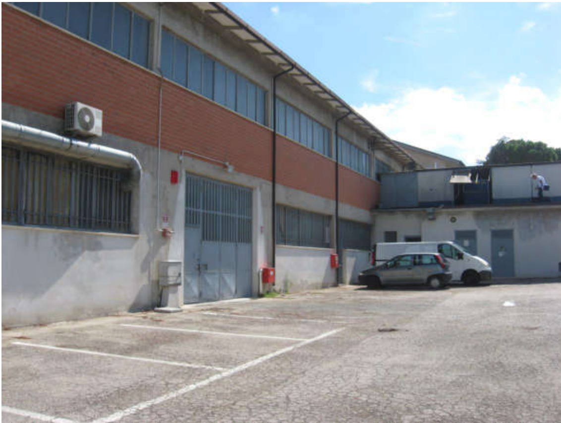
DOCUMENTAZIONE FOTOGRAFICA LABORATORIO LATO OVEST
