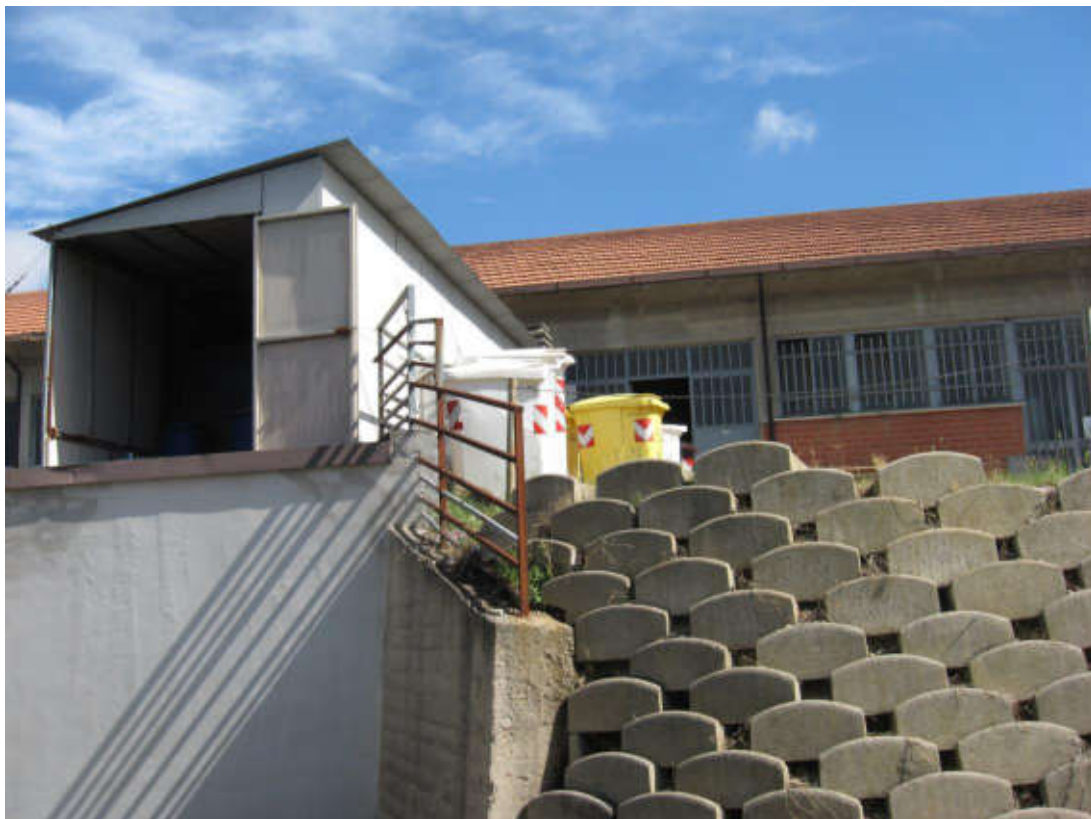
DOCUMENTAZIONE FOTOGRAFICA LABORATORIO LATO OVEST
