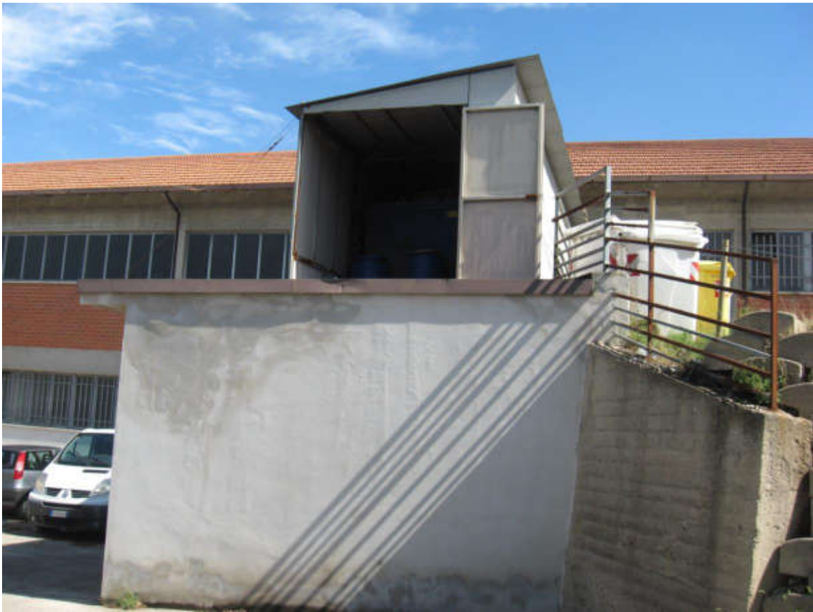
DOCUMENTAZIONE FOTOGRAFICA LABORATORIO LATO OVEST
