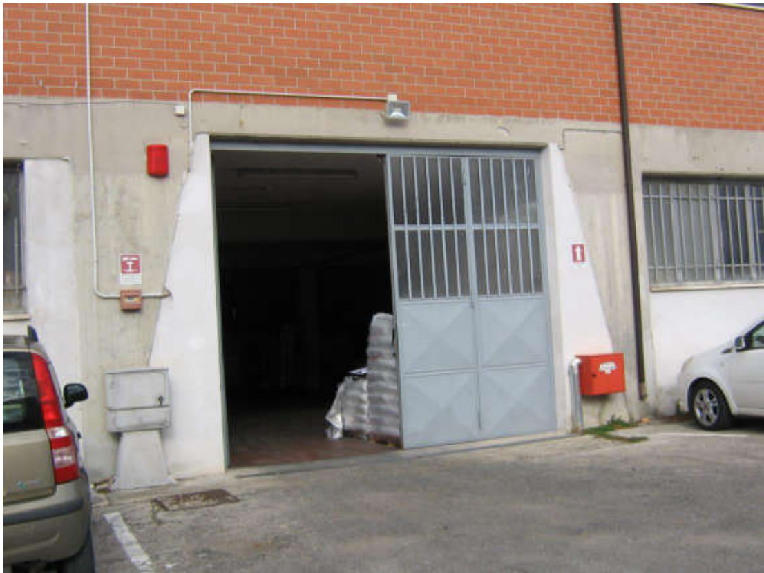
DEPOSITO AL PIANO SECONDO SOTTOSTRADA
