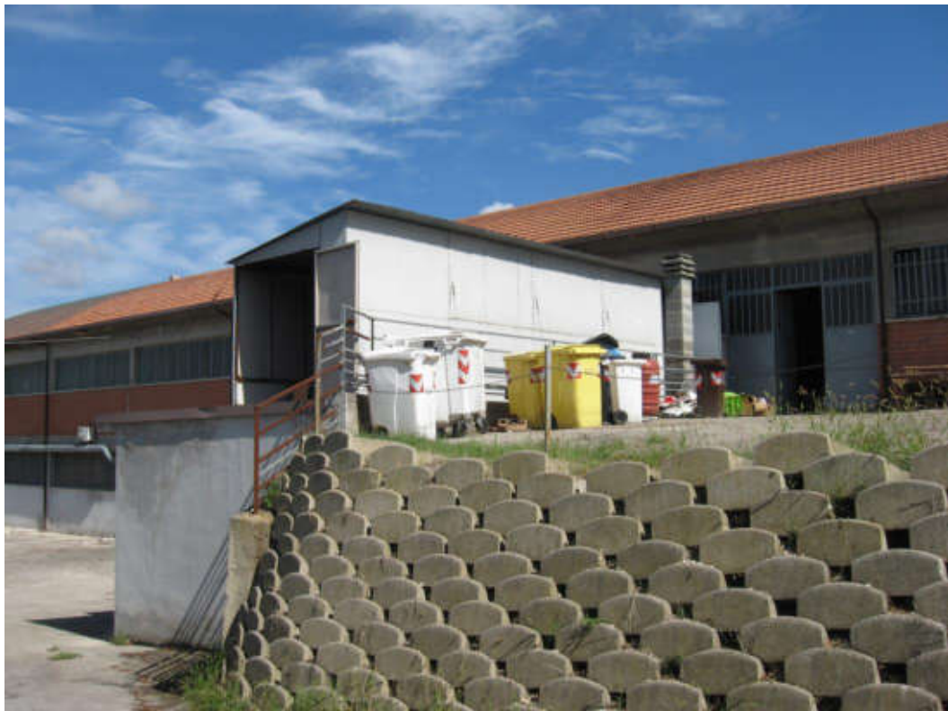
DOCUMENTAZIONE FOTOGRAFICA LABORATORIO LATO OVEST
