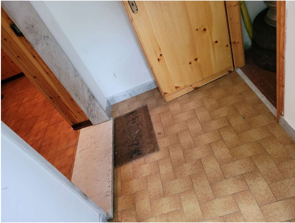
FOTOGRAMMA n.° 11 di 32: porta di accesso all'appartamento ed al ripostiglio sul vano scale
