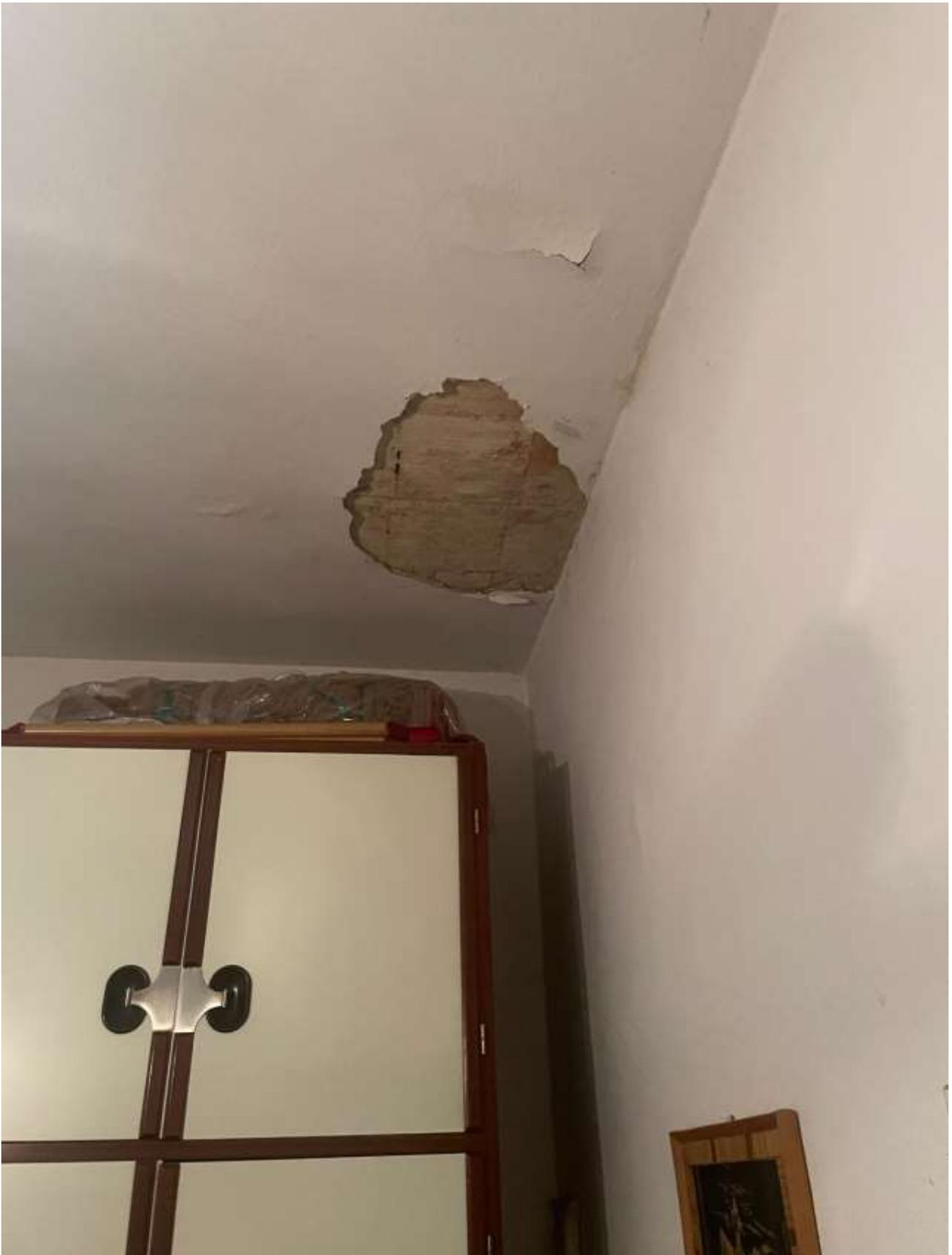
Foto n. 11 - dettaglio danni da pregressa infiltrazione
