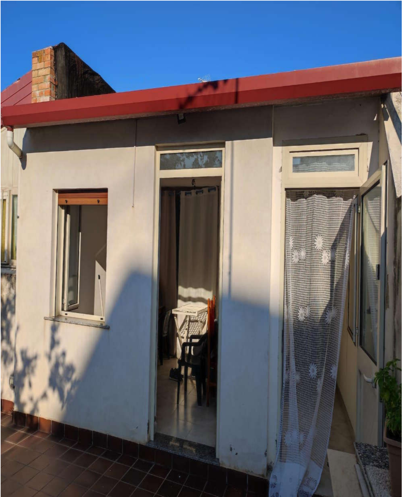
VISTA DA CORTILE
