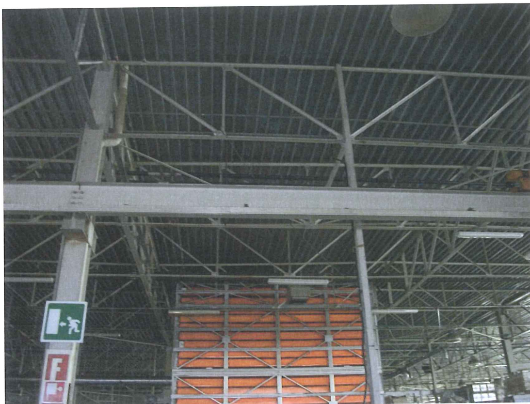
Foto 18 – Visione interna del laboratorio
