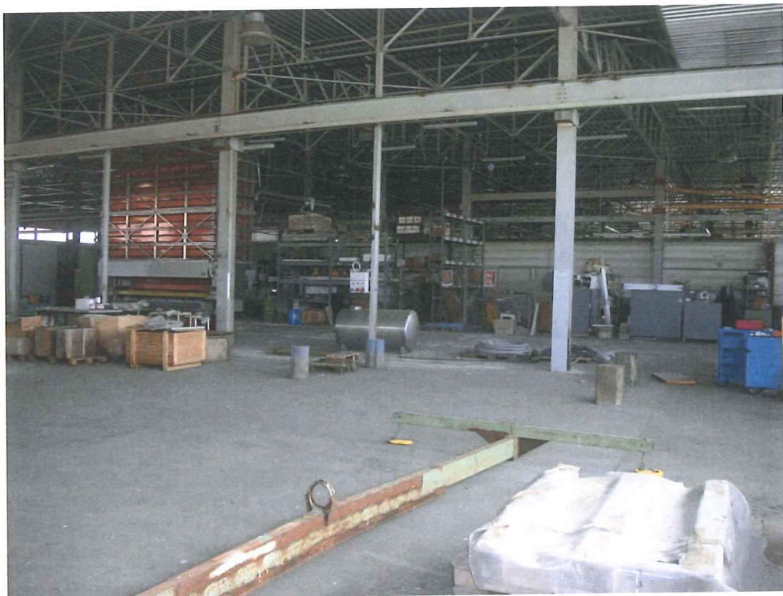
Foto 22 – Visione interna del laboratorio
