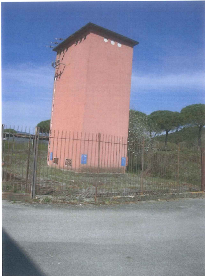
Foto 38 – cabina elettrica di derivazione
