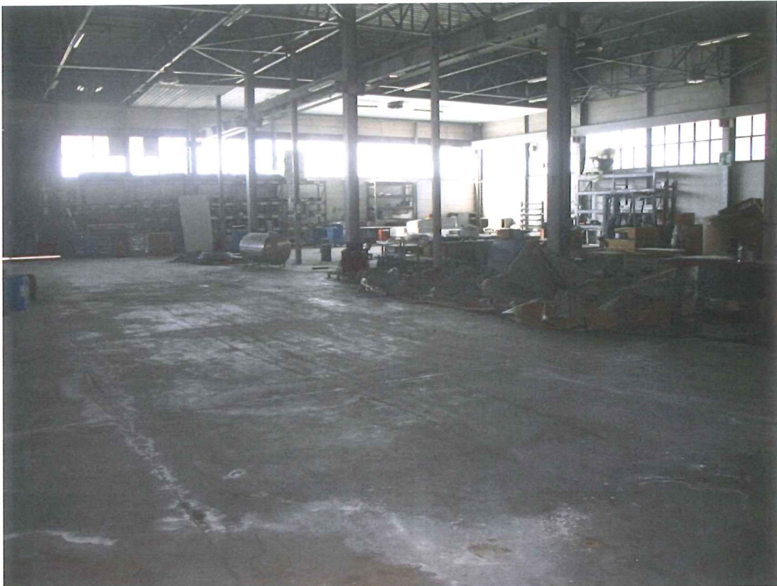
Foto 25 – Visione interna del laboratorio
