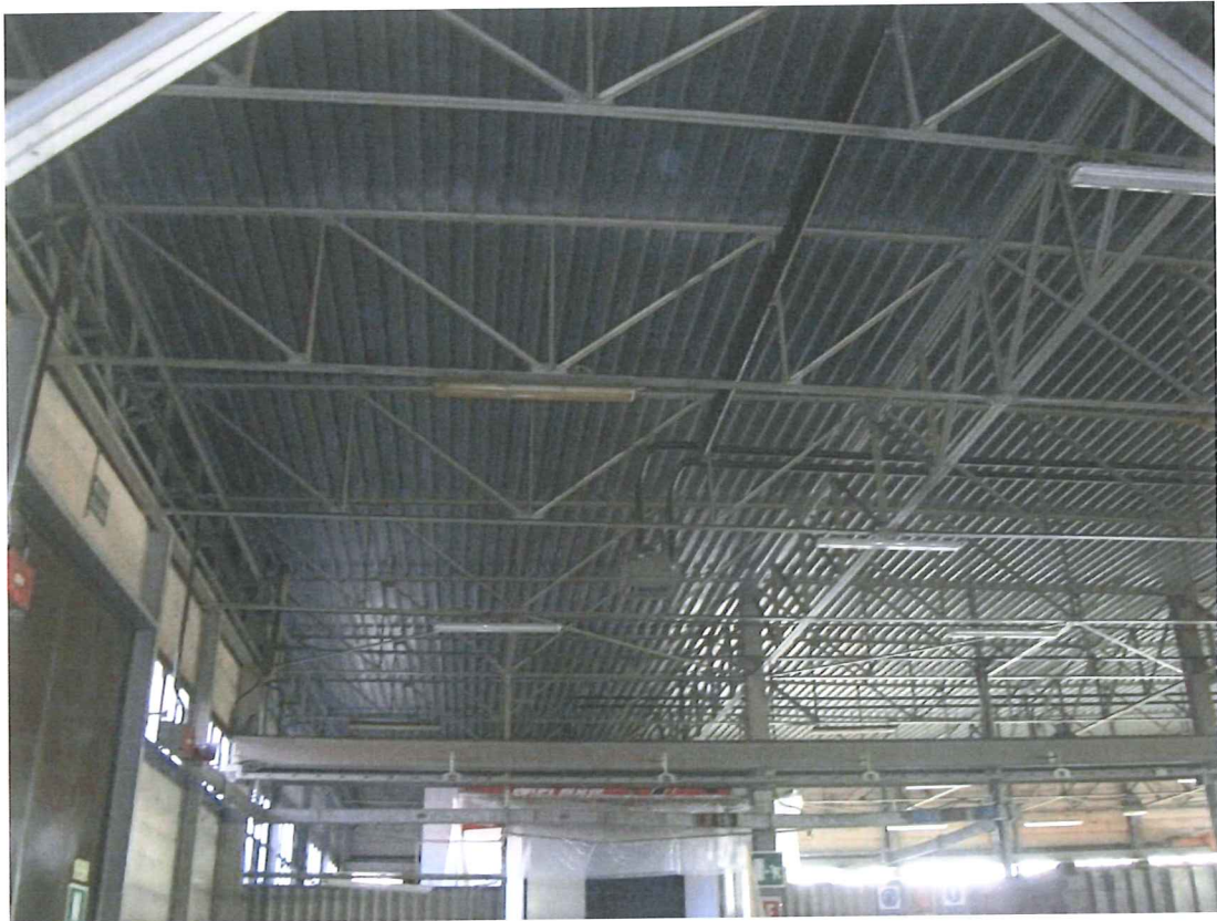
Foto 14 – Visione interna della copertura del laboratorio
