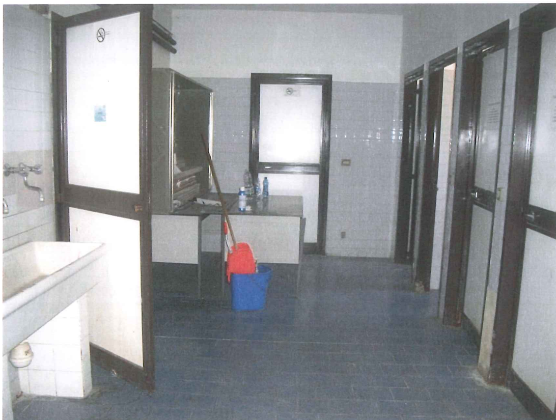
Foto 28/16 Bagni degli operai (piano terra)
