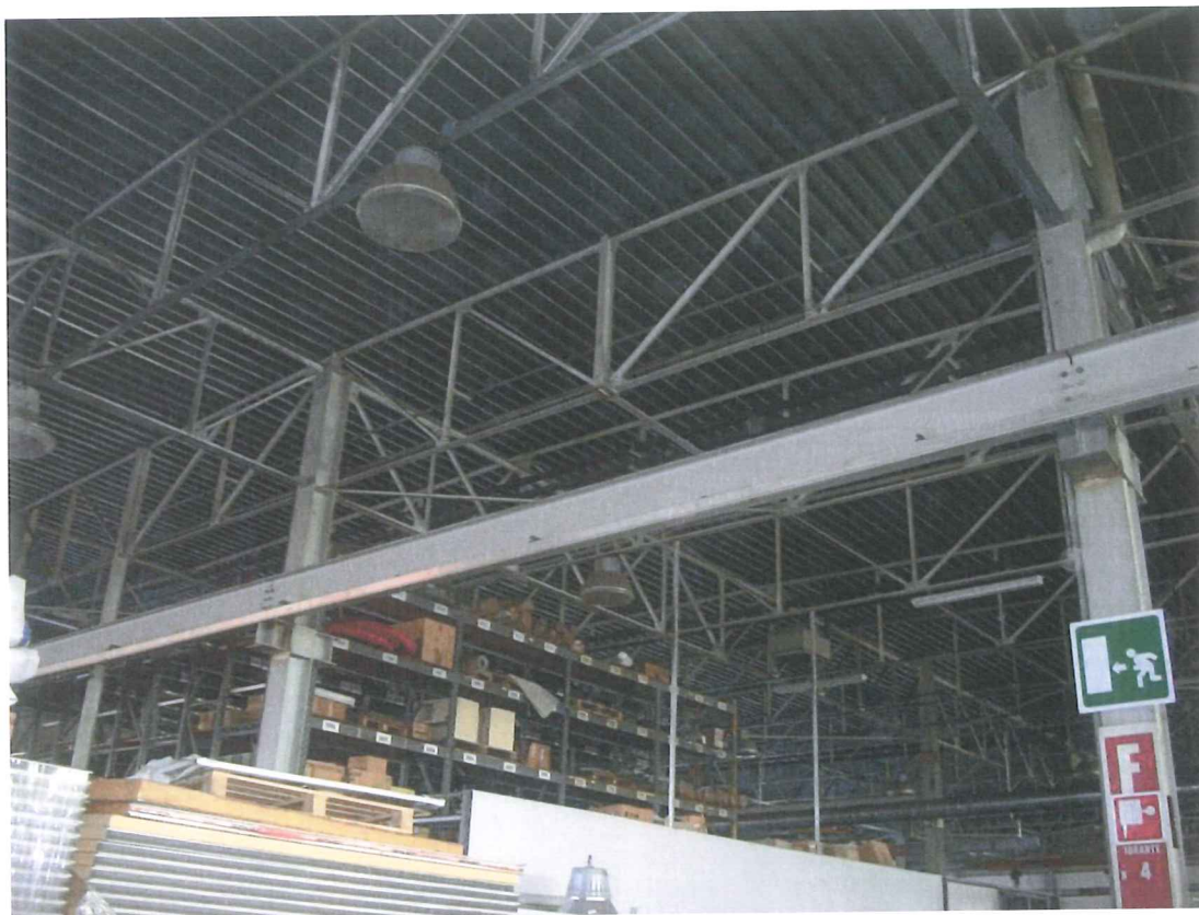
Foto 17 – Visione interna del laboratorio
