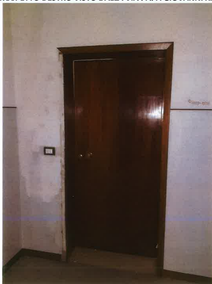
PORTA INGRESSO APPARTAMENTO
