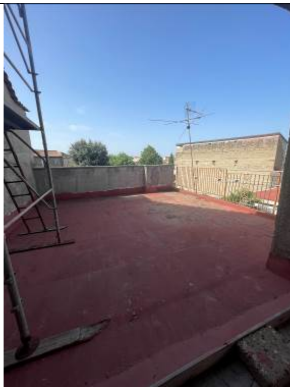
Fotografia n. 7 _ Terrazzo al piano secondo (a sinistra si nota la scala in ferro di accesso al terzo piano)
