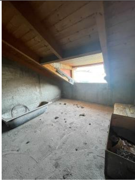
Fotografia n. 17 _ Vano al terzo piano
