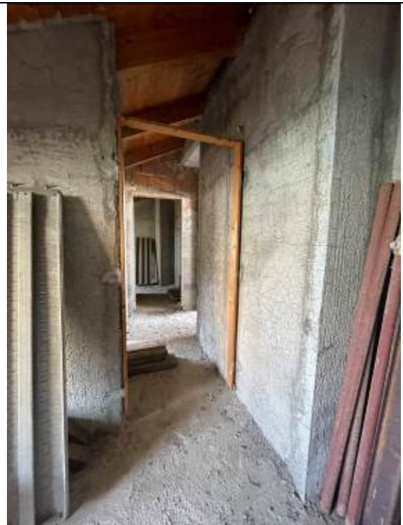
Fotografia n. 16 _ Collegamento tra vani al terzo piano
