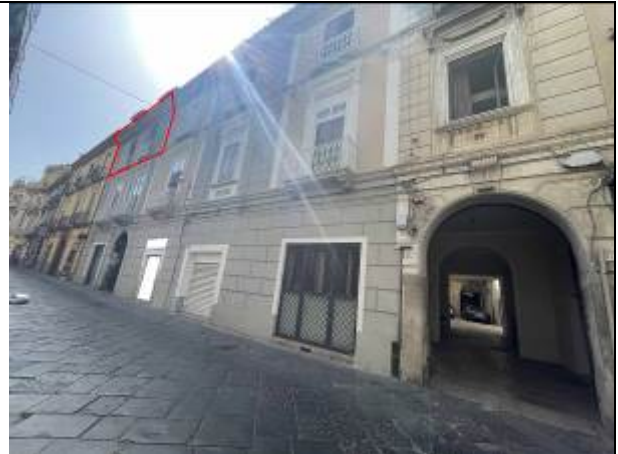
Fotografia n. 2 _ Prospetto del fabbricato su via Gramsci – vista ovest/est
