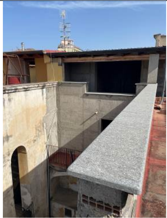
Fotografia n. 10 _ Affaccio della loggia al terzo piano
