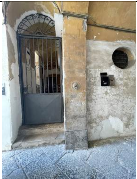
Fotografia n. 4 _ Ingresso alla scala comune
