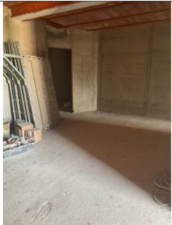
Fotografia n. 12 _ Vano di ingresso al piano secondo
