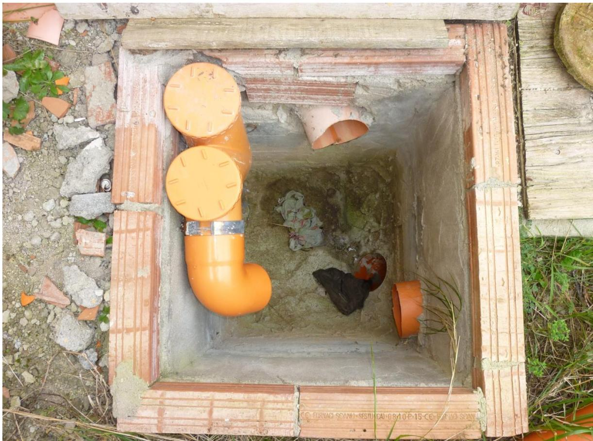
fotografia n. 55 - pozzetto terminale acque nere.
