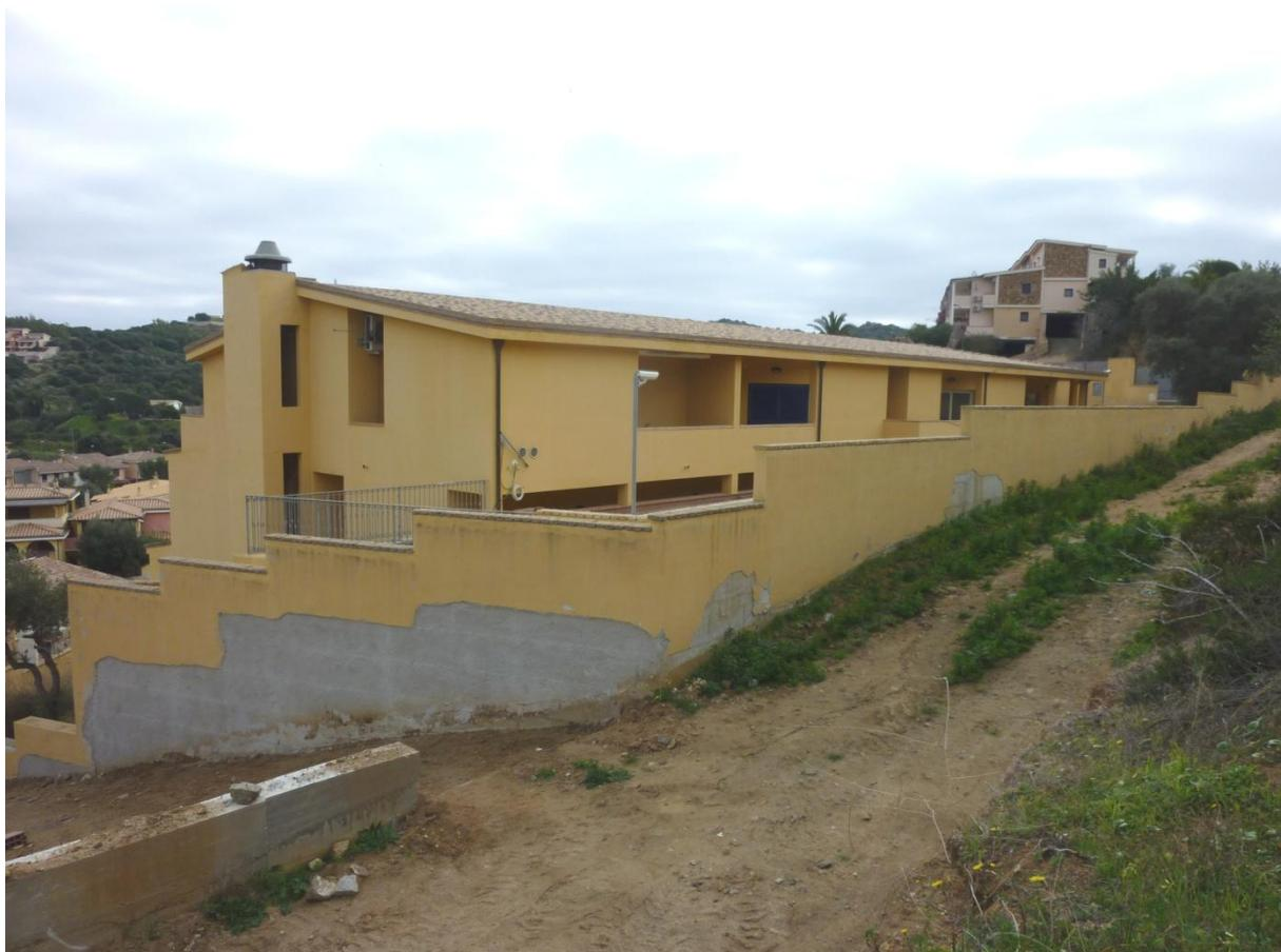
fotografia n. 6 - veduta d'angolo dell'edificio da NW. Si nota il torrino di aspirazione impianto di aerazione forzata.
