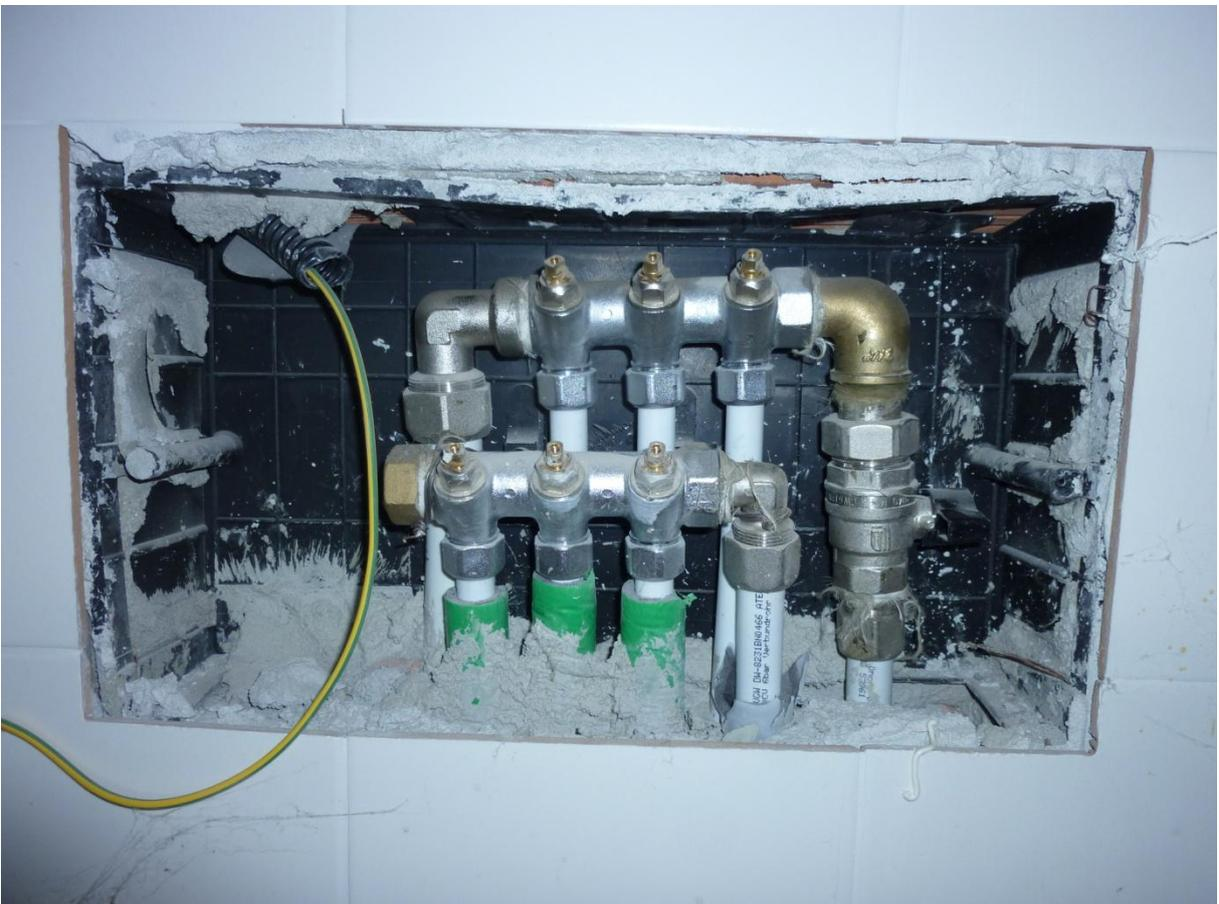
fotografia n. 54 - centralina tipo di distribuzione idrica acqua calda/fredda nei servizi igienici.
