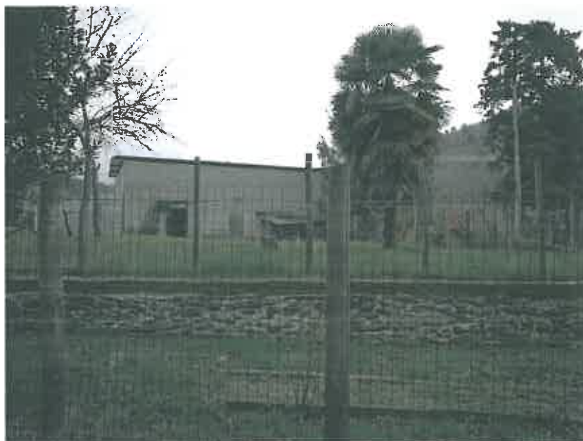
Fabbricato part.192 vista laterale
