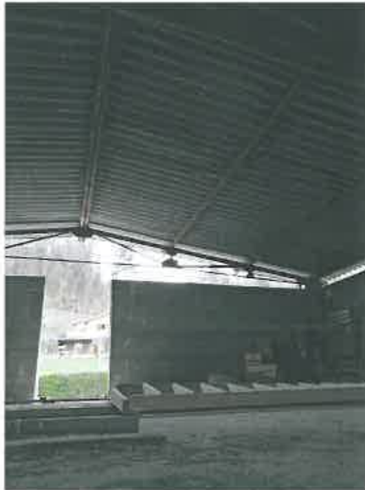
Piano primo fabbricato e vista tettoia copertura
