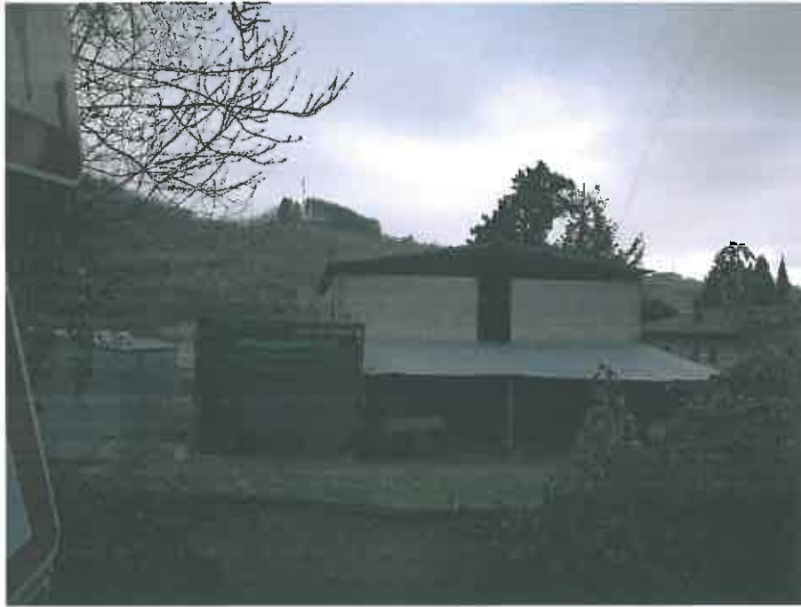
Fabbricato part.192 vista da viabilità- presenza manufatti in aderenza
