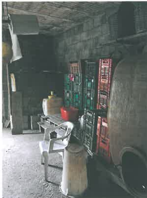
Particolare vano piano terra fabbricato
