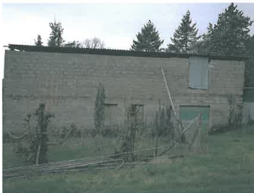
Fabbricato part.192 altra vista laterale
