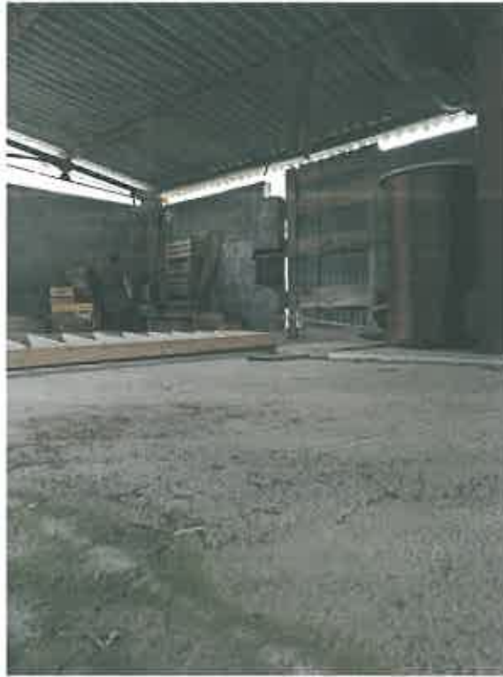
Piano primo fabbricato con copertura
