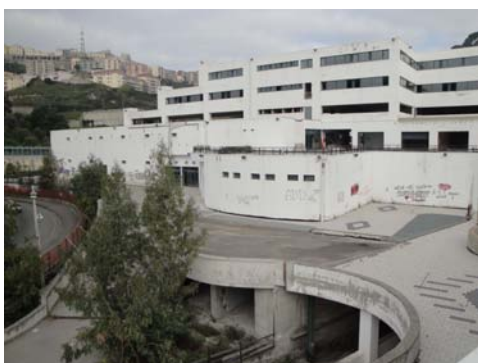
Foto 19 - Prospetto viale Brutium
