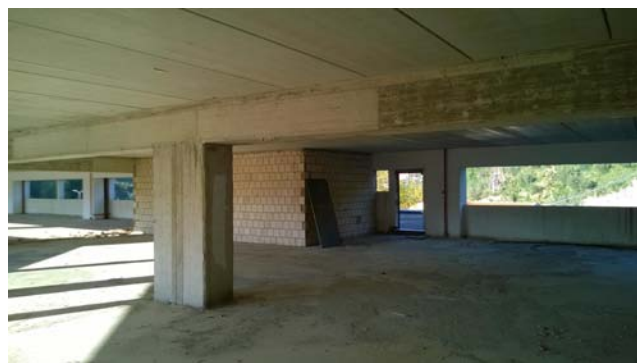
Foto 58 - LOTTO 5 - Piano 2° - sub.466
