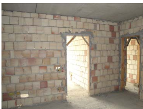
Foto 73 - LOTTO 6 - Piano 4° - sub.204
