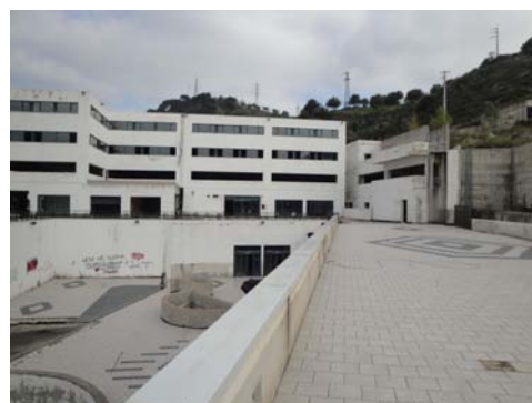
Foto 20 - Terrazzo piano primo
