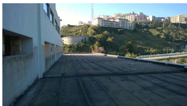
Foto 64 - LOTTO 5 - Piano 2° - sub.466
