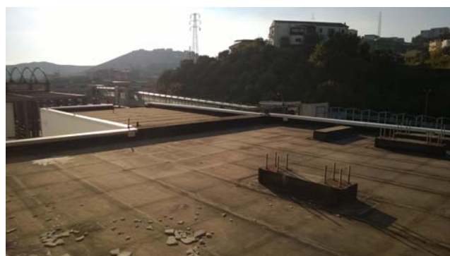
Foto 62 - LOTTO 5 - Piano 2° - sub.466
