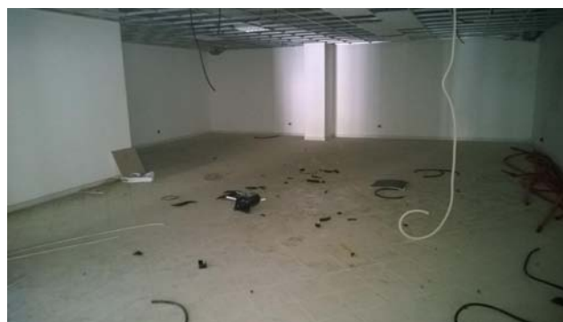
Foto 54 - LOTTO 4 - Piano 1° - sub.256
