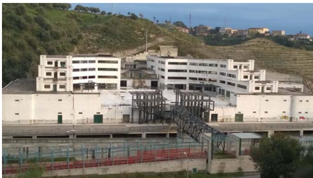
Foto 1 - Prospetto lato Musofalo
