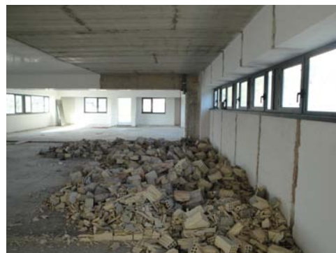
Foto 70 - LOTTO 6 - Piano 4° - sub.219
