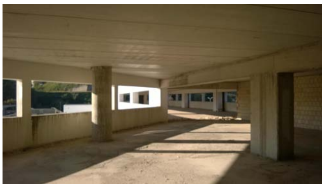
Foto 57 - LOTTO 5 - Piano 2° - sub.466
