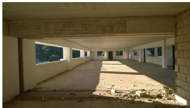
Foto 60 - LOTTO 5 - Piano 2° - sub.466
