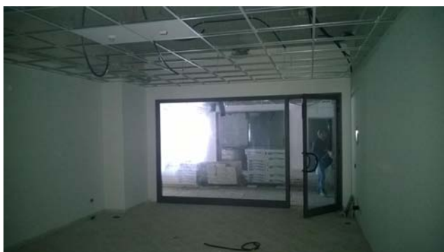
Foto 53 - LOTTO 4 - Piano 1° - sub.253
