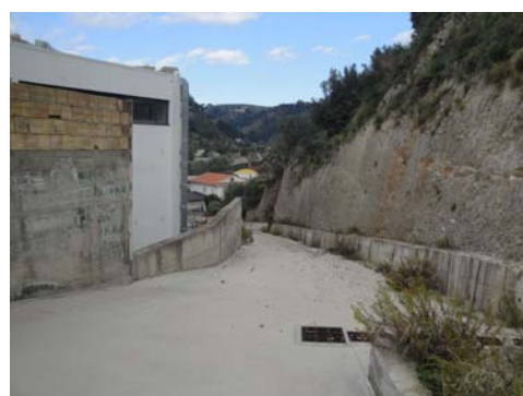
Foto 18 - Prospetto lato monte e strada "Colle Antenna"
