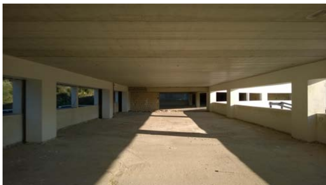
Foto 59 - LOTTO 5 - Piano 2° - sub.466
