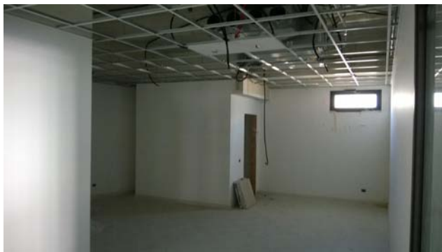
Foto 47 - LOTTO 4 - Piano 1° - sub.106
