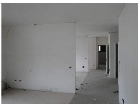
Foto 71 - LOTTO 6 - Piano 4° - sub.201
