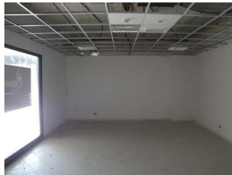
Foto 50 - LOTTO 4 - Piano 1° - sub.233
