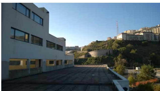
Foto 63 - LOTTO 5 - Piano 2° - sub.466
