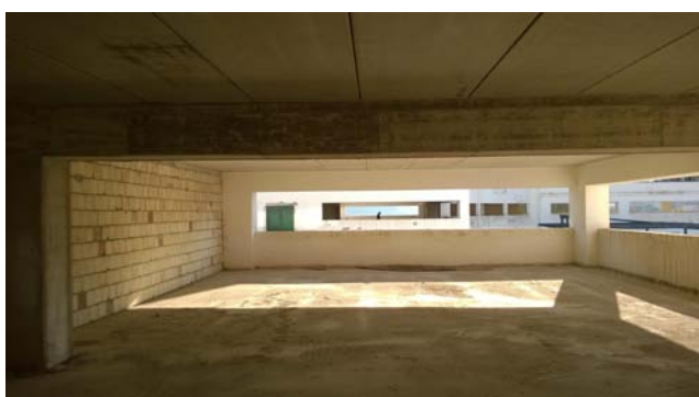
Foto 65 - LOTTO 5 - Piano 2° - sub.467
