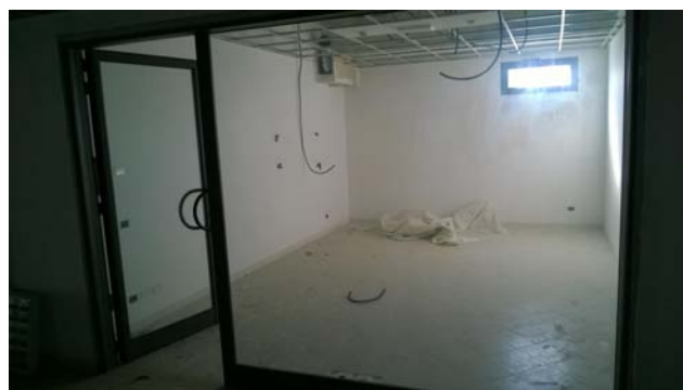
Foto 56 - LOTTO 4 - Piano 1° - sub.277
