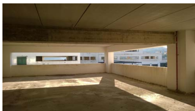
Foto 66 - LOTTO 5 - Piano 2° - sub.467
