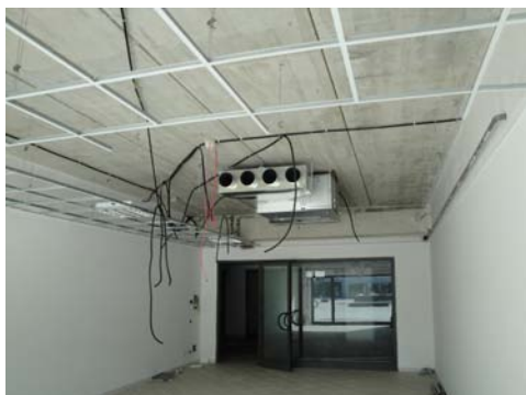
Foto 51 - LOTTO 4 - Piano 1° - sub.242
