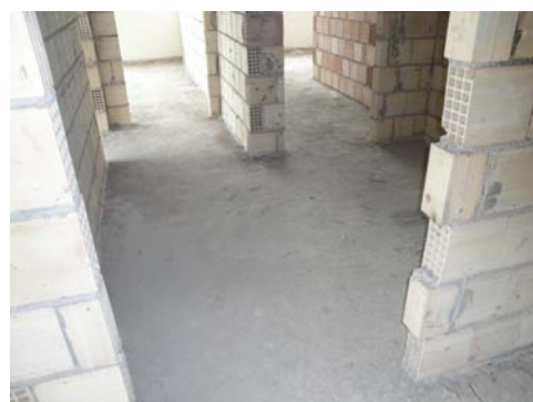
Foto 72 - LOTTO 6 - Piano 4° - sub.202
