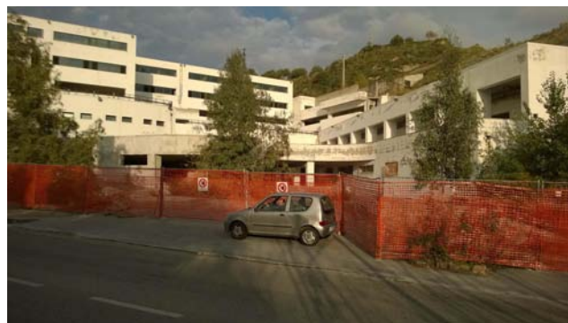
Foto 6 - Prospetto lato viale Brutium
