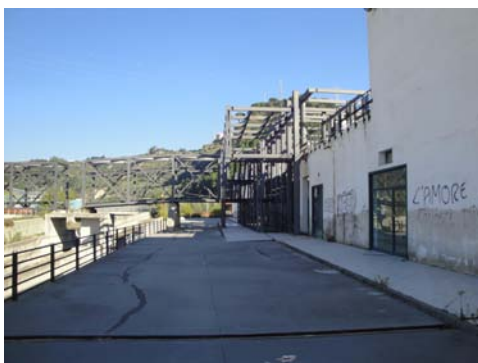
Foto 11 - Prospetto lato Musofalo
