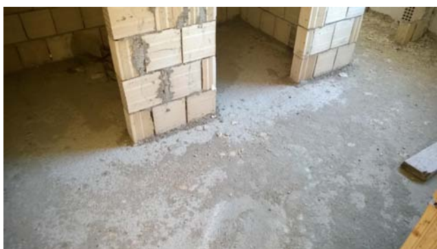
Foto 61 - LOTTO 5 - Piano 2° - sub.466
