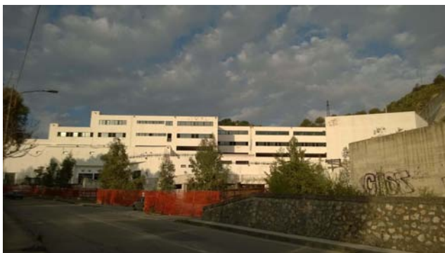
Foto 5 - Prospetto lato viale Brutium
