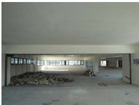
Foto 69 - LOTTO 6 - Piano 4° - sub.219
