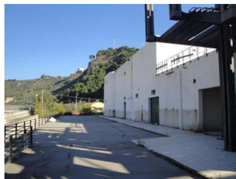
Foto 12 - Prospetto lato Musofalo
