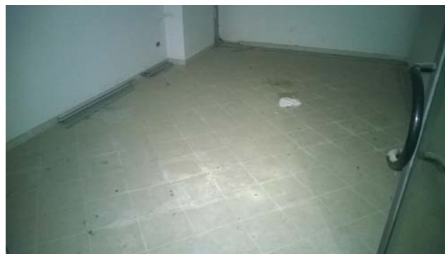
Foto 52 - LOTTO 4 - Piano 1° - sub.251
