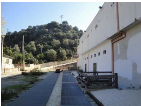
Foto 13 - Prospetto lato Funicolare
