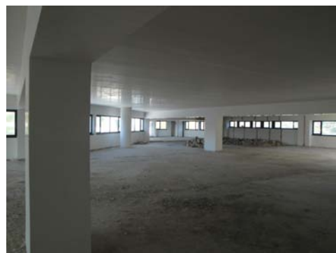
Foto 68 - LOTTO 6 - Piano 4° - sub.219
