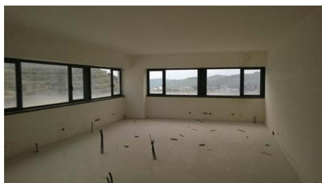
Foto 76 - LOTTO 6 - Piano 4° - sub.221
