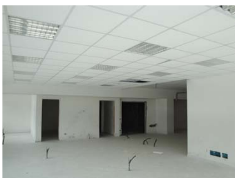
Foto 75 - LOTTO 6 - Piano 4° - sub.205
