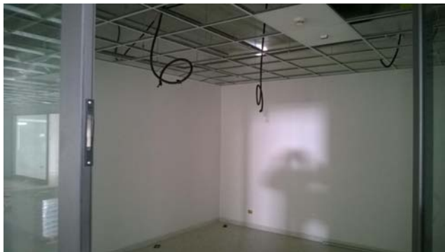
Foto 49 - LOTTO 4 - Piano 1° - sub.141
