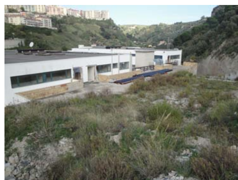
Foto 16 - Prospetto lato monte
