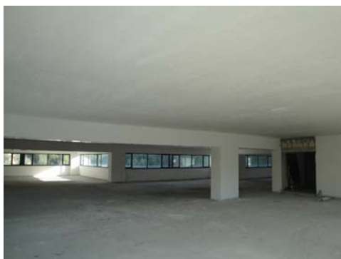
Foto 67 - LOTTO 6 - Piano 4° - sub.219
