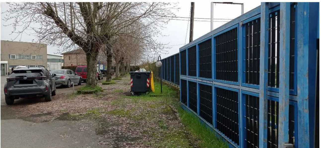
45-Vista nord ingresso verso recinione interna
