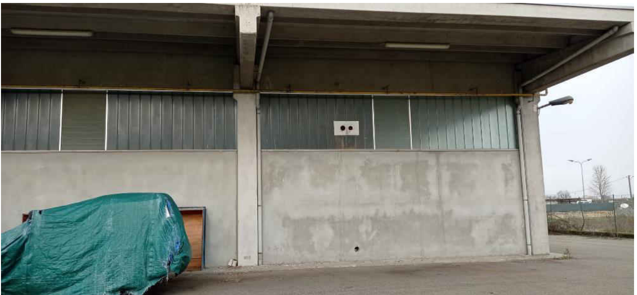
21-Vista esterna lato sud ovest
