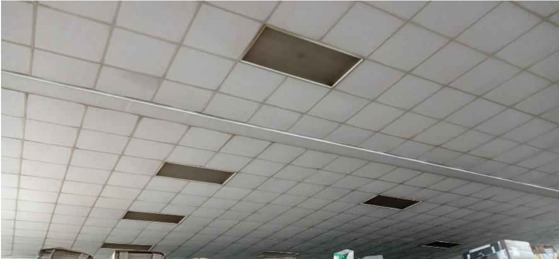
71-controsoffitto capannone (porzione verso terreni)
