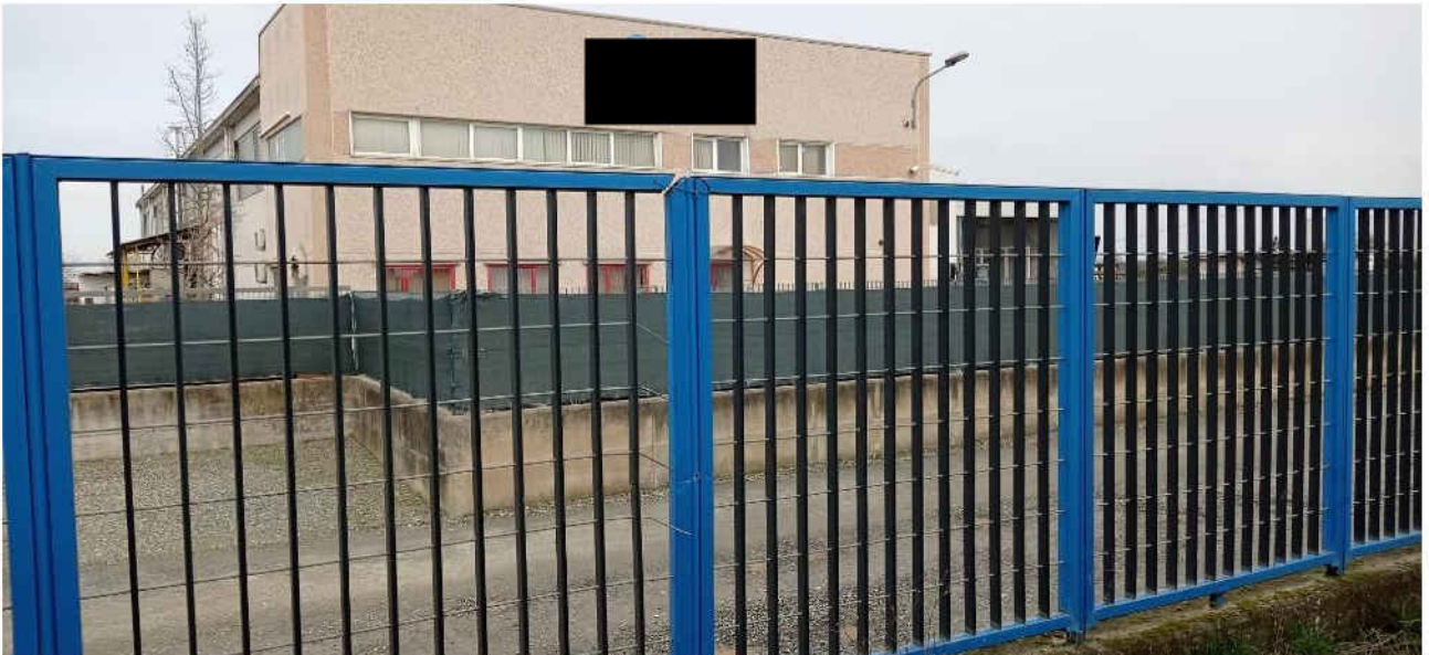
14- Vista recinzione verso proprietà confinante lato est
