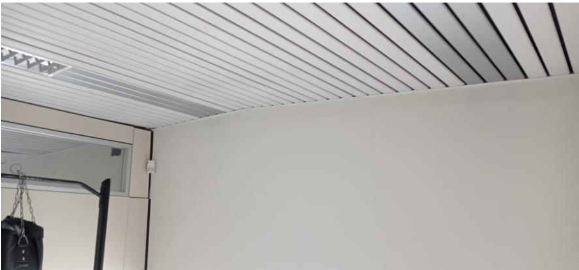
59-dettaglio controsoffitto piano primo
