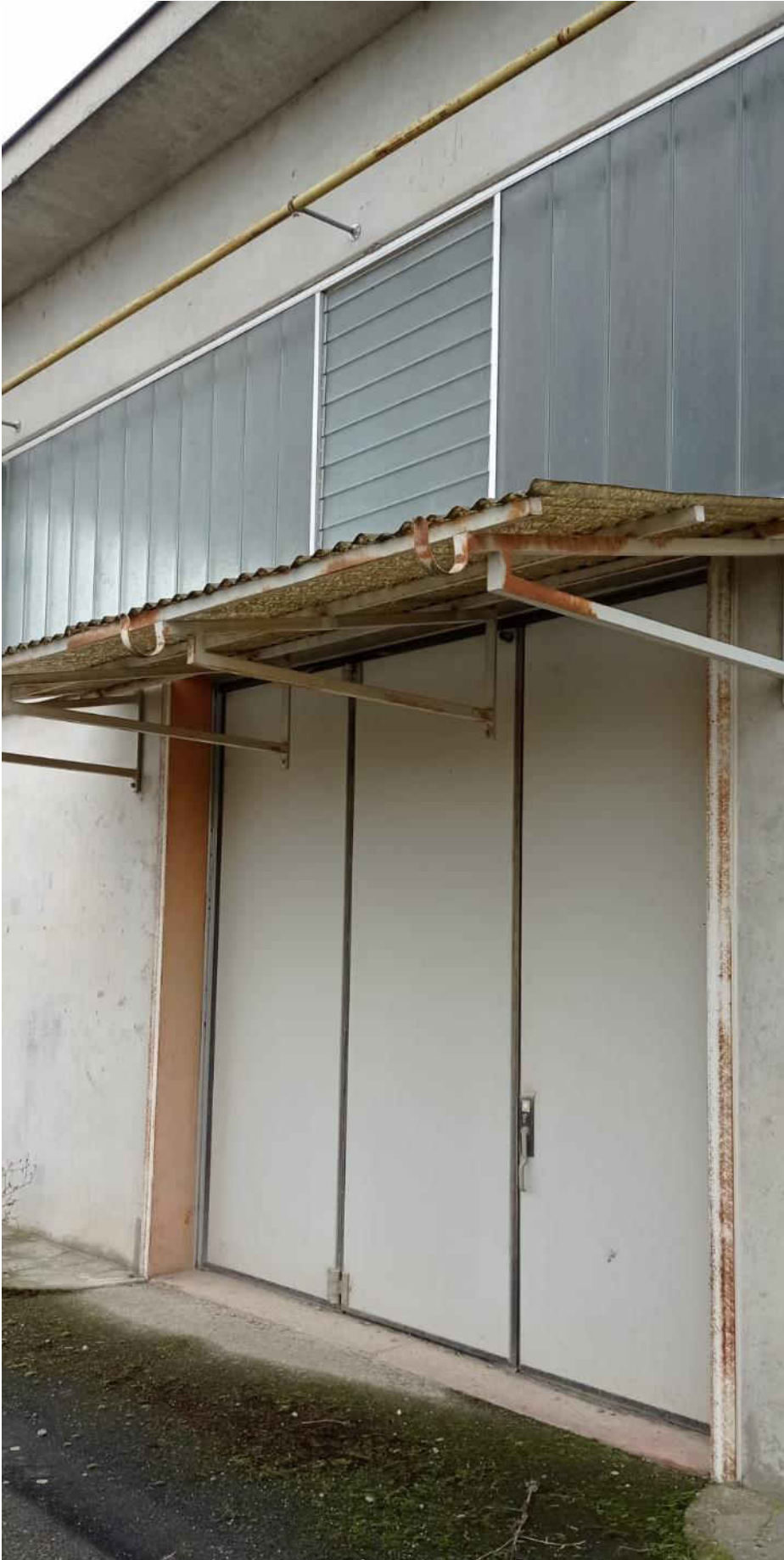
19- Vista esterna pensilina capannone lato est
