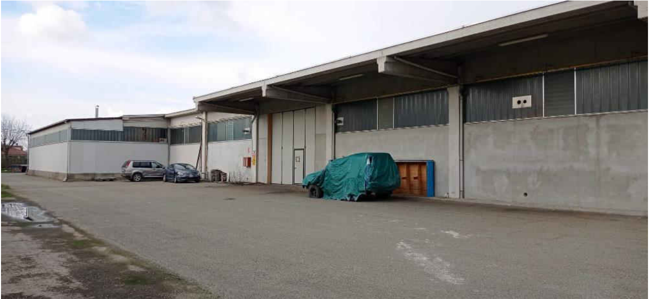
11- Vista esterna capannone lato sud ovest interno
