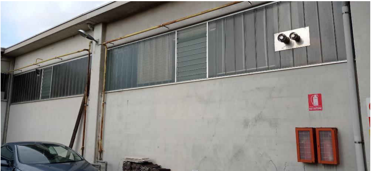
6- Vista esterna capannone
