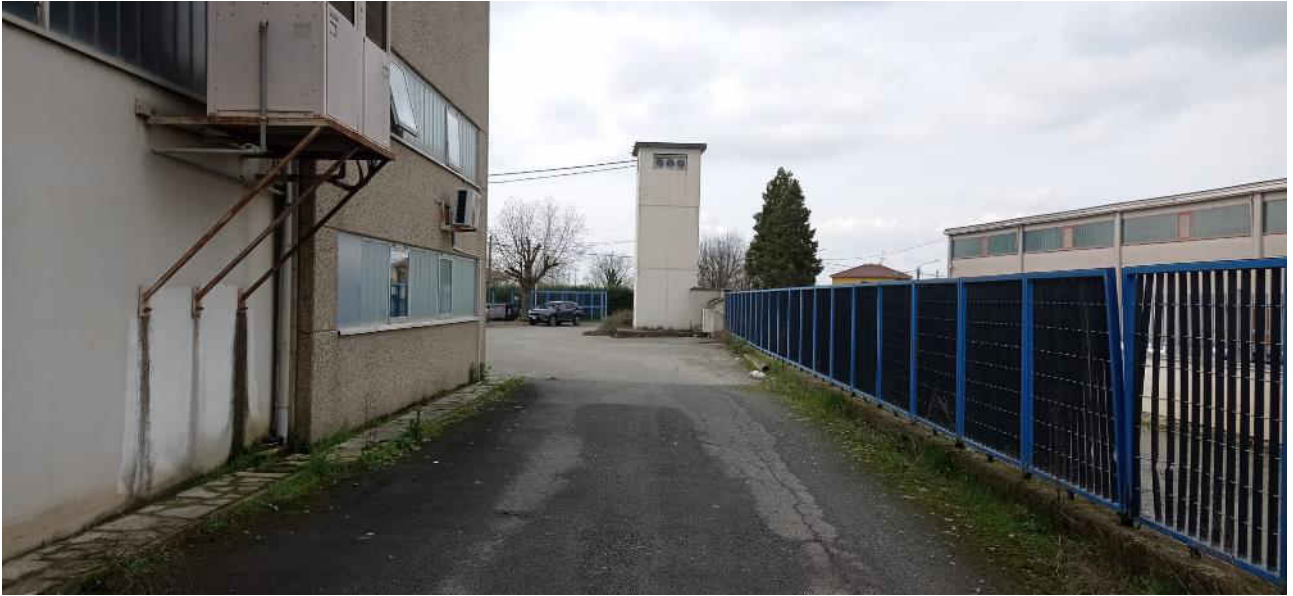
1-Vista esterno fabbricato
