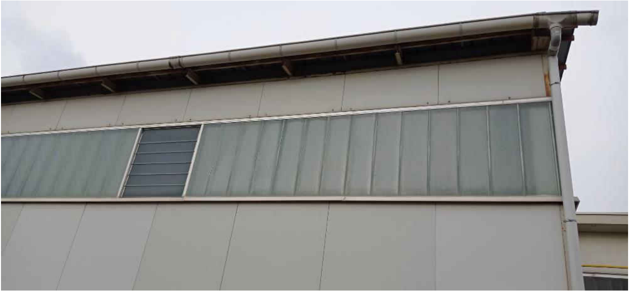
5- Vista esterna capannone
