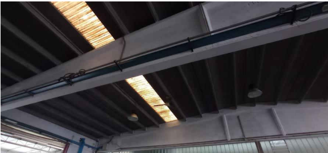
90-interno capannone, dettaglio copertura
