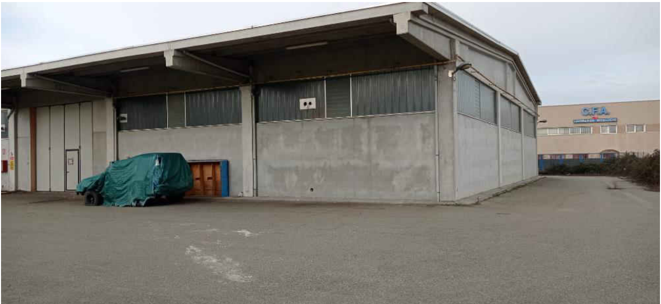
12- Vista esterna interno lato sud ovest
