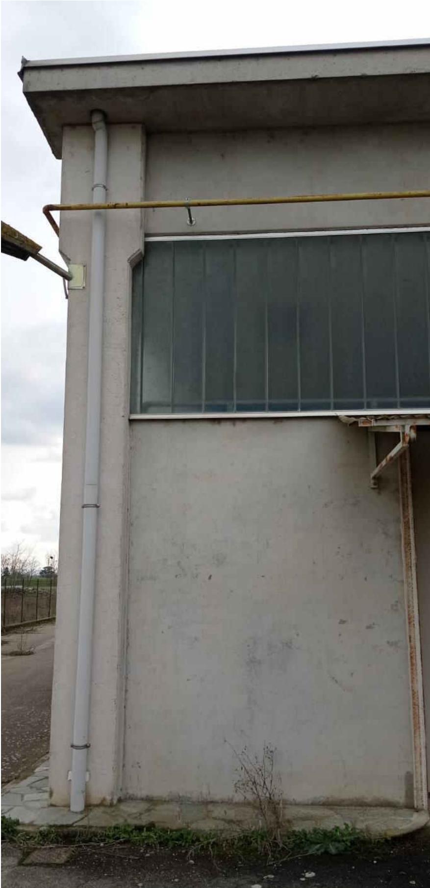
30-Vista esterna lato est
