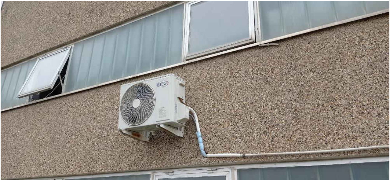
38-Vista esterna lato nord
