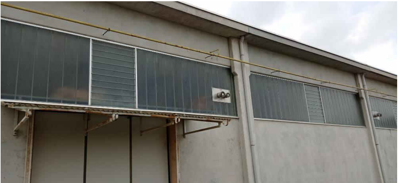
16- Vista esterna pensilina capannone lato est
