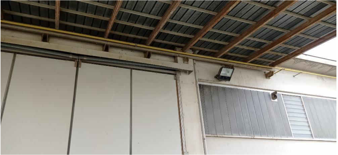
33-Vista esterna lato est
