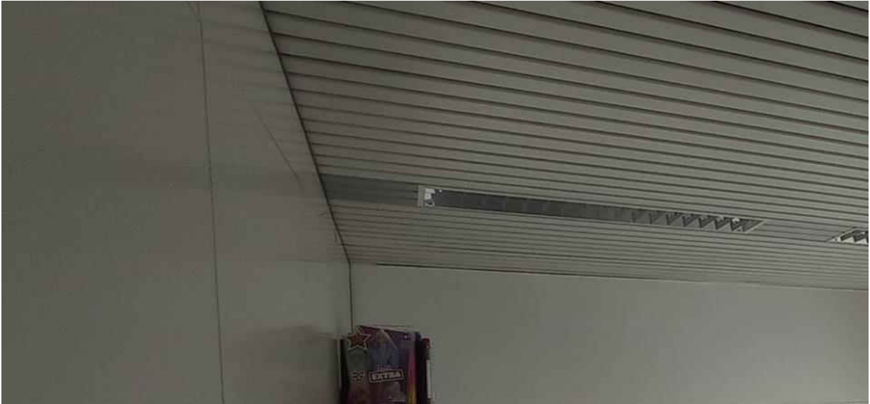
49-particolare ufficio piano primo
