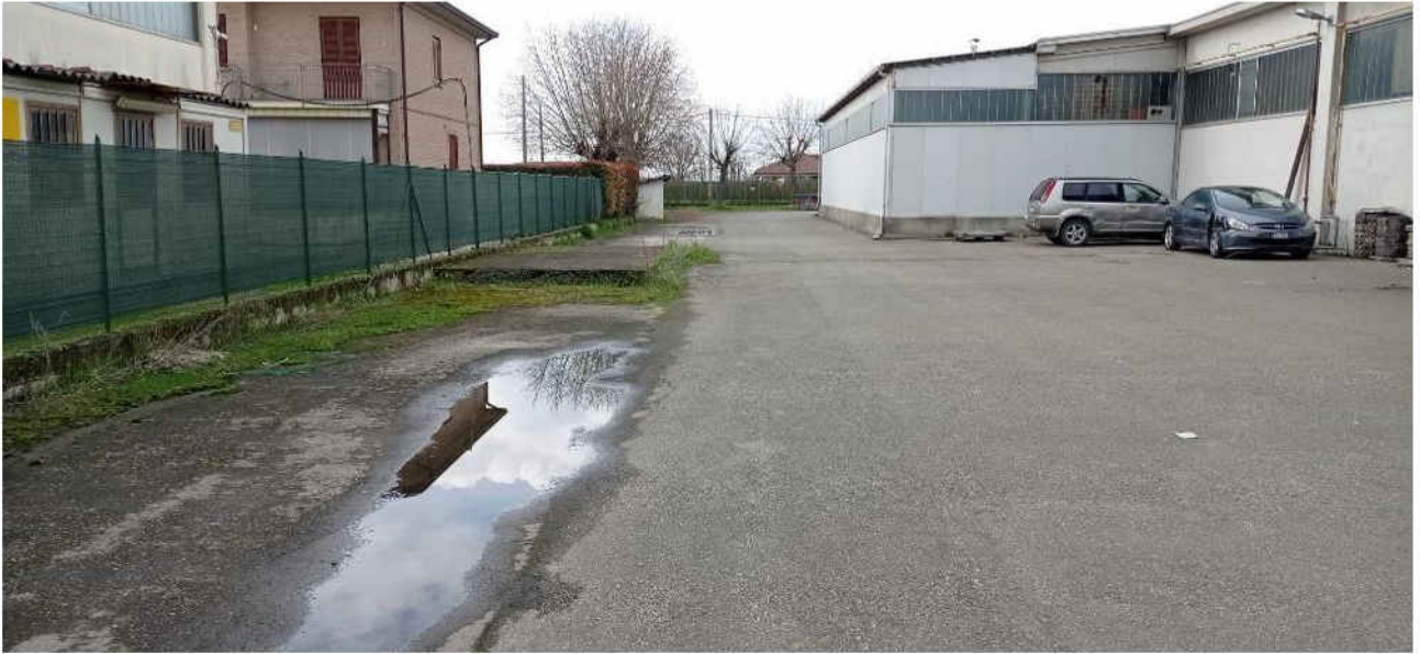
13- Vista esterna capannone lato interno lato sud ovest
