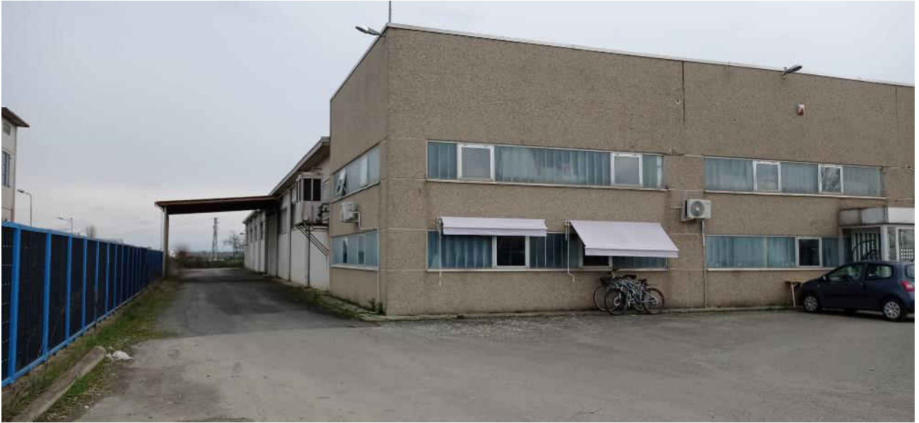
35-Vista esterna lato nord
