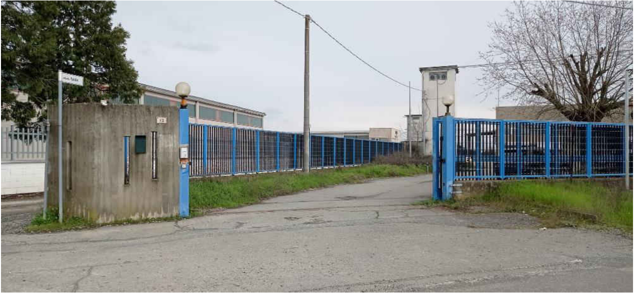
37-Vista esterna lato nord
