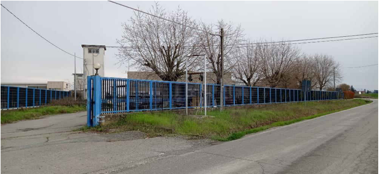
43-Vista nord ingresso verso esterno
