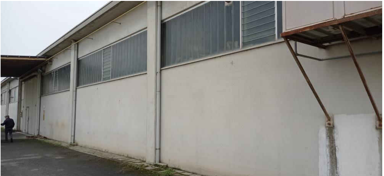
36-Vista esterna lato nord est
