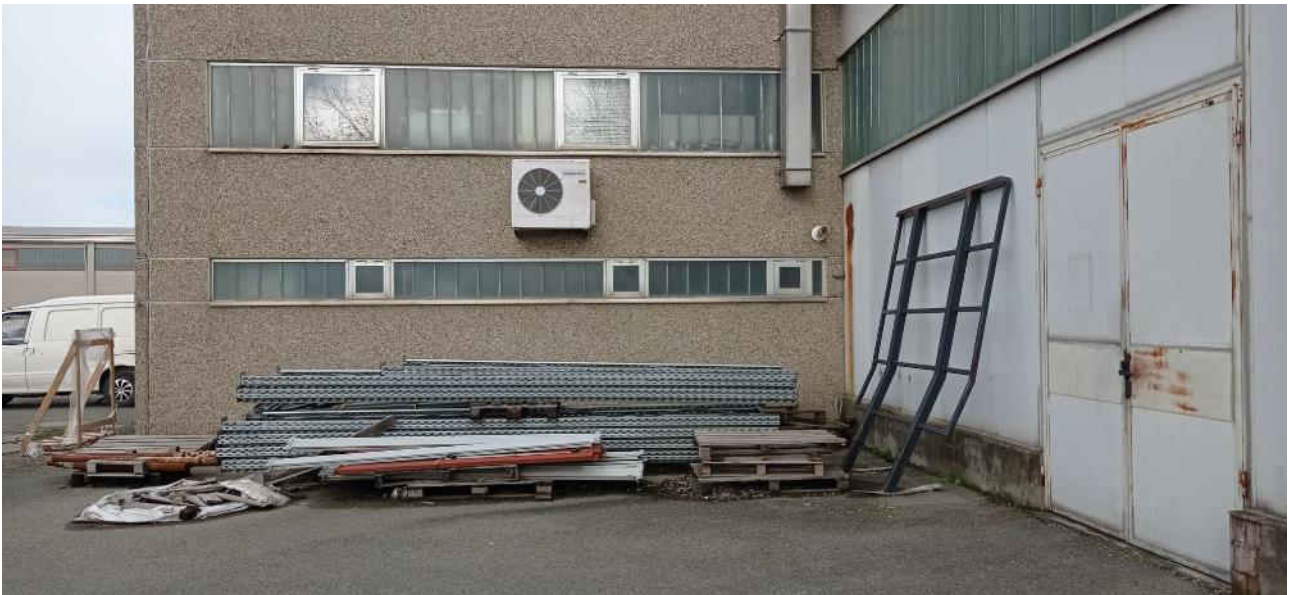
8- Vista esterna capannone
