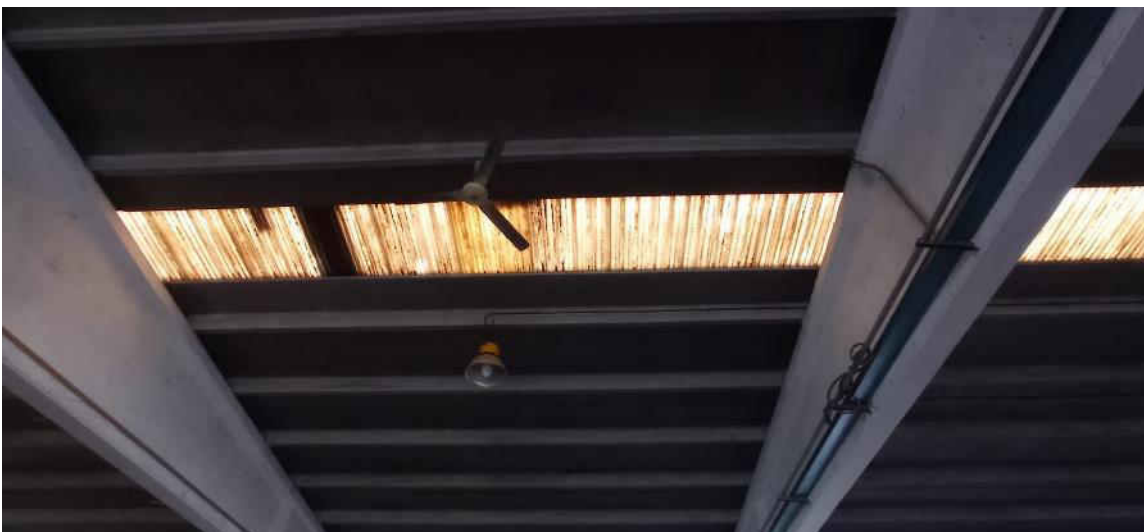
88-interno capannone, dettaglio copertura
