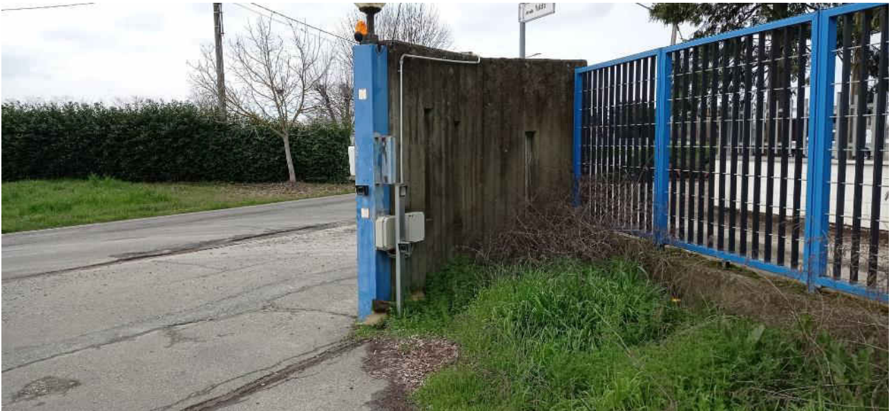
41-Vista nord ingresso verso esterno
