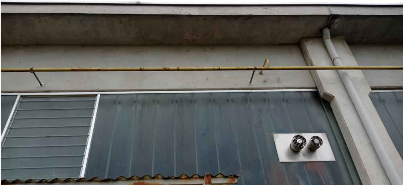
20- Vista esterna capannone lato est
