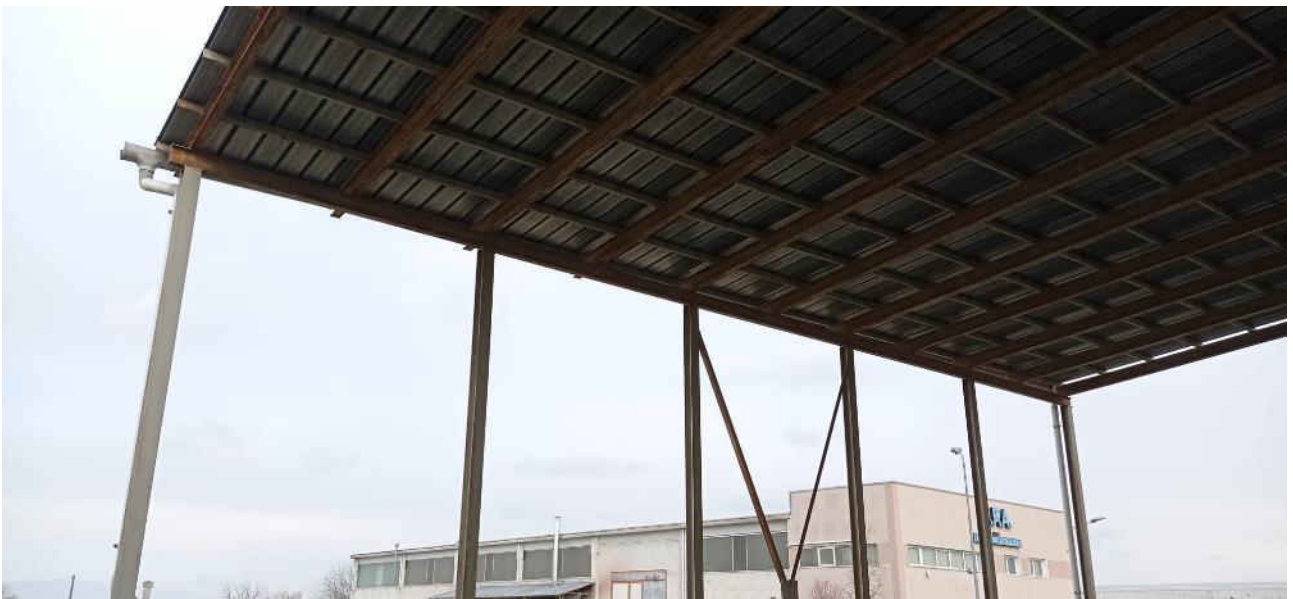
32-Vista esterna lato est
