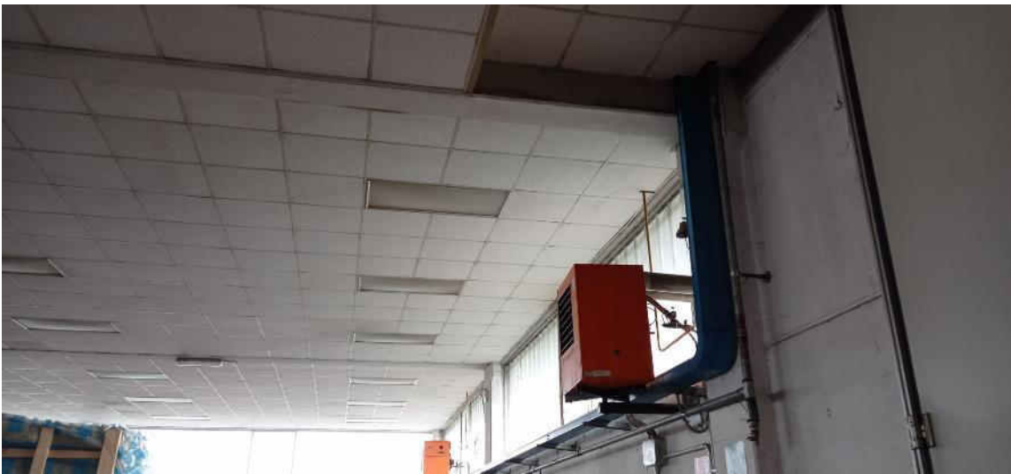
72-controsoffitto capannone (porzione verso terreni)
