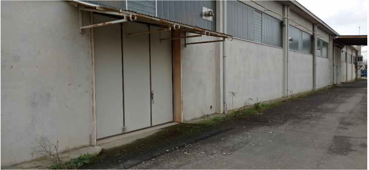
24-Vista esterna lato est pensilina
