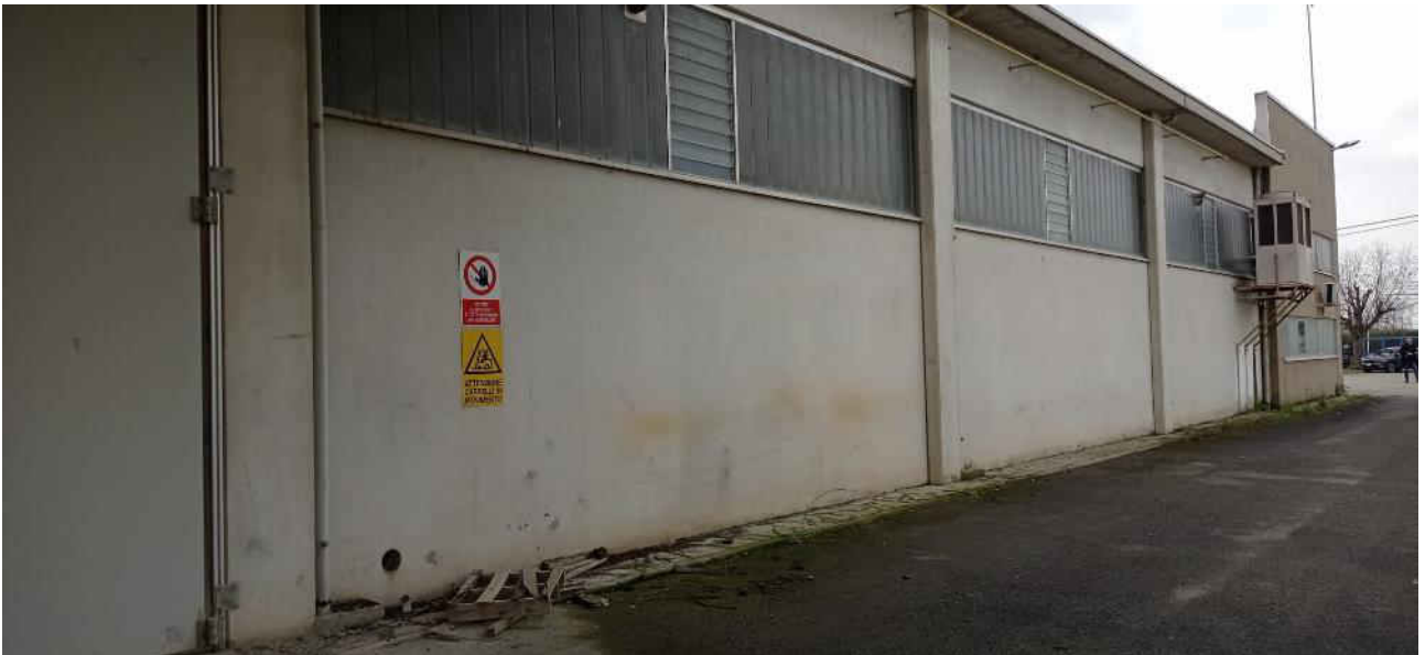
34-Vista esterna lato est
