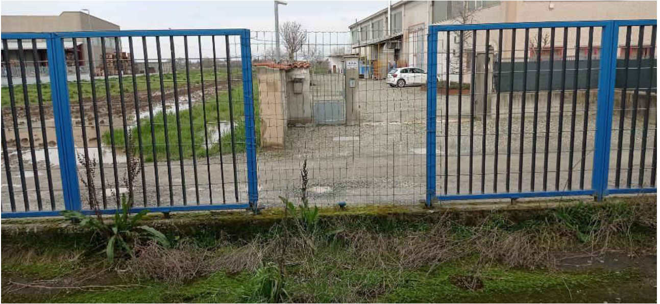
15- Vista recinzione verso proprietà confinante lato est
