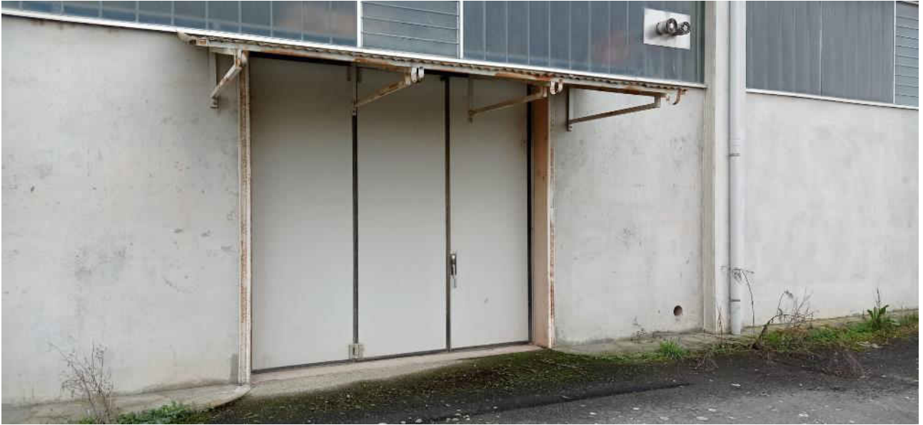
17- Vista esterna pensilina capannone lato est
