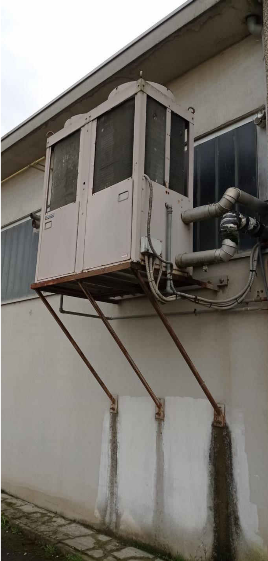
39-Vista esterna capannone
