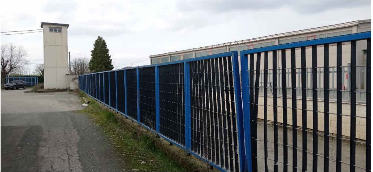
40-Vista recinzione verso ingresso
