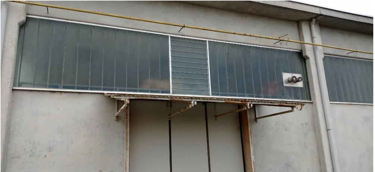
25-Vista esterna lato est pensilina
