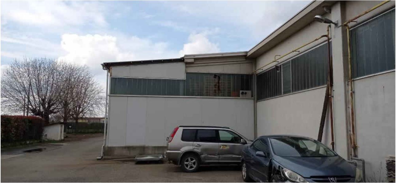
7- Vista esterna capannone
