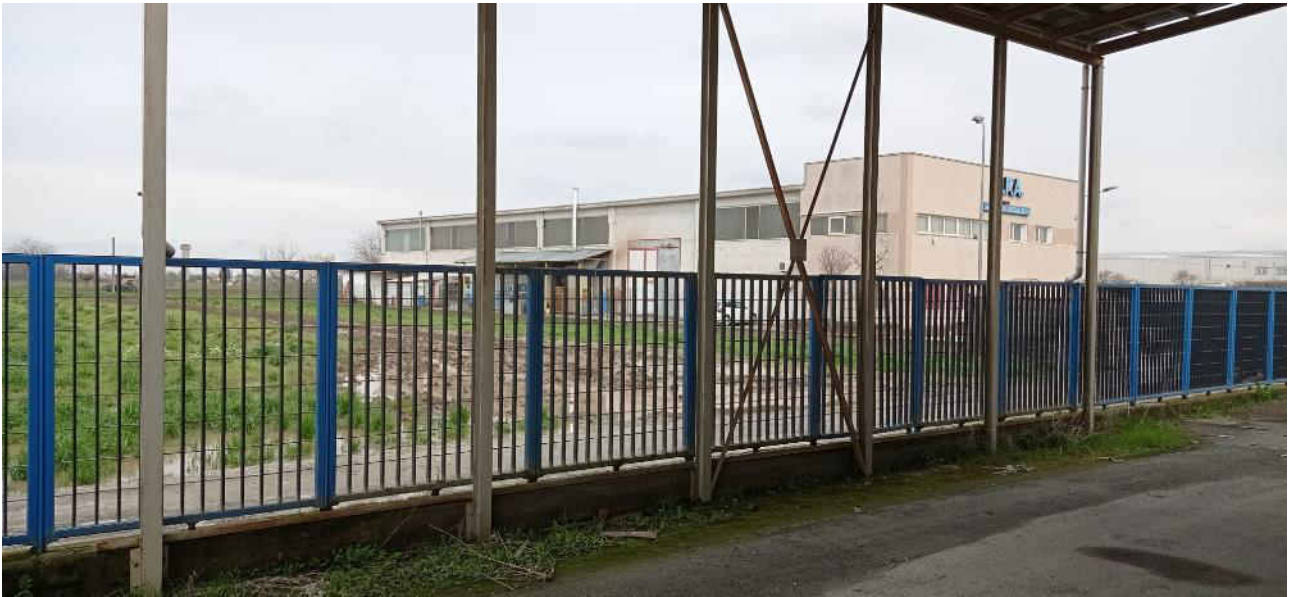
31-Vista esterna lato est
