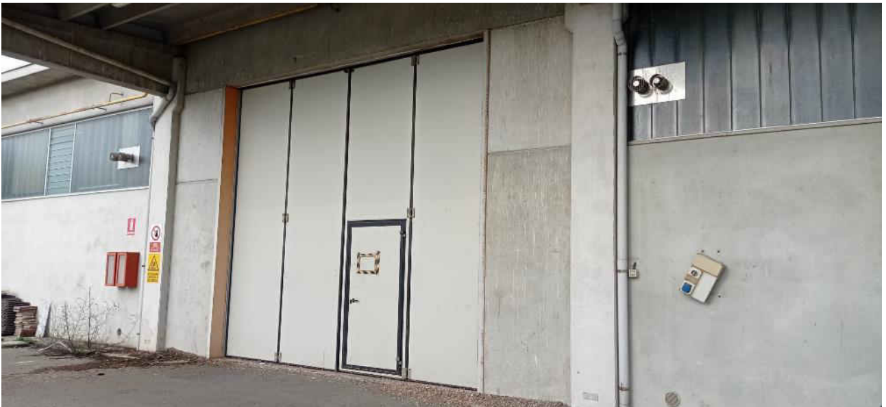
4- Vista pensilina capannone
