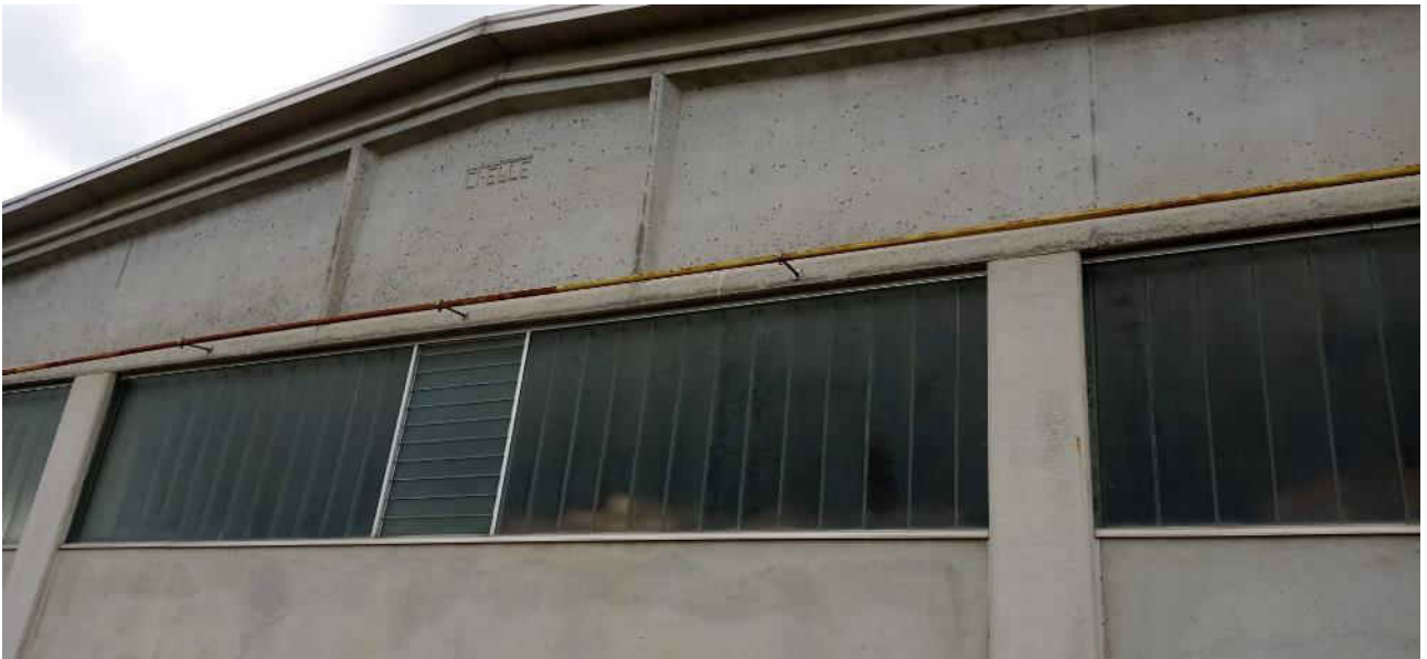
18- Vista esterna capannone copertura lato sud
