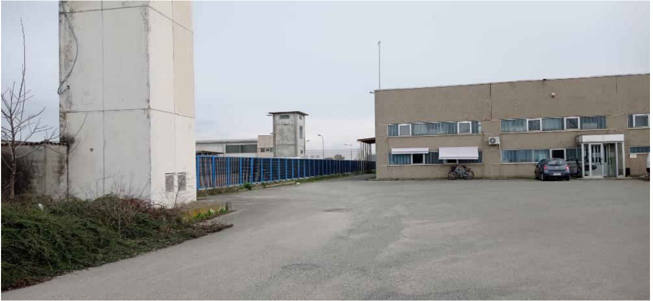
42-Vista nord ingresso verso capannone
