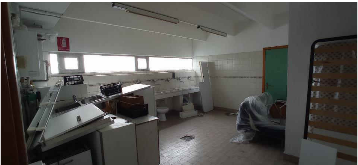
52-spogliatoio piano terreno
