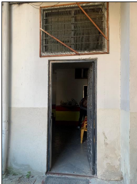
Foto 6: vista degli esterni del locale commerciale pignorato al civico 54. L'accesso avviene per il tramite di portone metallico ad apertura manuale.
