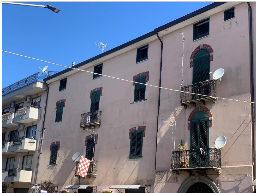
Foto 2-3: Viste degli esterni del fabbricato condominiale “Palazzo Chiancone”, fabbricato conformato ad “L”, con struttura intelaiata in c.a., muratura in laterizio e copertura piana a doppia falda spiovente. Lo stabile condominiale è delimitato sul prospetto posteriore da spazi pertinenziali di passaggio e parcheggio privato.
