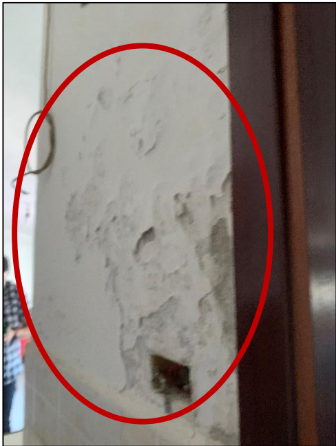
Foto 25-26-27-28: Dettagli dei fenomeni infiltrativi e delle porzioni di intonaco distaccato presenti nel disimpegno e sul soffitto del bagno.
