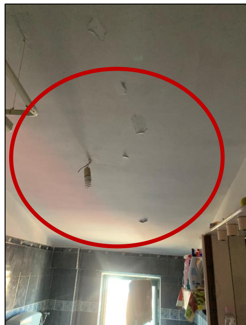
Foto 25-26-27-28: Dettagli dei fenomeni infiltrativi e delle porzioni di intonaco distaccato presenti nel disimpegno e sul soffitto del bagno.
