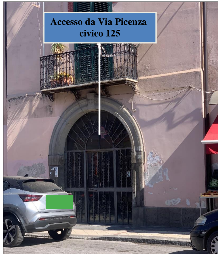
Foto 4: Ulteriori vista di dettaglio dell' accesso tramite portone comune al civico 125 di Via Picenza . Il portone è metallico con architrave ad arco a tutto sesto.
