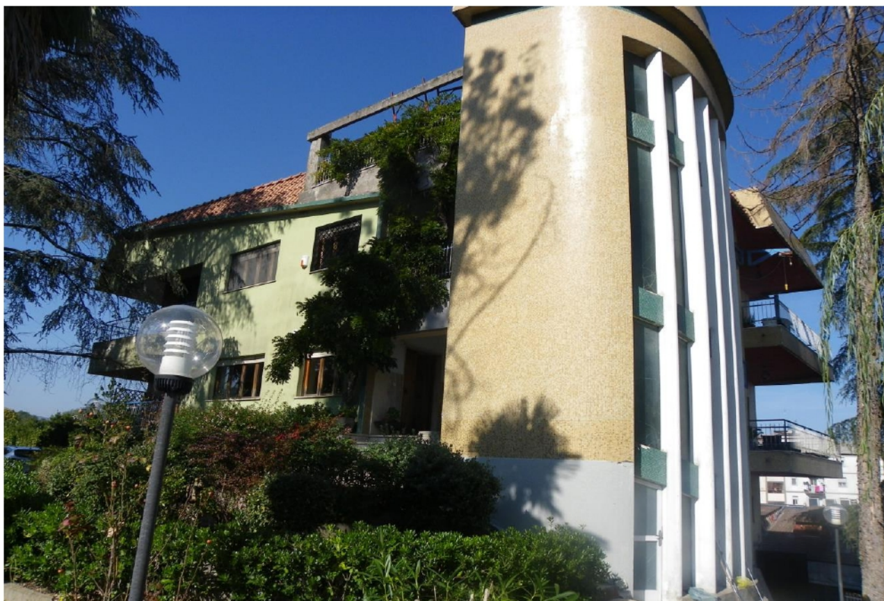
VISTA ESTERNA - LOTTO N. 2 e 3
