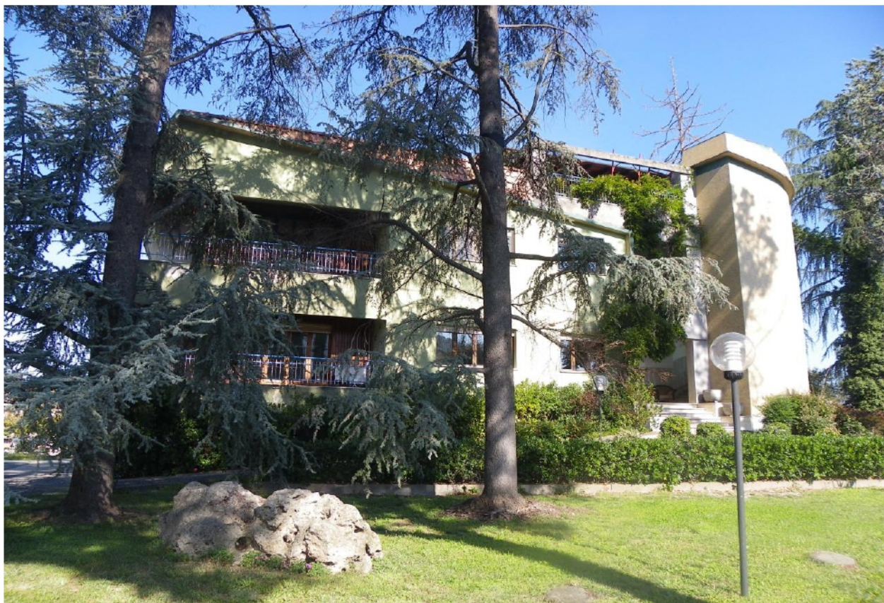
VISTA ESTERNA - LOTTO N. 2 e 3
