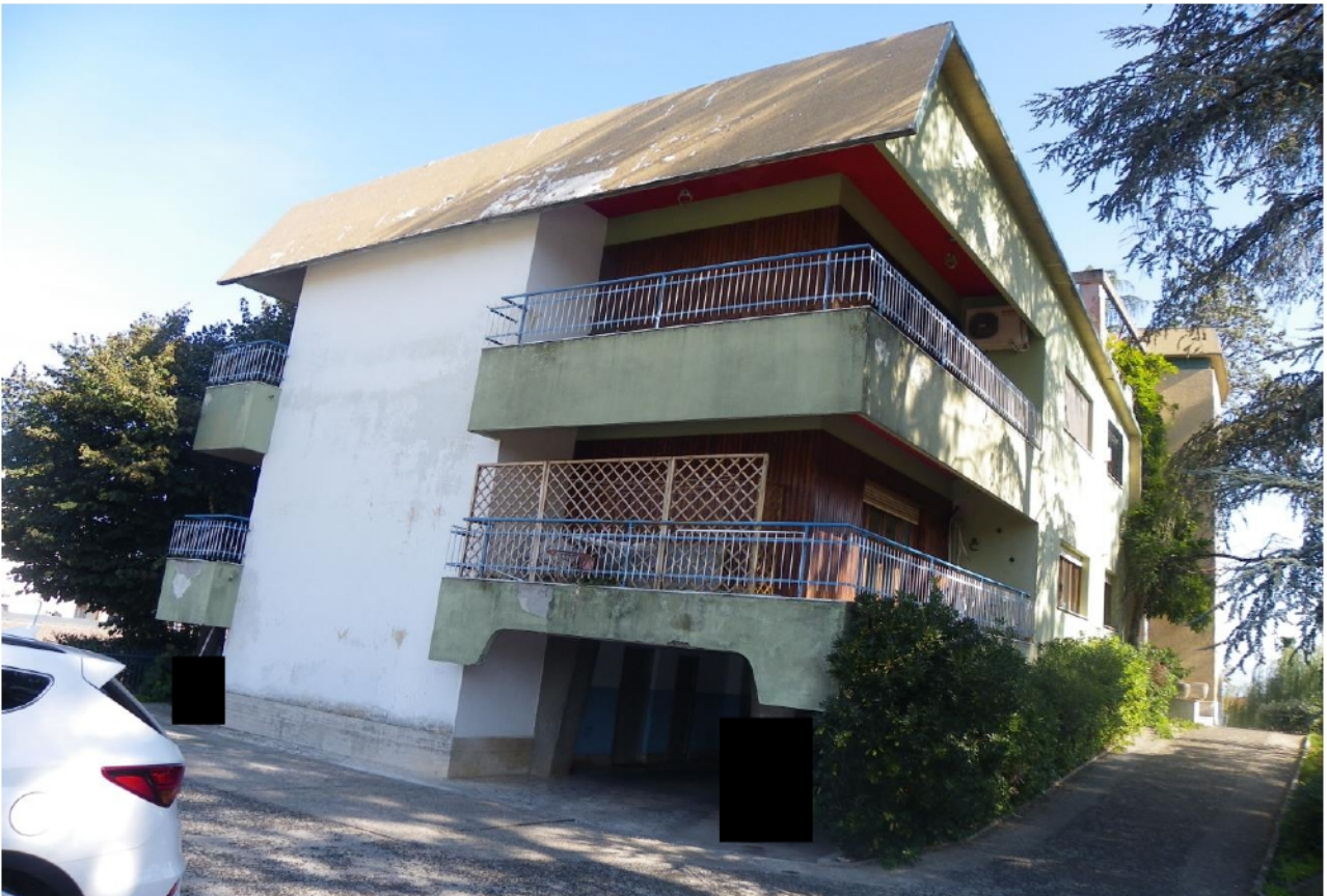
VISTA ESTERNA - LOTTO N. 2 e 3
