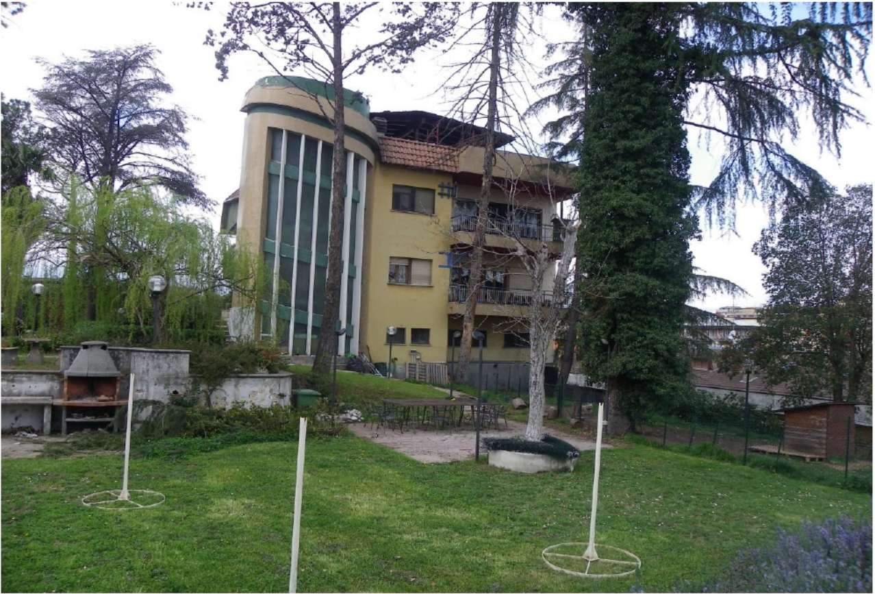
VISTA ESTERNA - LOTTO N. 2 e 3
