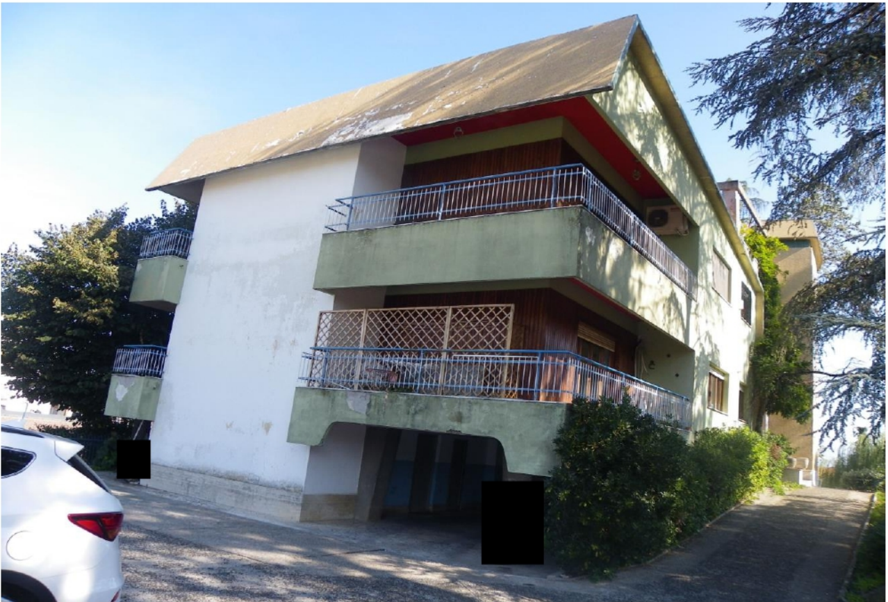
VISTA ESTERNA - LOTTO N. 2 e 3
