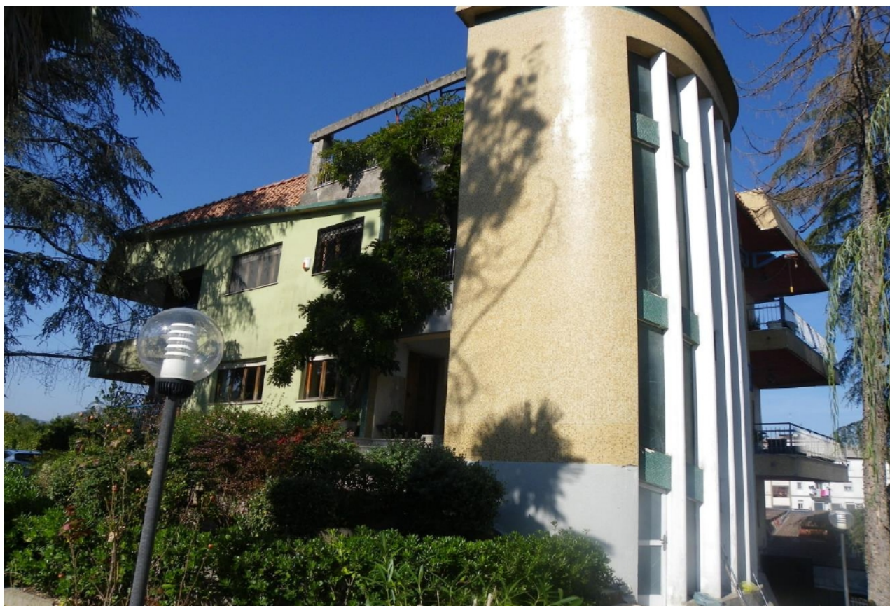
VISTA ESTERNA - LOTTO N. 2 e 3
