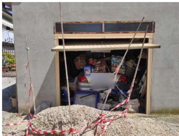
Figura 18 accesso al sub.2
