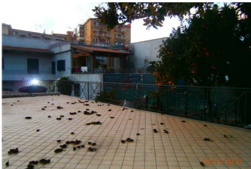
Foto n° 31 Lastrico Solare Immobile P.Ila 110
