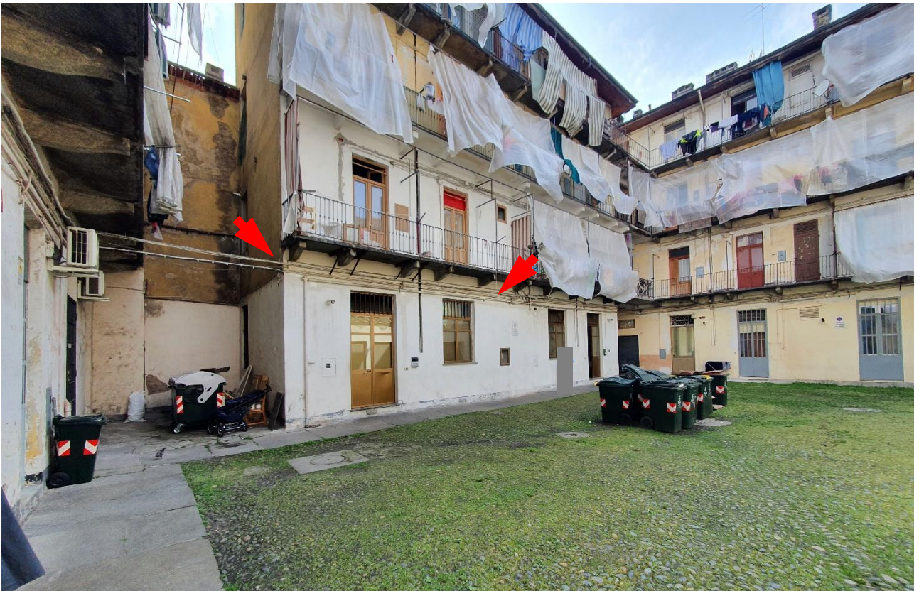
Fig. 2 Vista generale corpo di fabbrica fronte corte con indicazione dell'alloggio
