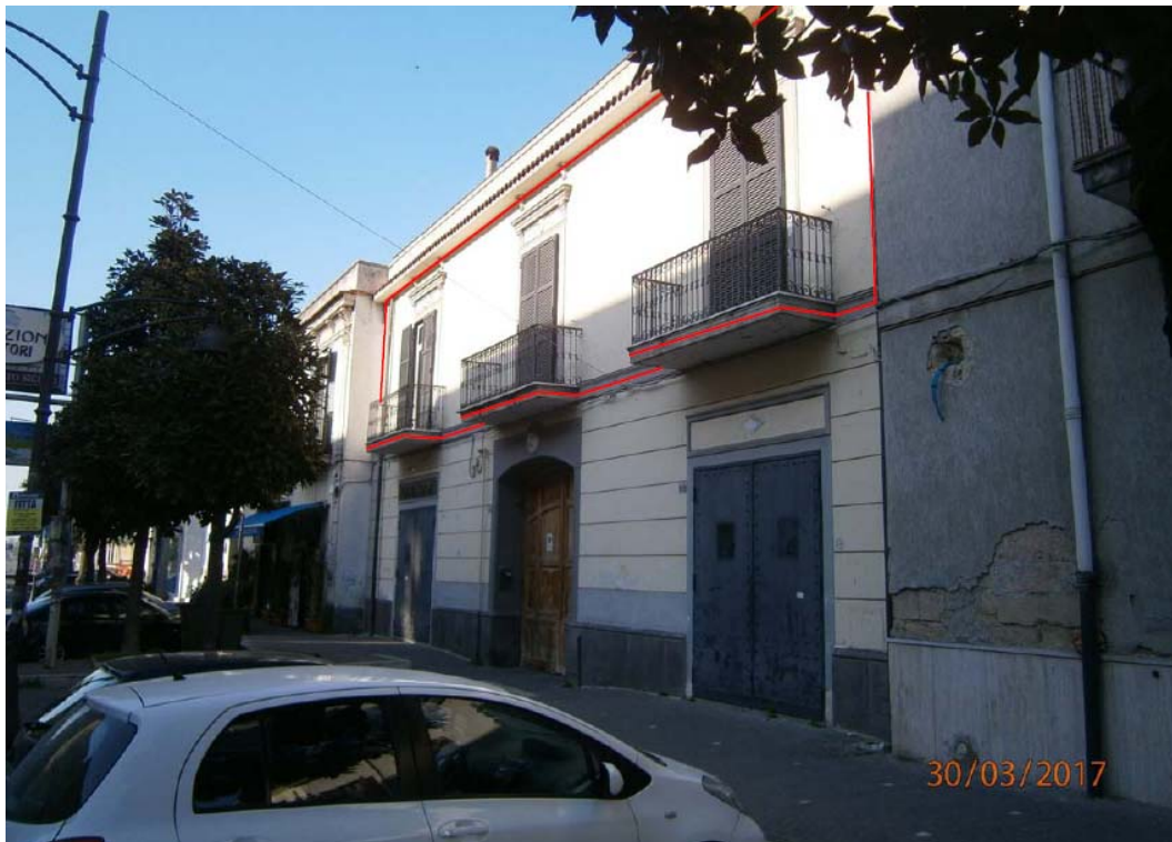
Foto n° 3 Facciata Principale Lato Ovest
