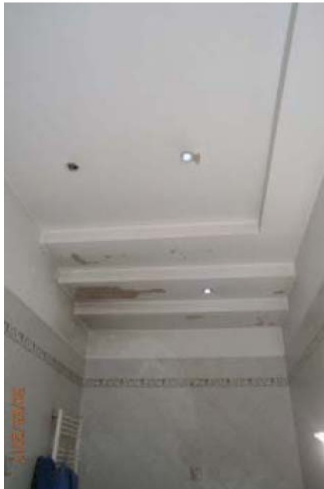
Foto n° 22 Particolare Controsoffitto Bagno.
